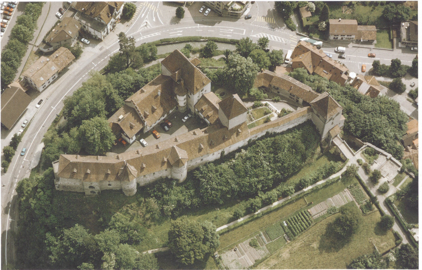
Abb. 9: Burgdorf, Schloss. Im Vordergrund die kiburgische Ringmauer mit den Türmen. Blick nach Südosten.
