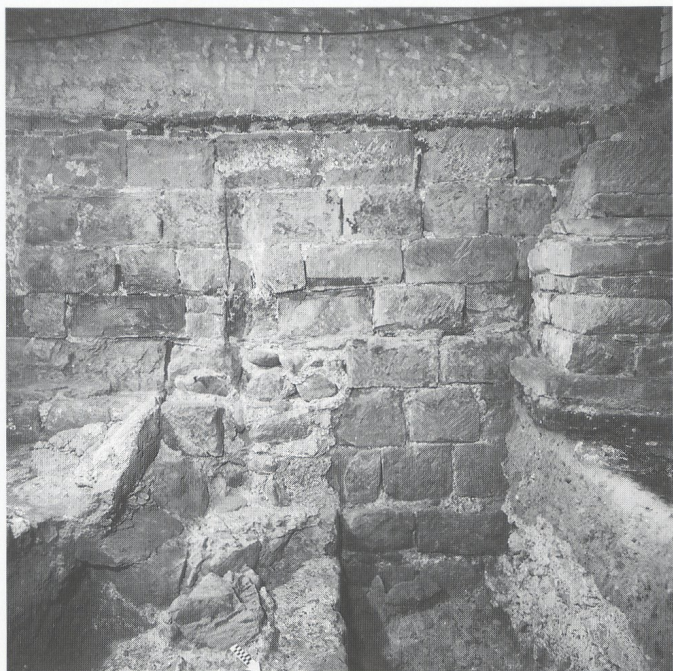
Abb. 20: Burgdorf, Neuenstadt Holzbrunnen, Altes Schlachthaus. Südostecke der Kirche mit ansetzendem Mauerwerk des mutmasslichen Hospitalgebäudes. Blick nach Süden.
