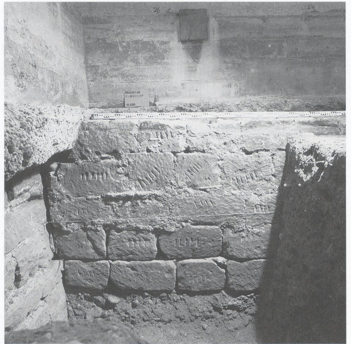
Abb. 42: Burgdorf, Neuenstadt Holzbrunnen, Kornhaus. Westmauer eines gründungszeitlichen Steinbaus an der Stadtmauer (links). Blick nach Osten.
