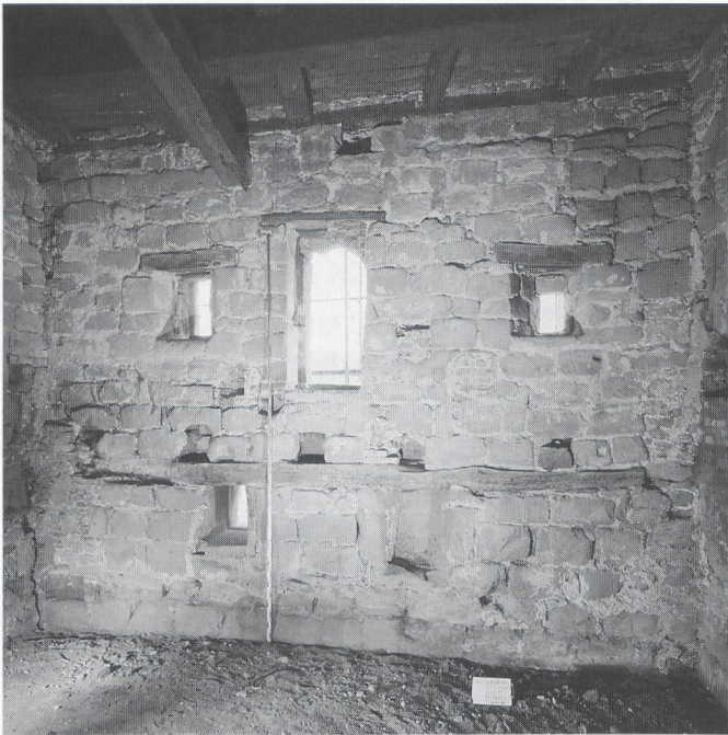
Abb. 44: Burgdorf, Alter Markt, Trüberhaus. Innenseite der Nordmauer von Kernbau C.
