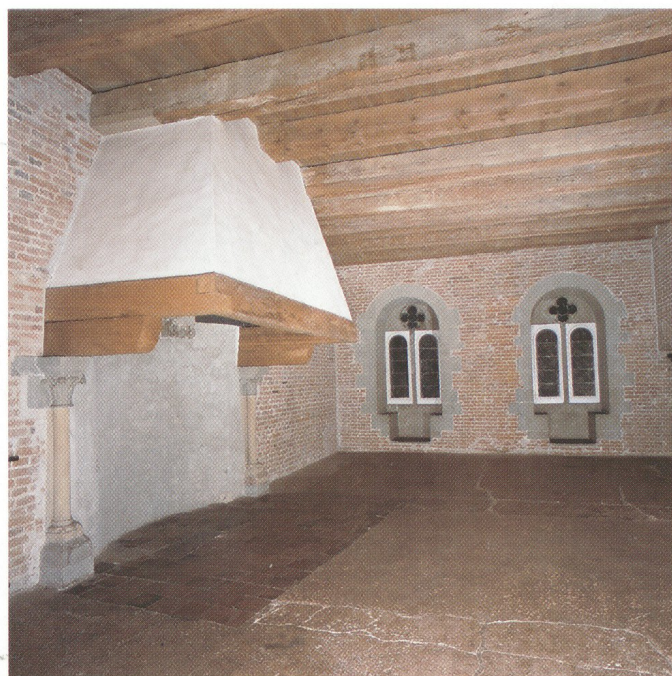
Abb. 10: Burgdorf, Schloss. Grosser Saal im 2. Obergeschoss des Donjon. Blick nach Südosten.
