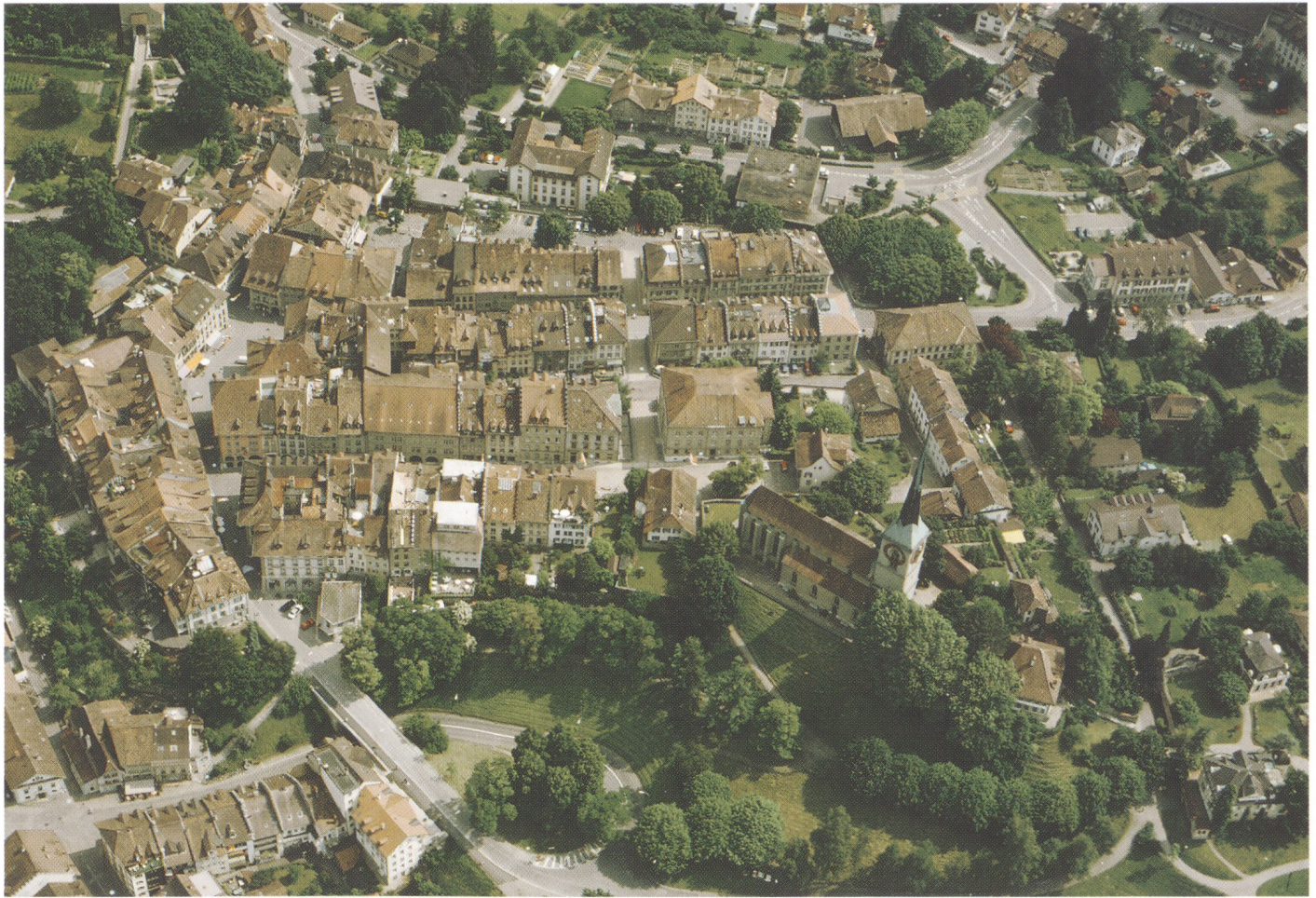
Abb. 2: Burgdorf. Oberstadt Flugaufnahme. Rechts die Gründungsstadt mit der Stadtkirche, links die erste Erweiterung mit dem Kronenplatz. Blick nach Süden.
