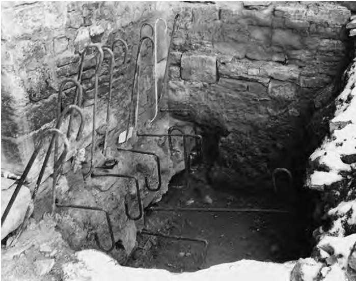
Abb. 199 Die Betonarmierung der westlichen Westwerkfundamentierung aus dem Jahre 1965.
