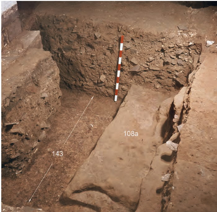
Abb. 83 Schnitt 14. Blick von Südwesten auf die Baugrube 143 eines nur teilweise ausgeführten Fundamentes an der Nordseite der Kirche. Rechts die Sohle der geleerten Ausbruchgrube 108a der Fundamente für die nördliche Arkadenmauer. Nördlich von 143 liegt das Fundament 178 des Pfeilers in der nördlichen Langhauswand.
