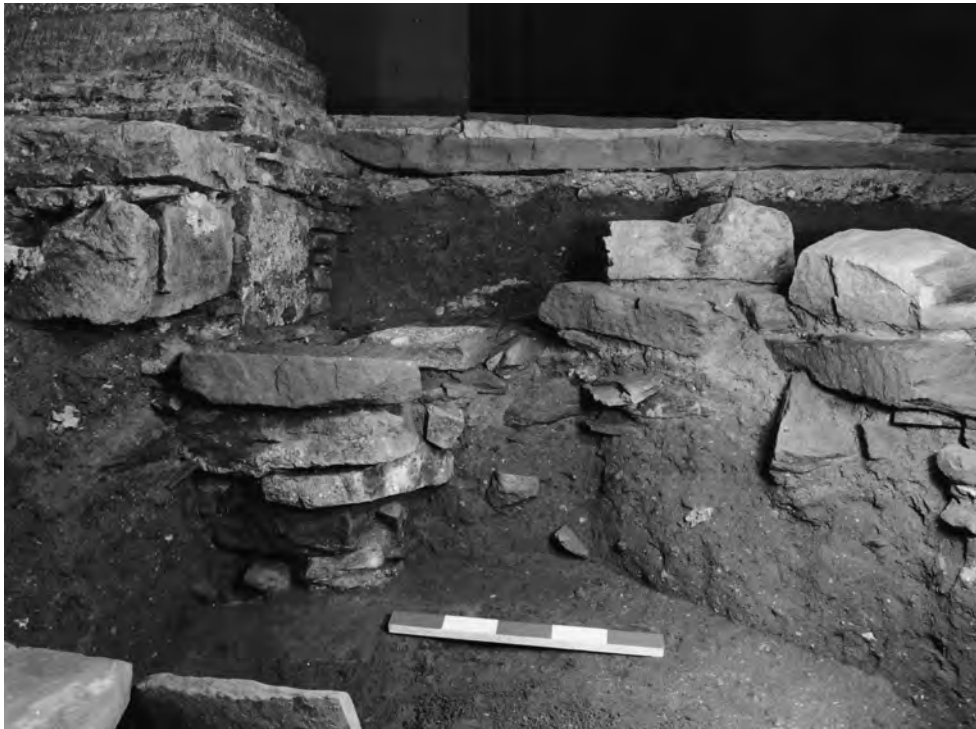
Abb. 149 Schnitt 25. Das Fundament 285 von Norden. Oben rechts befindet sich das Fundament unter dem südlichen Pfeiler und der Säule für die Orgelepore 255.
