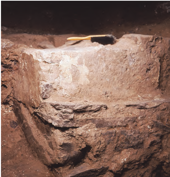
Abb. 69 Schnitt 4. Blick von Südosten auf die südliche Laibung des Eingangs zur karolingischen Außenkrypta 17 im Detail. Im Bereich des Aufgehenden sind Putzreste erhalten.
