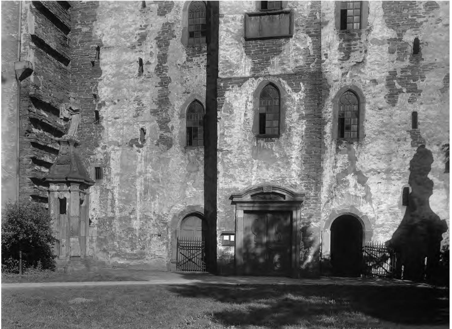
Abb. 194 Die Kirchenfassade mit dem Zugangsweg von Norden, vermutlich 1897.
