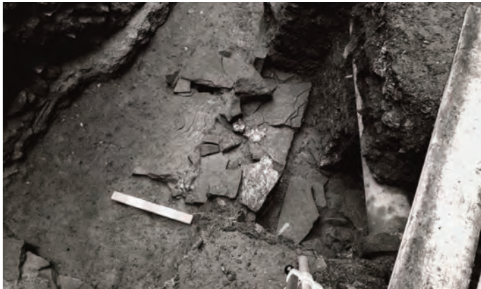
Abb. 267 Schnitt 101. Blick von Westen auf das Pfeilerfundament 311 während der Freilegung.
