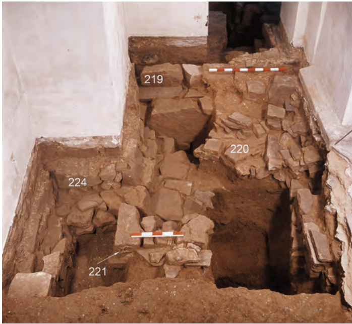
Abb. 127 Schnitt 20. Blick von Westen auf die Überreste der Kapelle im Nordseitenschiff. Im mittleren Vordergrund die Reste des vermuteten Altars 221, im Hintergrund rechts der Ansatz einer kleinen runden Apsis 220, weiter hinten die Reste der Westmauer der ersten karolingischen Kirche 219. Rechts vom Altar vermutlich die Ausbruchgrube eines durch Esterhues entfernten Grabes. 224 ist ein Fundament aus vorbarocker Zeit.
