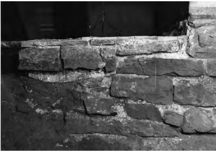
Abb. 144 Schnitt 21. Blick von Norden auf die Nische 251 mit der Zumauerung 252.
