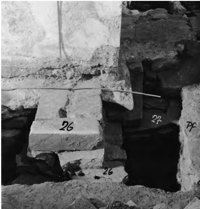
Abb. 106 Sondierung von Esterhues. Grube 1W. Blick von Osten auf den Fundamentblock der ältesten Arkadenflucht 114n (= 26) mit einem Teil des aufgehenden Mauerwerks.
