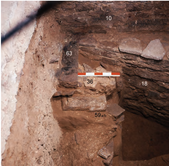
Abb. 24 Schnitt 7. Blick von Süden auf den Sandsteinquader 63, der die Schwelle zum Krypteneingang bildete. Von Osten zieht ein Rest des Fußbodens 36 gegen die Schwelle. Im gewachsenen Boden darunter zeigen sich die Konturen der Ausbruchgrube 59a mit ihrer Verfüllung 59b. Im Hintergrund schneidet das schräg verlaufende barockzeitliche Fundament 18 die gesamte Befundsituation.
