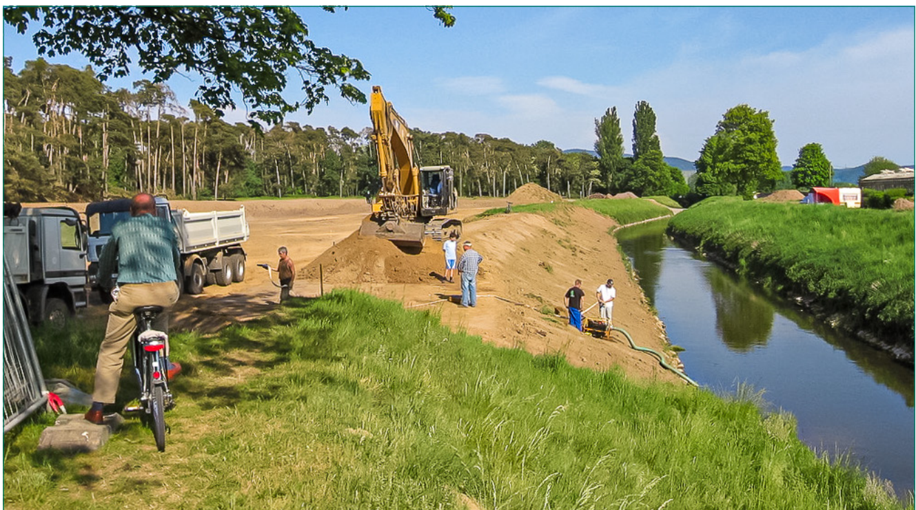
Abb. 1 Der Renaturierungsbereich vor der Fischbergung am Beginn der ersten Arbeiten, flussaufwärts gesehen. (Foto vom 3.5.2007, RH).
