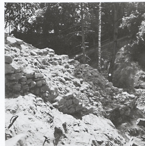
Abb. 49 Westmauer (M. 2) des Turms von Nordwesten. An den kleinen Partien der Mauerschale ist die Lagigkeit des Mauerwerks zu erkennen. Aufnahme vom 17. August 1943.
