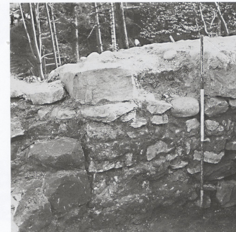
Abb. 51 Nordostecke des Turms von Norden. Von Osten (links) stösst die Ringmauer M. 5 an die Turmmauer M. 3.
