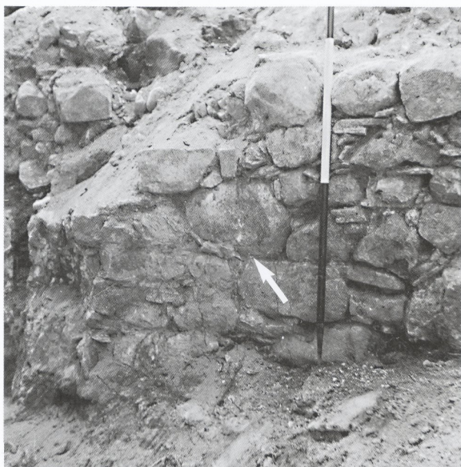
Abb. 57 Winkel zwischen der Ringmauer M. 5 (rechts) und der «Torhaus»-Ostmauer M. 6 (links). Vor allem aufgrund des grossen Steins in der Bildmitte (Pfeil) ist deutlich zu erkennen, dass die beiden Mauern miteinander im Verband stehen.
