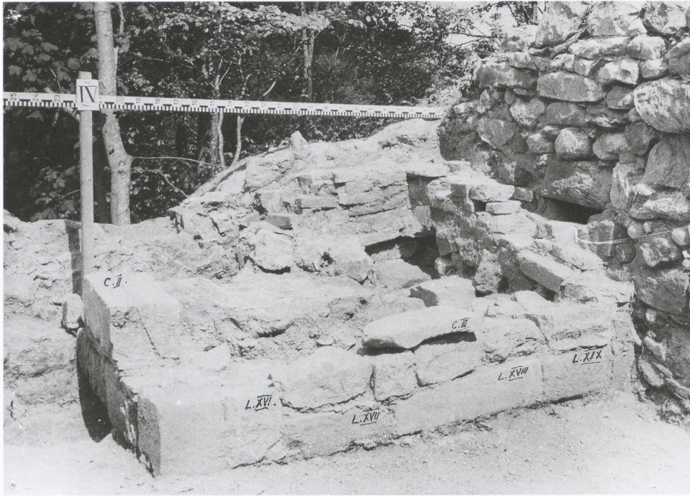
Abb. 78 Die Feuerungsanlage in der Nordecke von Gebäude 4, Ansicht von Süden. Entlang der Ringmauer M. 5 (hinten) und der Mauer M. 7 (rechts) sind die Backsteine der Innenauskleidung zu sehen. Bei den von Erb mit römischen Ziffern versehenen Steinen handelt es sich um Spolien.
