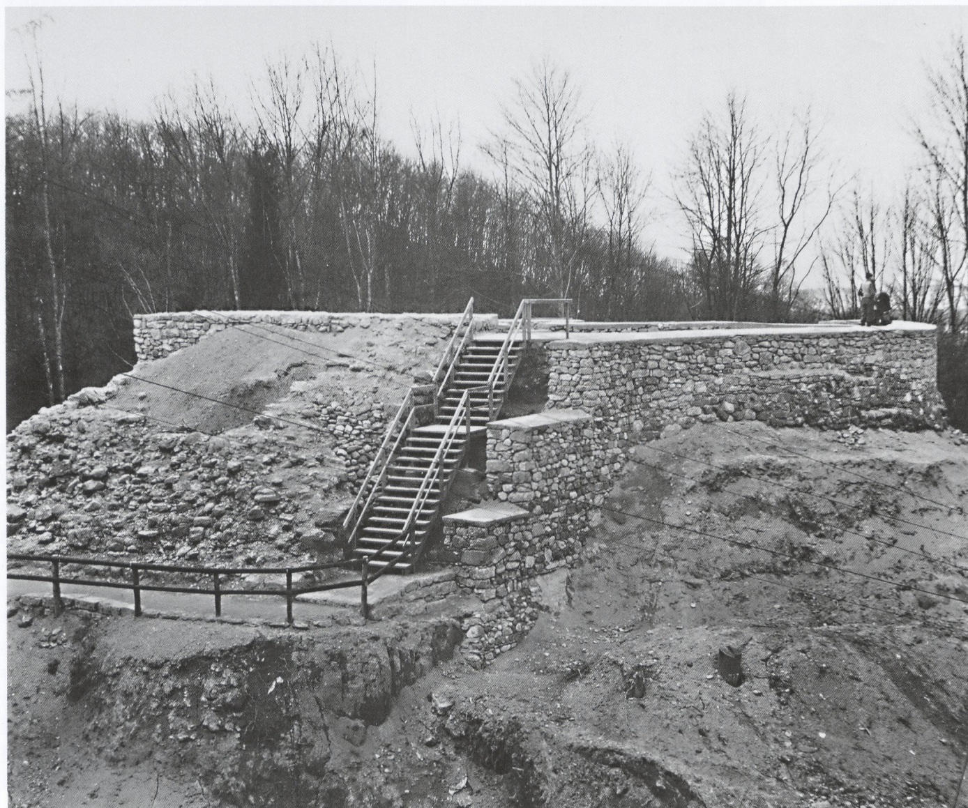
Abb. 42 Dübelstein während der Restaurierungsarbeiten im April 1944, Blick von Südosten. Während beim Turm noch das bei der Ausgrabung ange-troffene Mauerwerk zu erkennen ist, sind die Ringmauer und die Mauer des «Torhauses» bereits rekonstruiert.
