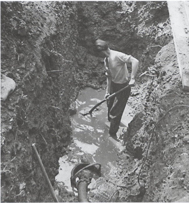
Abb. 36 Sondiergraben im Südwestteil des Burggrabens. Mit einer handbetriebenen Pumpe werden Regen- und Grundwasser aus dem Graben gepumpt. Aufnahme 1943.
