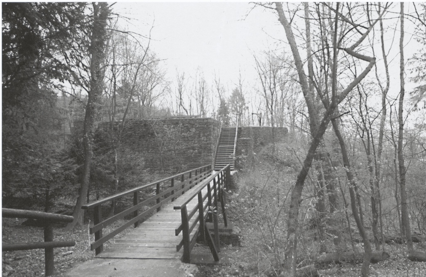
Abb. 3 Der Zugang auf die Burgruine Dübelsein, März 2005. Ansicht von Süden, links die rekonstruierte Ruine des Burgturms, rechts die Wange des «Torhauses» und die Ringmauer.
