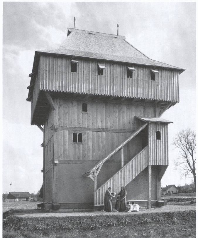
Abb. 126 Bachritterburg Kanzach (Kreis Biberach D). Rekonstruktion des Holzturms mit Schwellbalkenfundament.
