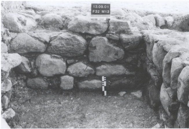
Abb. 47 Schönenbühl AI. Mauer M13. Innerer Mauermantel; von Norden.
