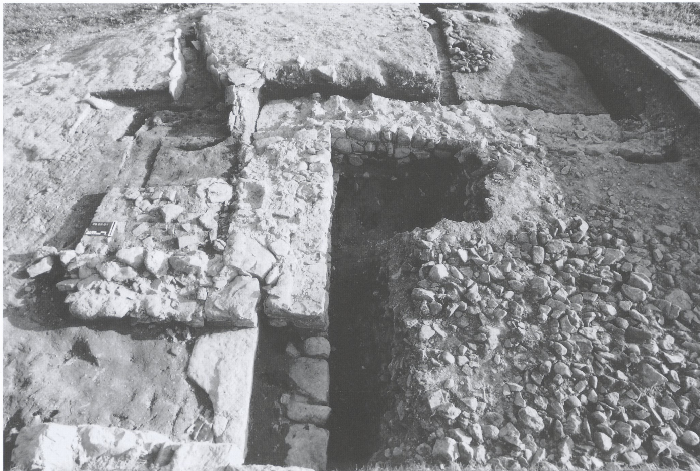
Abb. 57 Schönenbühl AI. Blick auf die Mauern M13/M14 und den Kellerabgang; von Norden.
