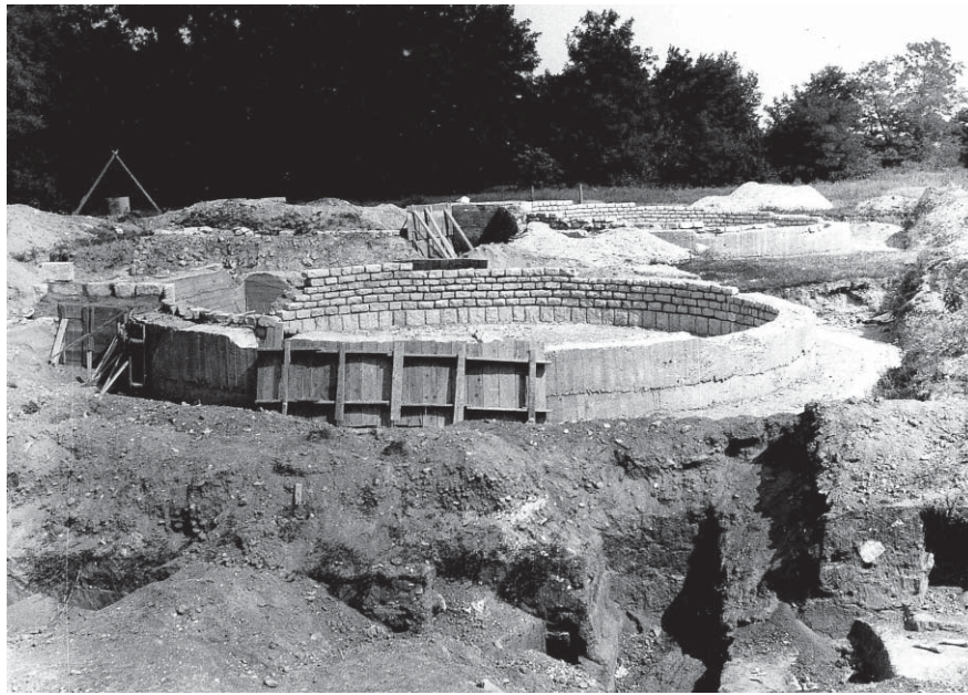
Abb. 8 Die Bauarbeiten an den Rundtürmen des Südtors 1971: Aufmauerung der Fundamente.
