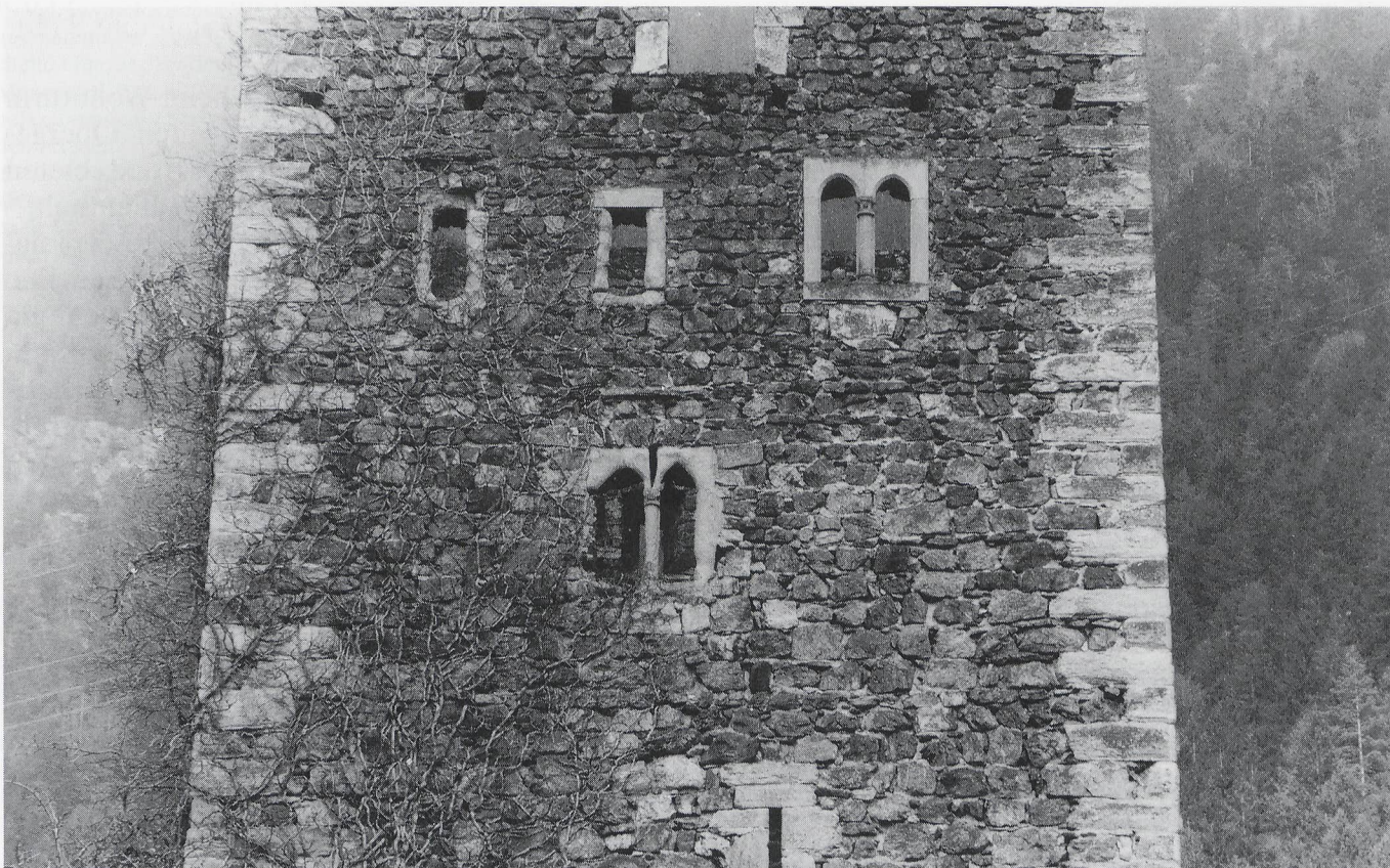
Silenen (UR), Meieramtsturm. Beispiel eines Wohnturms, Ausschnitt aus der Westfassade mit originalen Kuppelfenstern. Aufnahme von 1985, vor der jüngsten Renovation.
