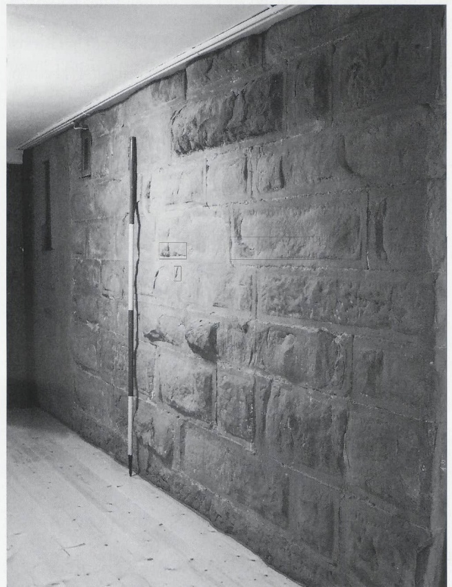
Burg Uster (ZH), Ausschnitt der Westfassade des Turms im zweiten Obergeschoss der landwirtschaftlichen Haushaltungsschule. Kleines Fenster links oben spätmittelalterliche Ergänzung. (Der über die Dächer aufragende Turmteil, hier nicht zu sehen, ist eine historisierende Rekonstruktion).
