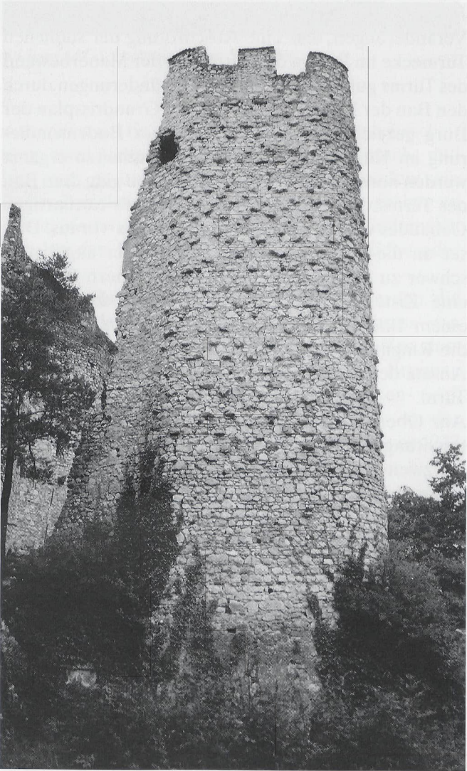
Ruine Pfeffingen (BL), gerundete Westfront des grossen Wohnturms mit «abschreckend-imponierendem» Mauerwerk aus Kalksteinen, Mitte 13. Jahrhundert.
