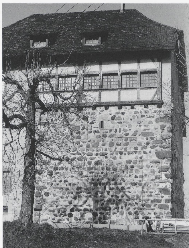
Oberberg, Gossau (SG), Westfassade des Burgturms (vgl. Bildausschnitt S. 10), grosse Blöcke am Eckverband, Riegelwerk-Aufbau im 20. Jahrhundert erneuert.
