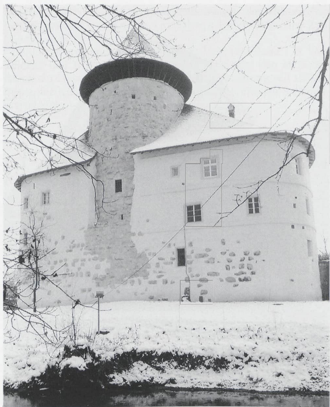
Zwingen (BE), Ansicht der Burg von Norden, Zustand nach Restaurierung (Fotografie 1995). Am runden Burgturm unten beidseitig Anschluss der gleichzeitig (1240–1245) gebauten Umfassungsmauer, darin das jüngere Burggebäude.
