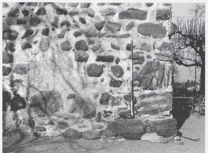
Schloss Oberberg (SG), Westfassade, Mauerwerk der Süd- westecke mit Findlingssteinen und Megalithen.
