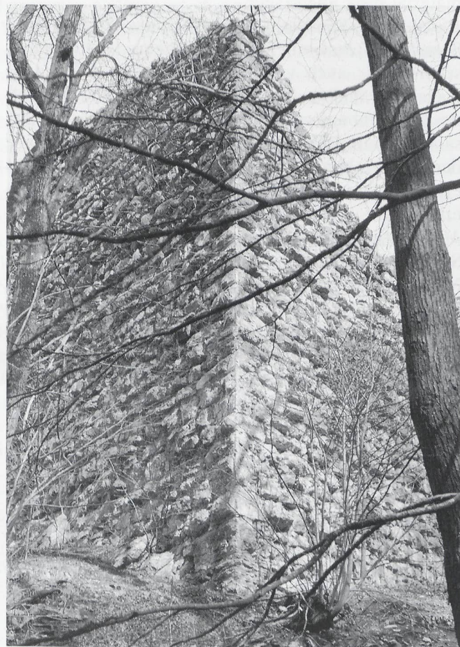
Vorburg, Oberurnen (GL), Ansicht von Nordwesten, Beispiel einer Burgmauer aus grossen Kalksteinblöcken.
