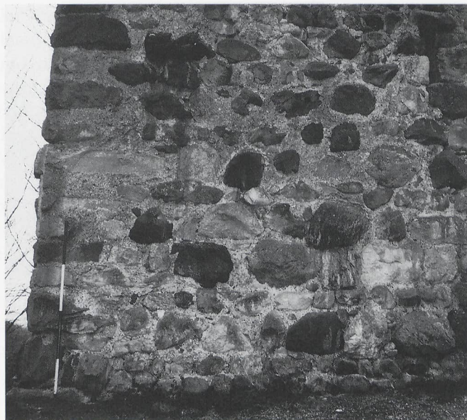
Neuburg, Mammern (TG), Südteil der Ostfassade, mit Findlingssteinen unterschiedlicher geologischer Herkunft.
