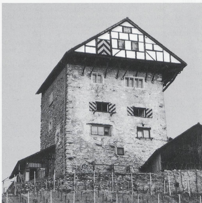
Neu Altstätten (SG), Beispiel eines Turms mit Holzaufbau; Satteldach an der Stelle eines ehemaligen, auf allen Seiten vorkragenden Obergadens. Auf die Bauzeit des Turms gehen die massiven Tragbalken zurück. Aufnahme 1984.
