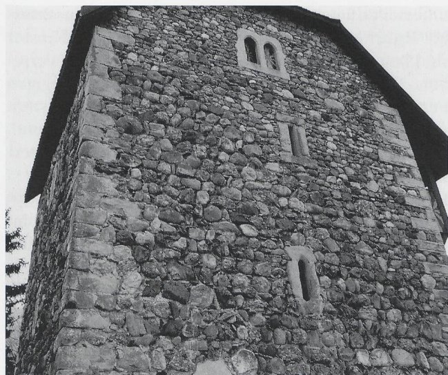
Iberg (Wattwil SG), oberer Teil der Südfassade des Turms, nach 1902 ergänzter Mauerteil oben rechts (etwa diagonal begrenzt, mit schärfer gehauenen, besser erhaltenen Eckquadern rechts).
