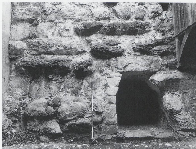
Schlosswil (BE), Sockelbereich der Nordfassade des Burgturms, jüngerer Zugang durch die Burgmauern.
