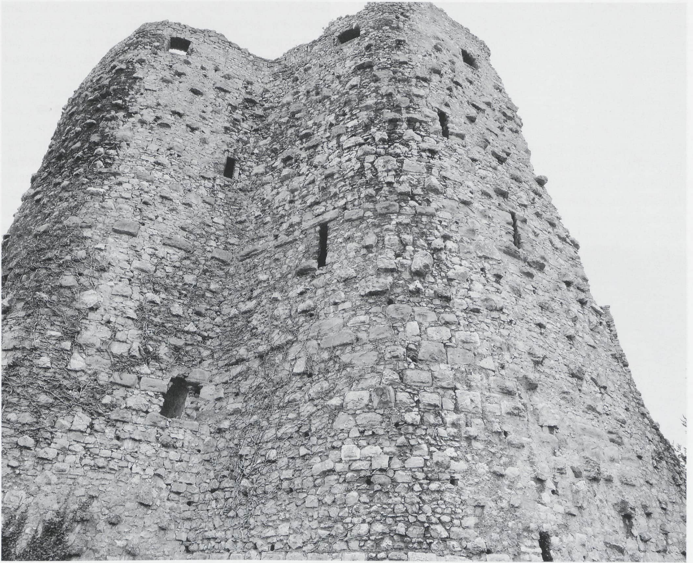
Pfeffingen, Nordseite des Turms, vorwiegend in der unteren Bildhälfte mit eingestreuten Zeilen älterer, wiederverwendeter Sandstein-Buckelquader.
