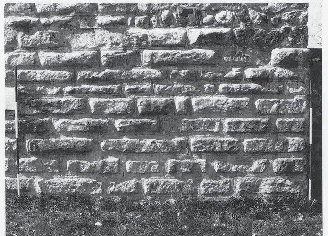
Alt-Regensberg (ZH), Buckelquader-Mauerwerk an der Südfassade des Turms.
