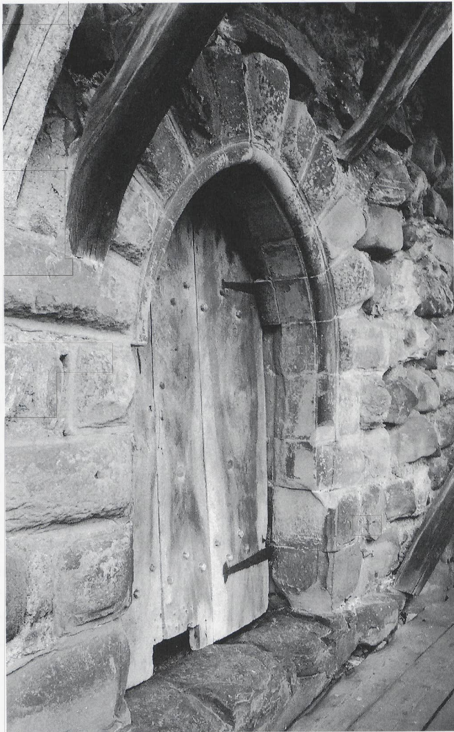
Mammertshofen, Roggwil (TG), Hocheingang des Turms, Gewände aus Sandstein-Buckelquadern.
