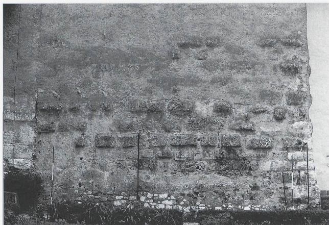
Burgdorf, Sockel des Bergfrieds aus Buckelquadern, zusammen mit der verputzten Mauer darüber um 1200 erbaut.
