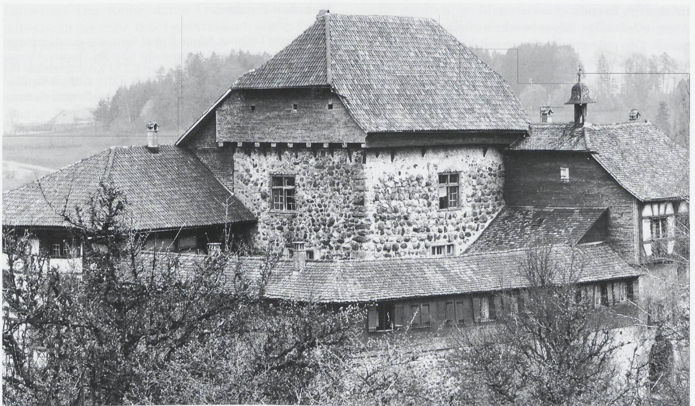
Hagenwil (TG), Wasserburg, Ansicht von Südwesten, Holzaufbau des zentralen Findlings-Turms von 1417.
