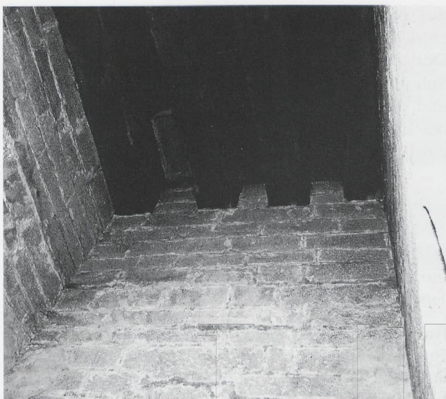
Schloss Frauenfeld, Bergfried, Balkendecke über dem ersten Obergeschoss. Ansicht von Osten. Die vier mächtigen Eichenbalken überspannen einen Innenraum von nur ca. 3 m Weite und liegen fest in den Mauern des Burgturms. Sie tragen einen schweren, seit der Bauzeit erhalten gebliebenen Zwischenboden, aufgebaut aus Holzbohlen, Mörtelguss und Steinplatten. Datierung der Balken gemäss Proben, die der Verfasser (von einer Leiter aus) entnommen hat: Jüngste gemessene Jahrringe der Balken, von rechts nach links, aus den Jahren 1231, 1208, 1231, 1225. Dieser Teil des Turms wurde somit kurz nach 1231 gebaut.
