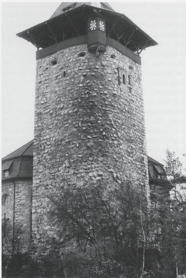
Niedergösgen (SO), Burgturm von Nordosten (heute Turm der Kirche), gerundeter Eckverband.
