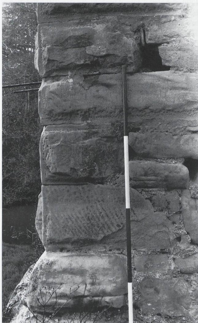
Grimmenstein, St. Margrethen (SG), Buckelquader des östlichen Eckverbands mit erhalten gebliebenen Hauspuren an einem Stein.
