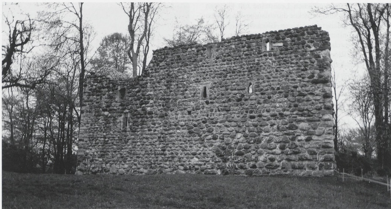
Steinerburg, Steinach (SG), Ansicht von Norden, Findlingsmauerwerk, mit verschiedenen kleinen Fensteröffnungen.
