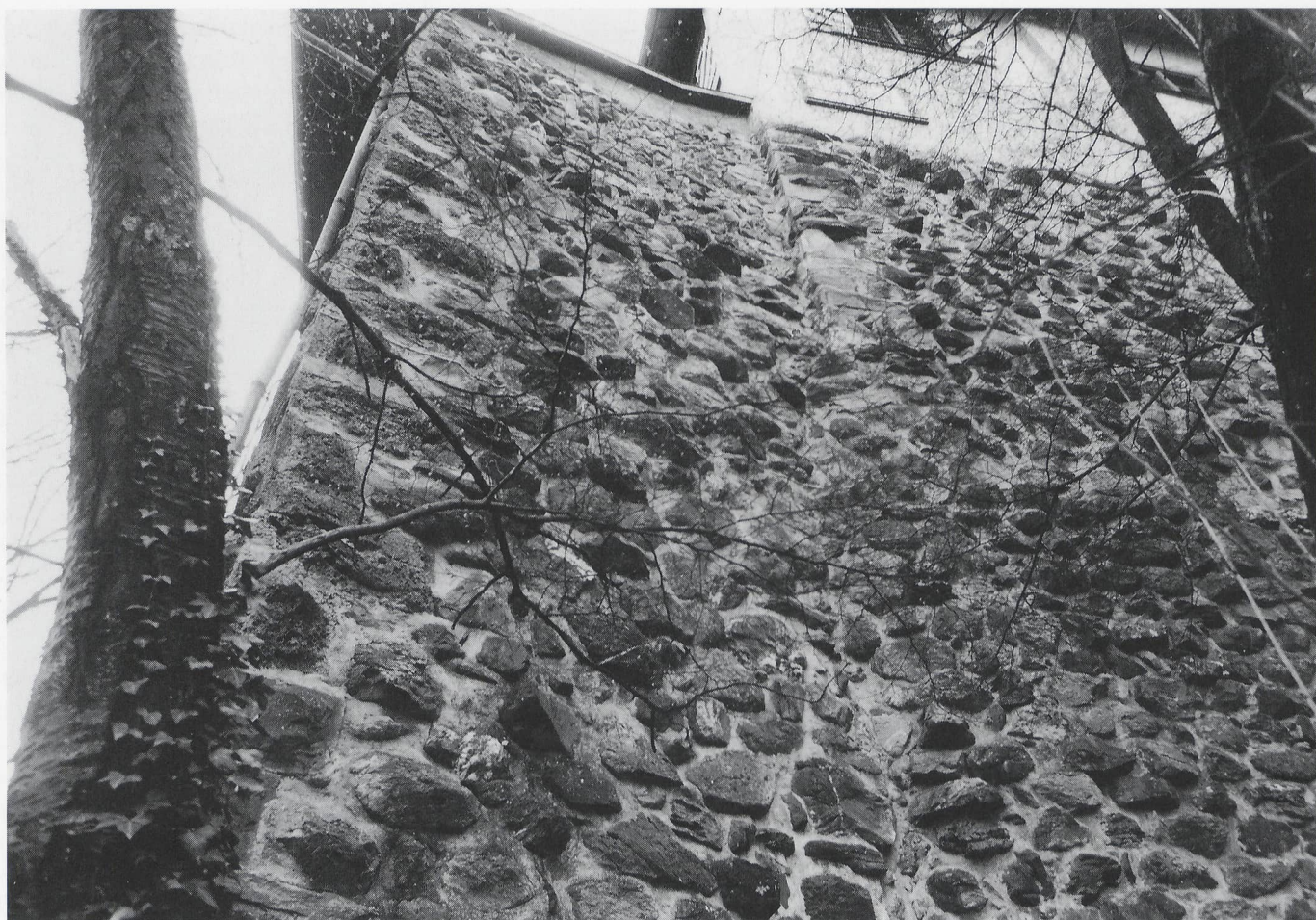
Mörsburg (ZH), südliches Ende der Ostfassade, in zwei Etappen ausgeführte Ummantelung des Kernbaus mit Megalithsteinen, rechts oben Eckverband aus Buckelquadern, links eine schrägstehende Partie: Ummauerung des Vorbaus.
