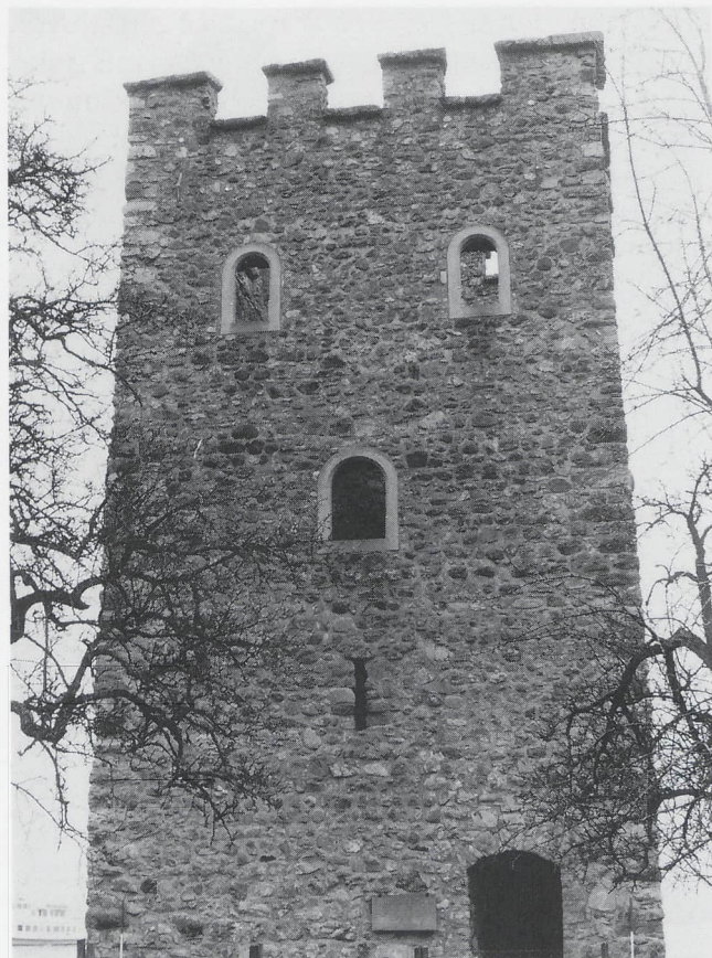
Schnitzturm, Stansstad (NW), Südfassade. Lichtschlitz im unteren Mauerteil original, übrige Maueröffnungen sowie Zinnen rekonstruiert.
