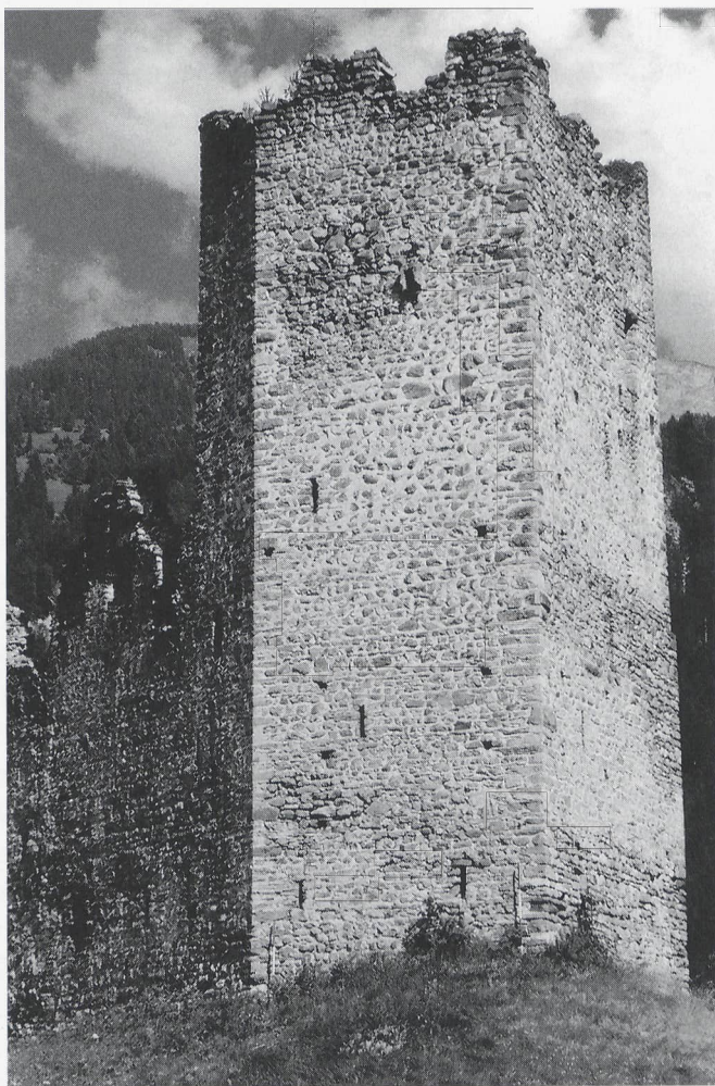
Strassberg (GR), von Nordwesten. Gutes Beispiel für die Mauertechnik der Burgtürme Graubündens.
