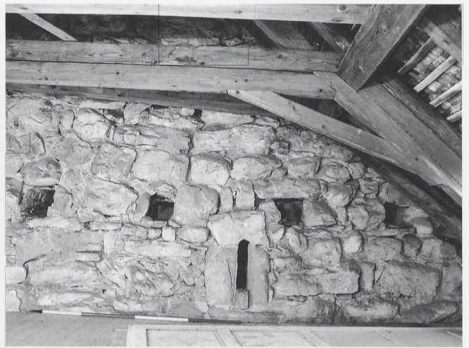
Grünenstein, Balgach (SG), Ausschnitt der ehemaligen Ostfassade des Burgturms, mit Lichtöffnung sowie Balkenlöchern für vorkragende Träger eines Laufgangs. Aufnahme im Dachstuhl des angebauten Schlossgebäudes aus dem 18. Jahrhundert.
