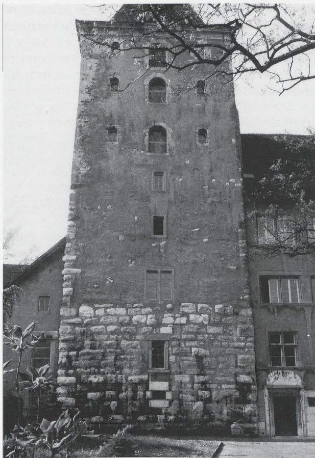
Schloss Nidau (BE), Südfassade des Burgturms aus dem 13. Jahrhundert, mit jüngerem Dachgesims und Dach sowie neuzeitlichen Öffnungen.
