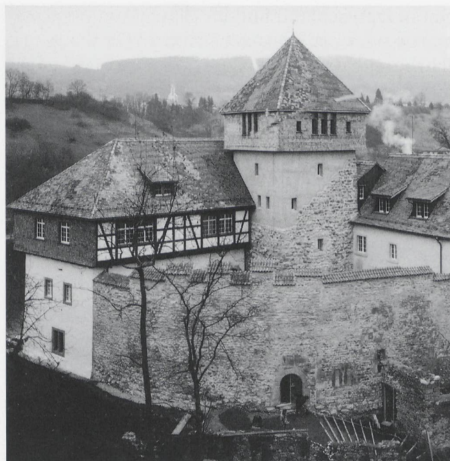
Diessenhofen (TG), Unterhof, von Süden. Links der Palas, errichtet 1315 bis 1318; rechts daneben der Burgturm, dendrochronologisch datiert in das Jahr 1186. Am Turm unten originales Findlingsmauerwerk, oberer Teil rekonstruiert 1992. (Foto Amt für Archäologie des Kantons Thurgau).
