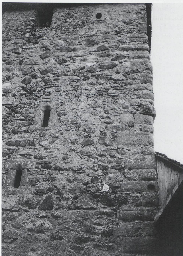
Hohenklingen, Stein am Rhein (SH), oberer Teil der Westfassade des Wohnturms, erbaut um 1255, links zwei originale Lichtschlitze.
