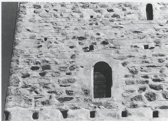
Sargans (SG), Wohnturm, Ausschnitt der Ostfassade, Verputz mit Fugenstrichen (wohl 12. Jahrhundert), stellenweise restauriert.
