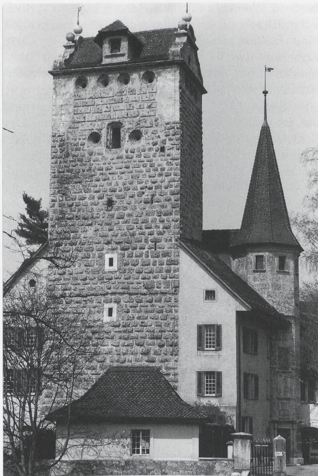
Schloss Aarwangen (BE), Ansicht von Süden. Bauzeit des Turms 1266; oberer Abschluss mit kreisrunden Scharten aus barocker Zeit.
