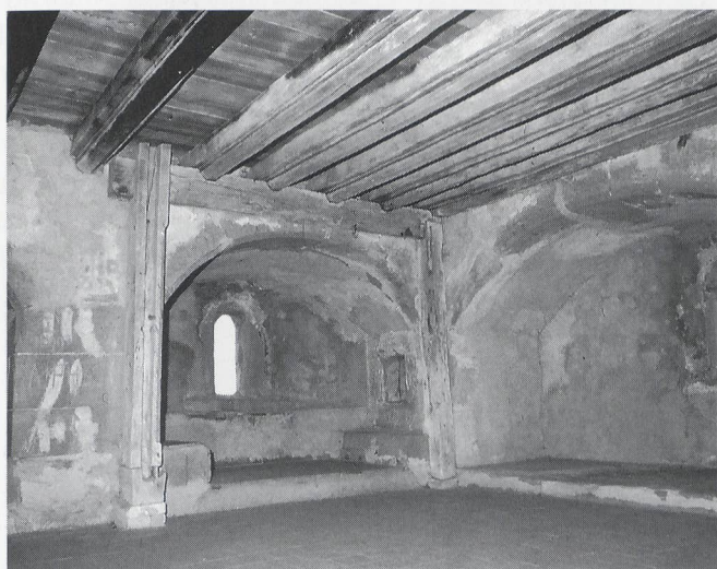
Hohenklingen, Innenraum im zweiten Obergeschoss des Wohnturms, ehemals von Bohlenwand in zwei Wohnräume unterteilt. Deckenbalken in den zwei Kammern unterschiedlich profiliert, an der Wand links Reste einer Bemalung.
