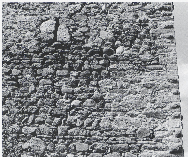
Ringgenberg (GR), Ausschnitt aus der Südfassade. Beispiel eines Turms mit Konzentration der Steinbuckel am Eckverband.
