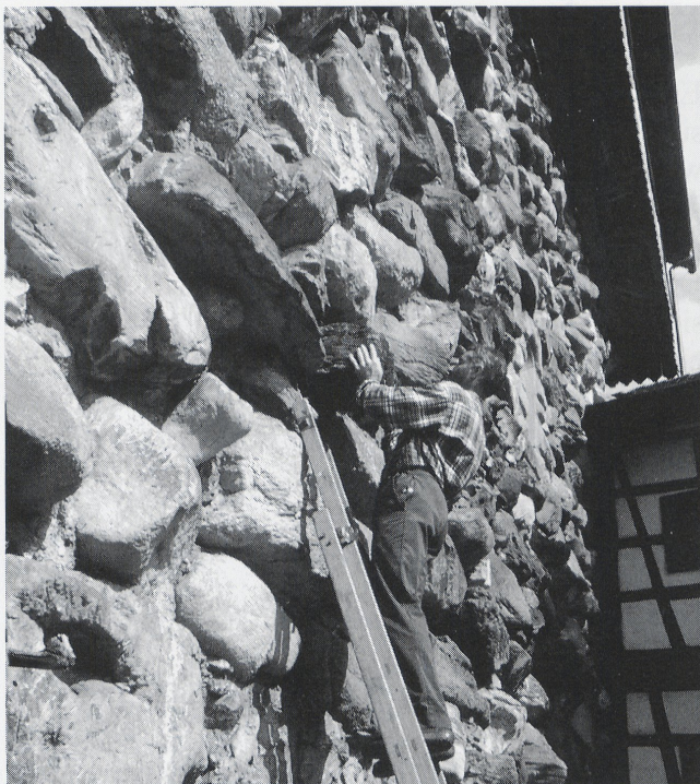
Mammertshofen (TG). Der Rest eines Kragbalkens wird nach der dendrochronologischen Untersuchung wieder in das originale Balkenloch in der Südfassade eingesetzt (August 1992).
