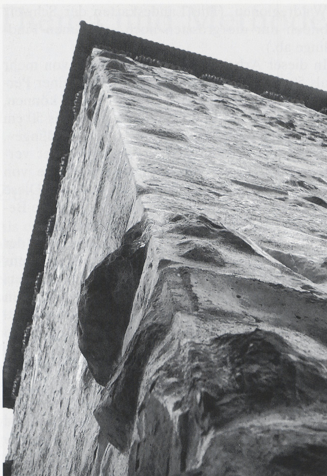
Weinfelden (TG), Nordwestecke des Burgturms, gut sichtbarer Kantenschlag an der Turmecke.
