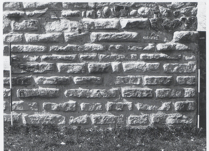
Alt-Regensberg (ZH), Buckelquader-Mauerwerk an der Südfassade des Turms.
