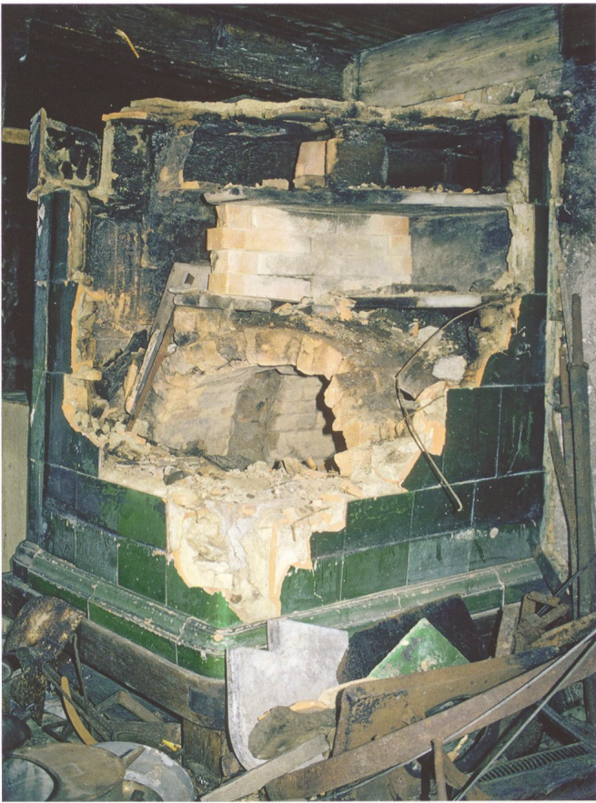
Abb. 225 Ingenbohl, SZ. Teilweise abgebrochener Ofen mit tonnengewölbtem Feuerungsraum, seitlich eingeschobenem Wärmefach aus Backsteinen und Sandsteinplatten und darüberliegenden, zur Küche zurückgeführten Zügen, 19. Jh.
