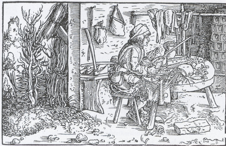
Abb. 263 Eingliedriger, schwach konischer Kachelofen ohne besonderen Abschluss, bestehend aus quadratischen Schüsselkacheln auf einem gemauerten(?) Sockel, Augsburg BY, 1532.
