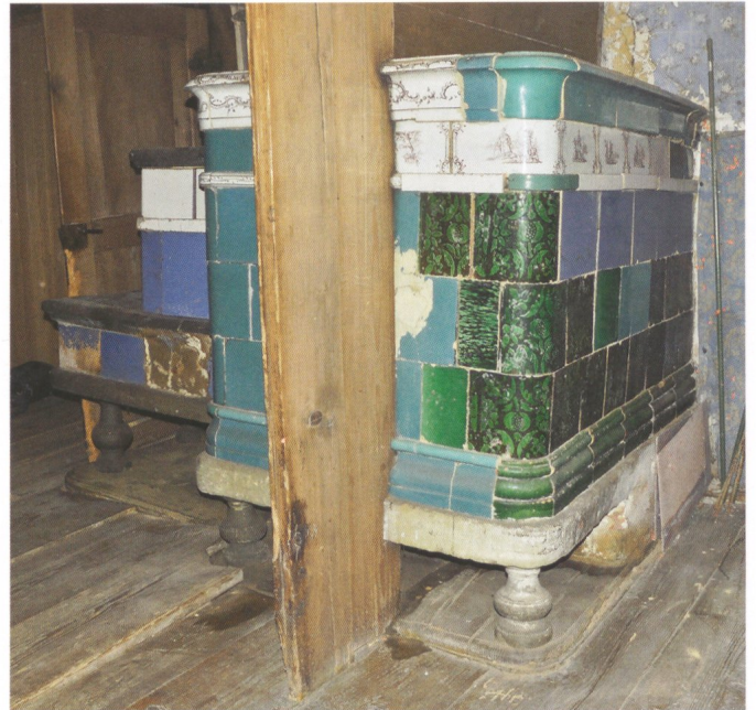
Abb. 235 Roggwil BE, Schmittestrasse 31. Kachelofen mit jüngerer angebaute Ofenkunst in einem heute unbewohnten Taunerhaus der Mitte des 18. Jh. Er besteht aus unterschiedlich alten Kacheln und ist wohl als «Arme-Leute-Kachelofen» anzusprechen. Er wurde bis in die späten 1980er-Jahre in dieser Form zur Heizung des Hauses genutzt.
