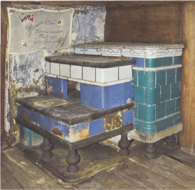
Abb. 235 Roggwil BE, Schmittestrasse 31. Kachelofen mit jüngerer angebaute Ofenkunst in einem heute unbewohnten Taunerhaus der Mitte des 18. Jh. Er besteht aus unterschiedlich alten Kacheln und ist wohl als «Arme-Leute-Kachelofen» anzusprechen. Er wurde bis in die späten 1980er-Jahre in dieser Form zur Heizung des Hauses genutzt.
