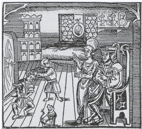
Abb. 258 Kachelofen mit Halbzylinder- und Bekrönungskacheln als Hinterladerofen in einer aufwendig mit Butzenscheiben befensterten Stube, Strassburg F, 1508.
