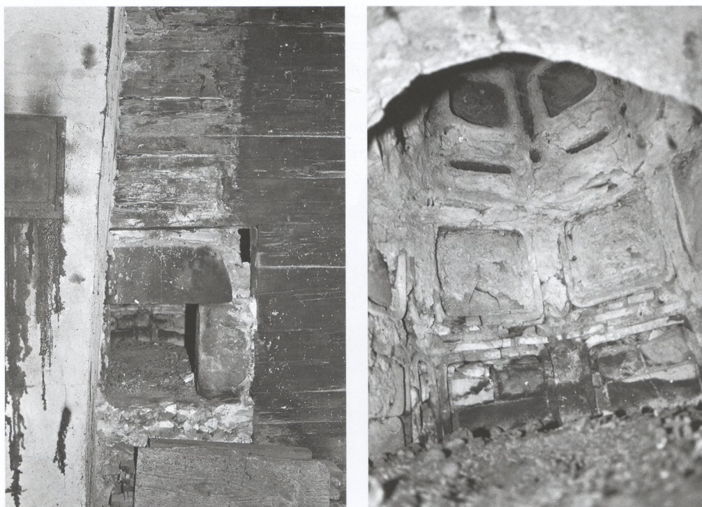
Abb. 224 Bürglen UR, Planzerhaus (vgl. Abb. 127). Blick auf die Einfeuerung und die innere Struktur des Kachelofens von 1611/1612 im Bereich des Übergangs von Unterbau und Turm.
