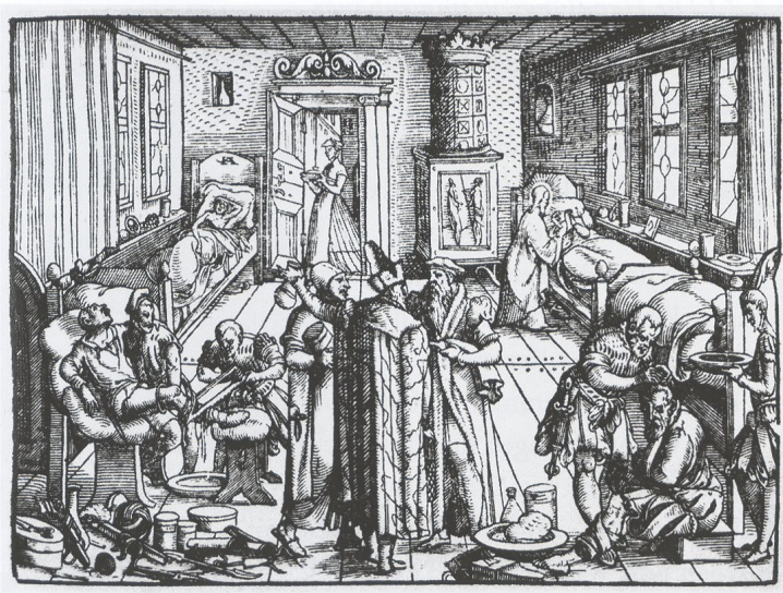
Abb. 257 Kombinationsofen aus gusseisernem Feuerungskasten und aufgesetztem Oberofen aus Ofenkacheln. Der offenbar moderne Ofen steht im Krankenzimmer eines Hospitals, Frankfurt HE, 1565.
