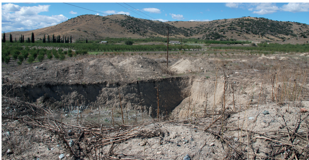
Abb. 6.2. Zustand nach Erdarbeiten im Bereich von Nessonis 1-Ost; dahinter (zwischen den beiden Gebäuden) die Magula Nessonis 2.
