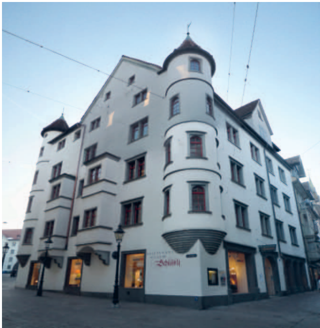
Abb. 259 St. Gallen, Schössli an der Spisergasse. Für Lorenz II. Zollikofer erbaut 1586–1590 (DP Stadt St. Gallen 2011).
