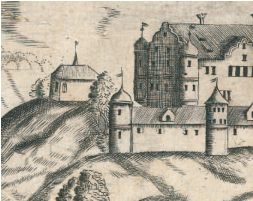
Abb. 309 Auf dem Kupferstich von 1664 ist der Anschluss der Kapelle an die Ostmauer nicht ersichtlich. Klar wird aber, dass die Kapelle nicht über eine Blendfassade verfügte, wie auch der Befund gezeigt hat (Fideikommiss Zollikofer 2010).
