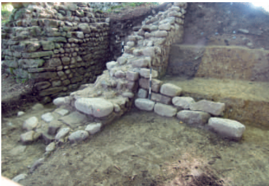
Abb. 31 Ostseitige Wange der Toranlage, Ecke an grossem Eckstein erkennbar (AATG 2015 Thomas Keiser).
