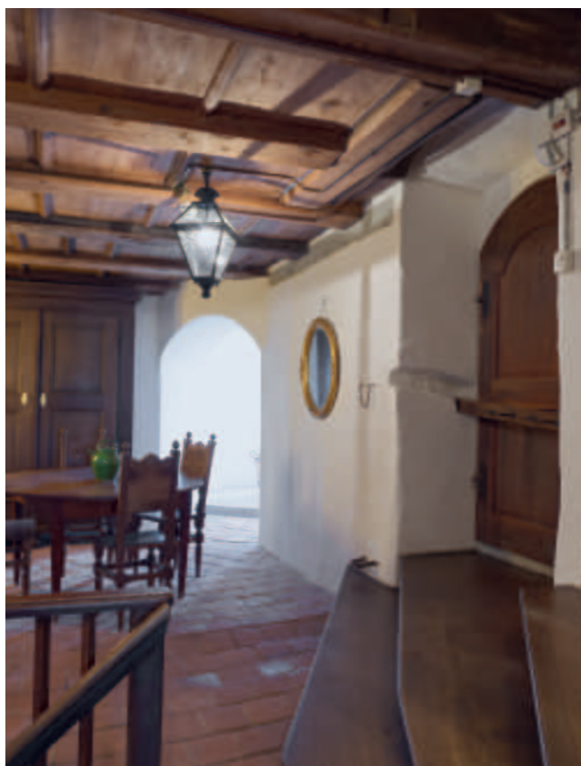
Abb. 292 Tür aus dem Zwischengeschoss, die heute ins Dachgeschoss des Nebengebäudes führt und ursprünglich auf den Wehrgang führte (DPTG 2021 Lukas Fleischer).
