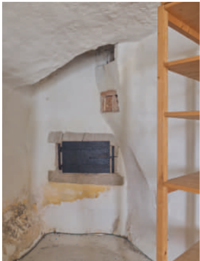
Abb. 290 Im Erdgeschoss der Remise befindet sich im Raum neben dem Kleinen Schloss ein geräumiger Backofen, der den Platz in der Mauer zwischen den Gebäuden ausfüllt (DPTG 2021 Lukas Fleischer).
