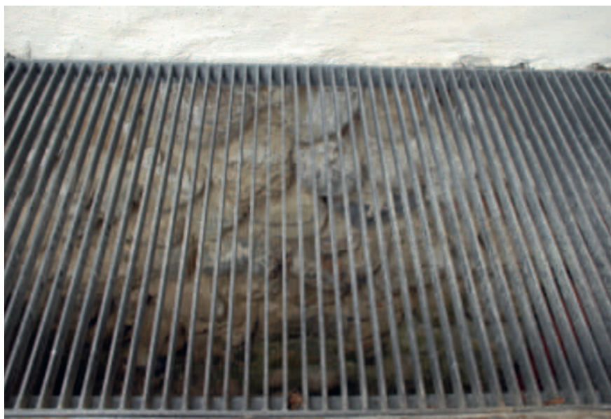
Abb. 233 Blick durch das Gitter hinab entlang der Mauer der Zwischenwand, die auffällig aus Bollensteinen und nicht wie die Mauern des Schlosses sonst aus Bruchsteinen besteht (AATG 2021 Iris Hutter).
