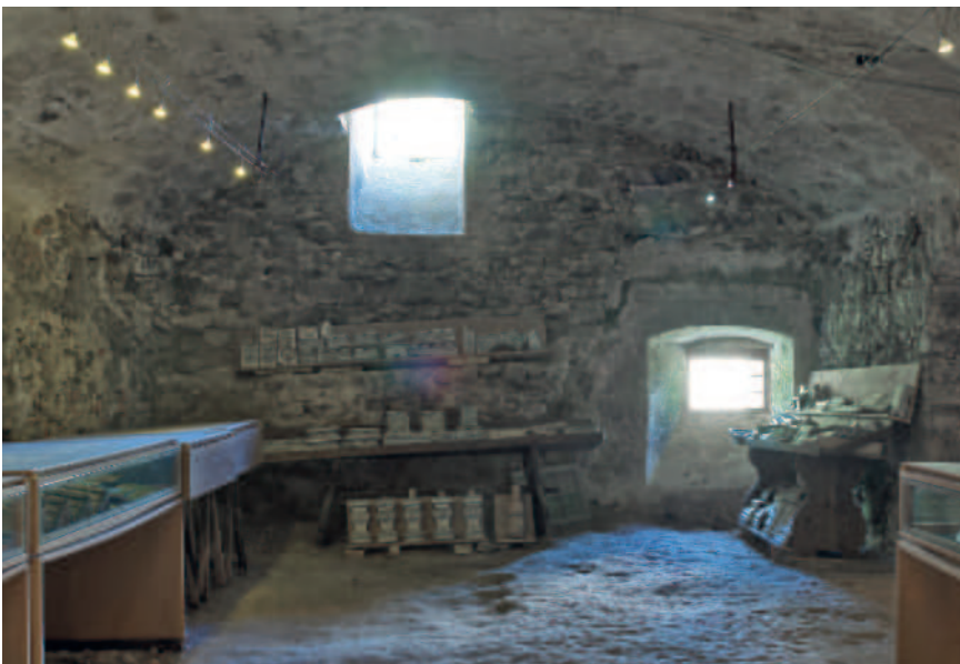
Abb. 226 Westmauer des Kellerraums -103 mit Bollensteinmauerwerk (DPTG 2021 Lukas Fleischer).
