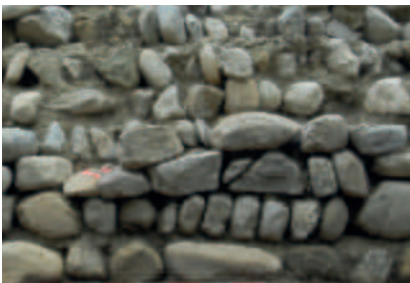
Südmauer Wohngebäude innen
