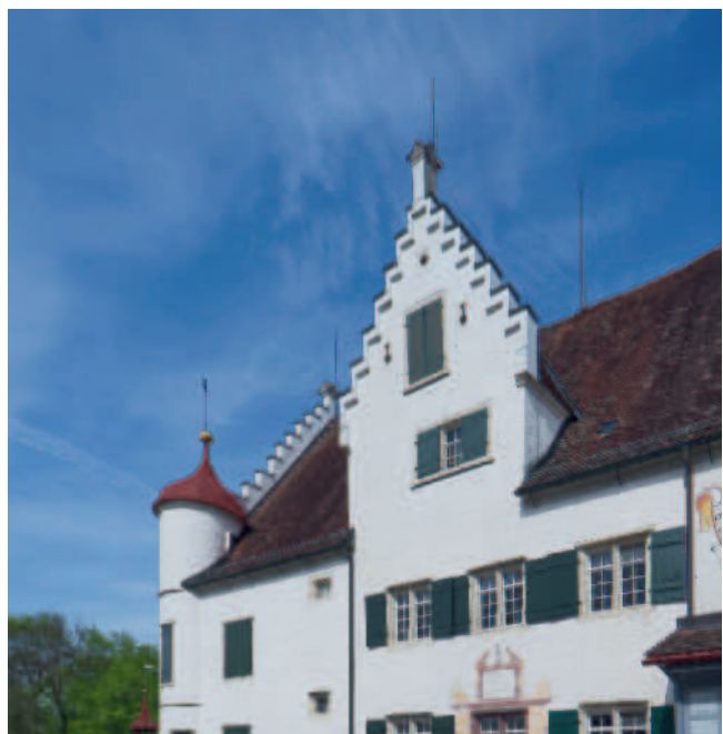
Abb. 264 Detail des Treppengiebels von Schloss Altenklingen mit diesem folgenden Gesims (DPTG 2021 Lukas Fleischer).
