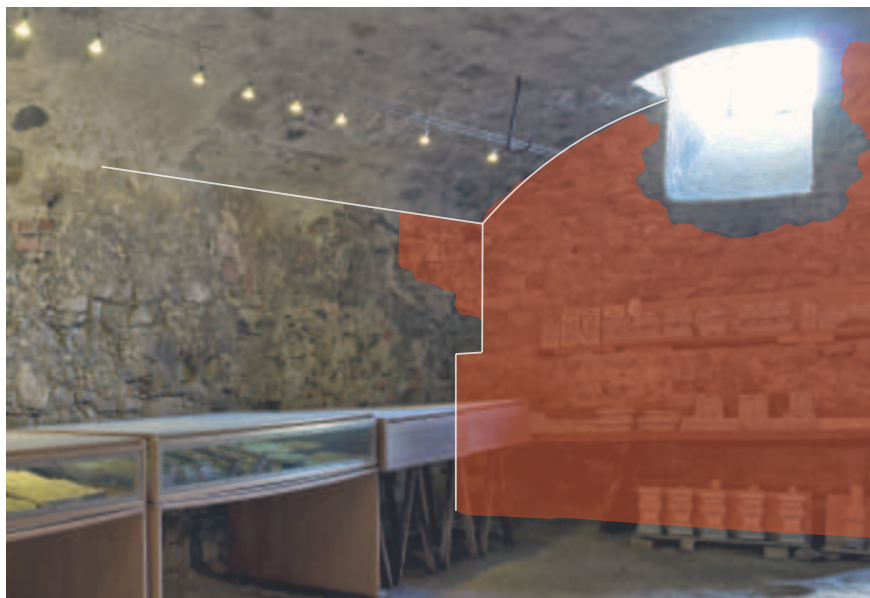
Abb. 228 Ecksituation Ost-Südmauer im Raum -103. Gleich unter dem Gewölbeansatz ist noch Bollensteinmauerwerk zu erkennen, das mit jenem der Ostwand im Verbund steht (DPTG 2021 Lukas Fleischer).
