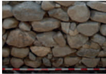
Ostmauer Ringmauer innen
