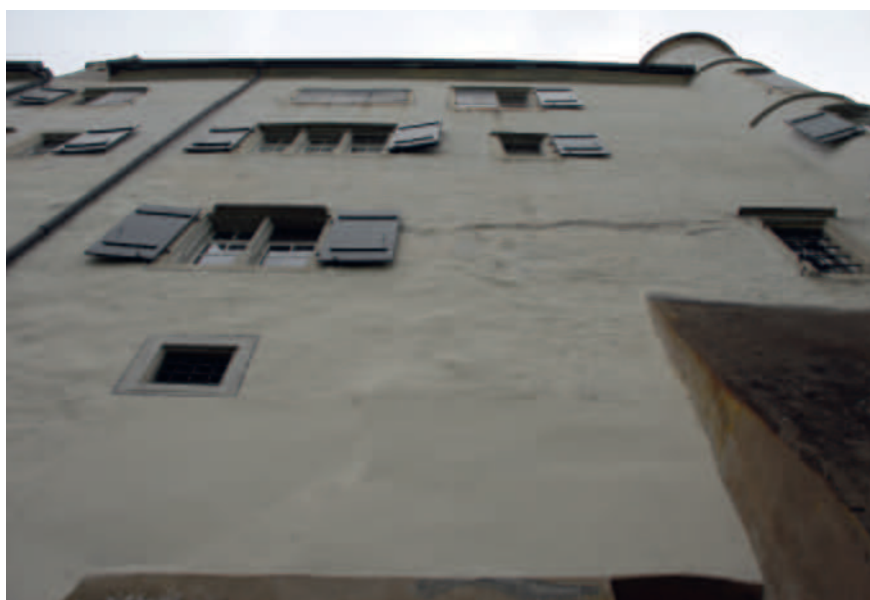
Abb. 229 Die Westfassade des Grossen Schlosses ist aussen bis Mitte des Erdgeschosses deutlich weniger plan als darüber (AATG 2021 Iris Hutter).
