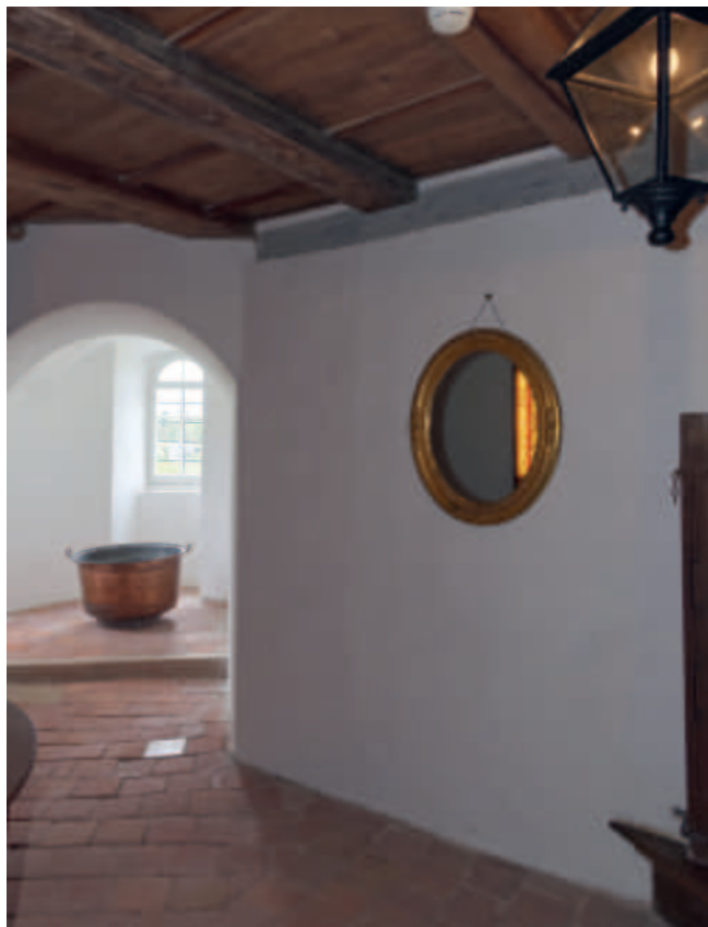
Abb. 289 Erkennbar verändertes Raumgefüge aufgrund des Wechsels in den Bodenfliesen und den Nuten im Deckenbalken (DPTG 2021 Lukas Fleischer).
