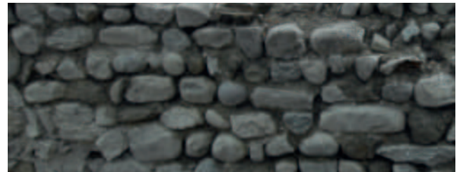
Westmauer Turm II aussen
