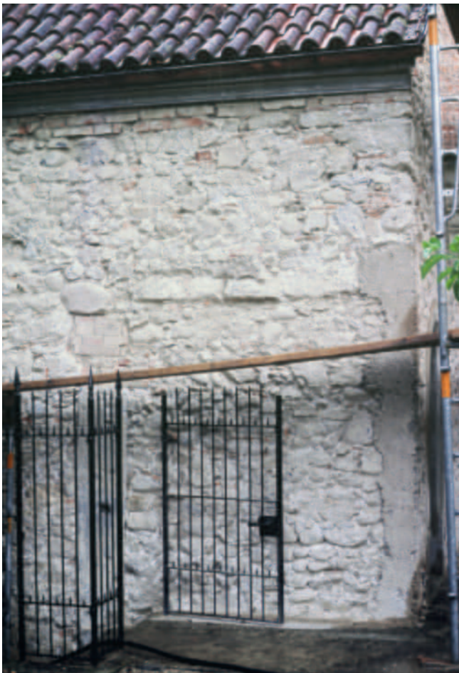
Abb. 306 Die Kapelle, Ostseite mit freigelegtem Mauerwerk während der Fassadenrenovierung 2000. Erkennbar der frühere Zugang, der auch im Holzmodell geplant wurde (DPTG 2000).
