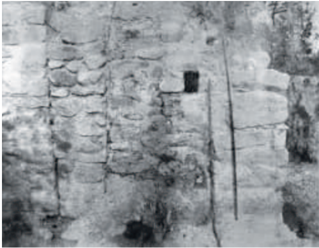
Abb. 33 Aufnahme von 1903 mit verschlossenem «Durchgang» zwischen Torwange und Turm II. Zur Orientierung: Schwarzes rechteckiges Loch ist wiederum das Balkenloch des Holzriegels der Toranlage (Grafische Sammlung SNB 1903).
