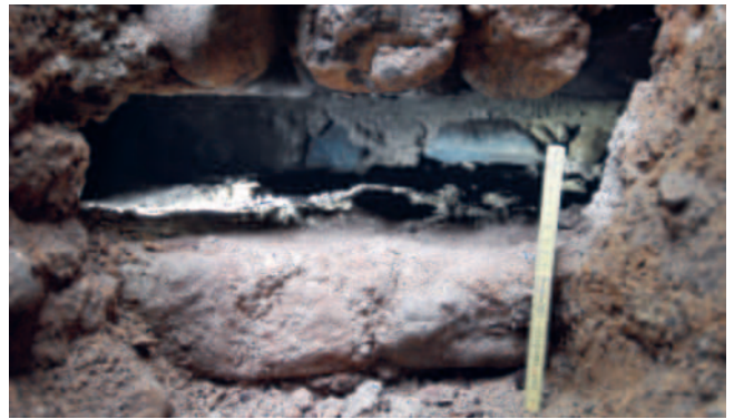
Abb. 77 Nahaufnahme des Durchbruchs im Mauerfundament der Südmauer des Nebengebäudes (AATG 2014 Daniel Steiner).
