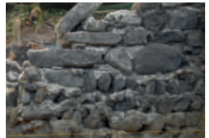
Binnenmauer II aussen (Südseite)
