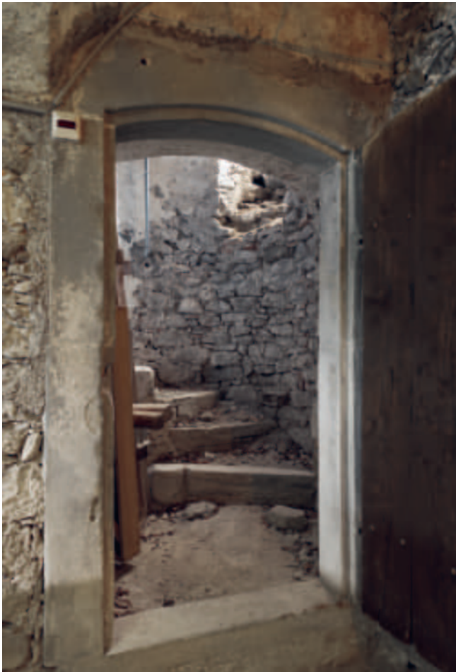
Abb. 272 Der im Keller noch erhaltene Treppenturm führte ursprünglich bis ins Dachgeschoss (DPTG 2021 Lukas Fleischer).
