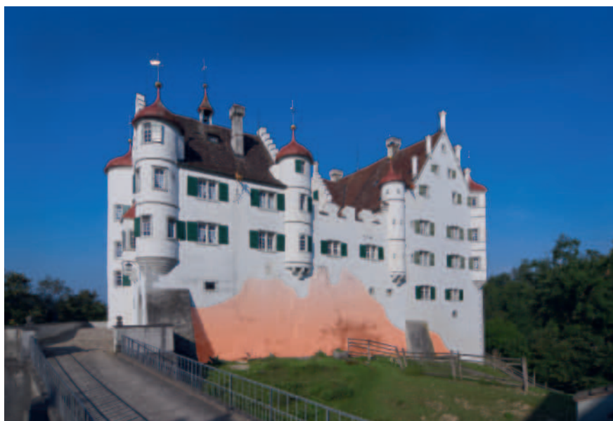
Abb. 234 Die Aussenfassade des Schlosses mit Zwischentrakt und eingezeichnetes, unebenes Mauerwerk – also vermutete Ausdehnung des noch erhaltenen älteren Mauerwerks (DPTG 2021 Lukas Fleischer).
