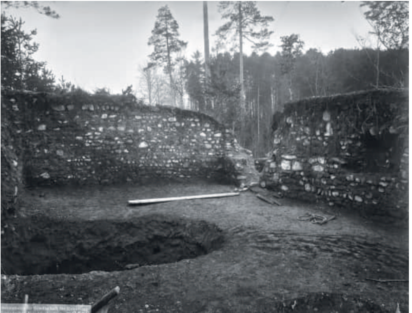
Abb. 65 Die Fotodokumentation des Wohngebäudes nach den Freilegearbeiten 1910. Links im Bild das Loch der Brunnengrabung (Grafische Sammlung SNB 1910 H. Gugolz).
