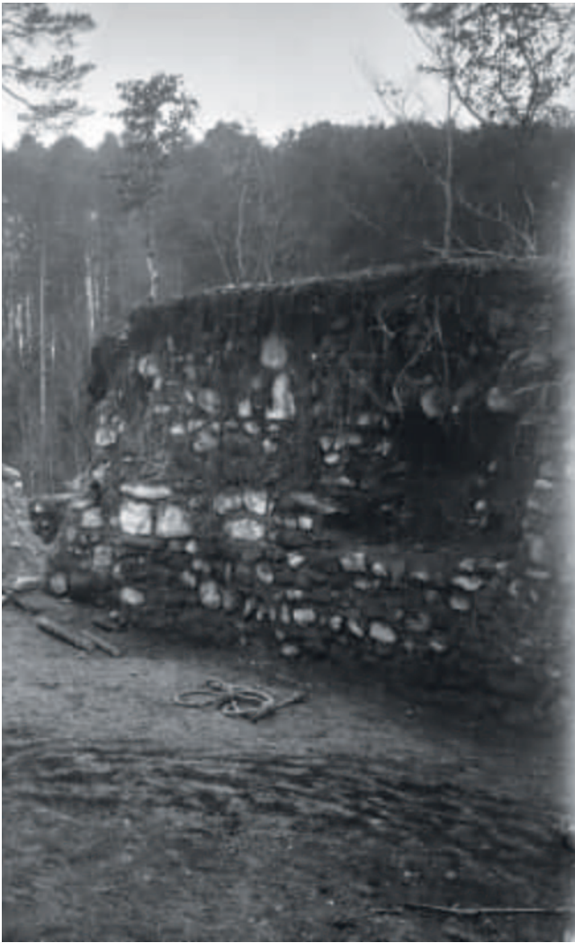
Abb. 214 Eine Wandnische war in der Westwand des Erdgeschosses des Wohngebäudes 1910 erhalten. Das untere Ende der Südlaiung zeigt eine Aussparung (Grafische Sammlung SNB 1910 H. Gugolz).
