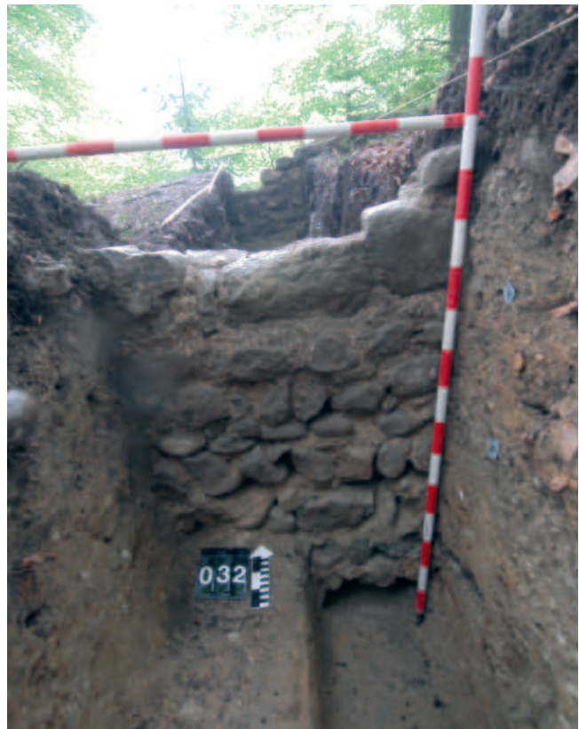
Abb. 76 Der Durchbruch im Mauerfundament der Südmauer des Nebengebäudes (AATG 2014).
