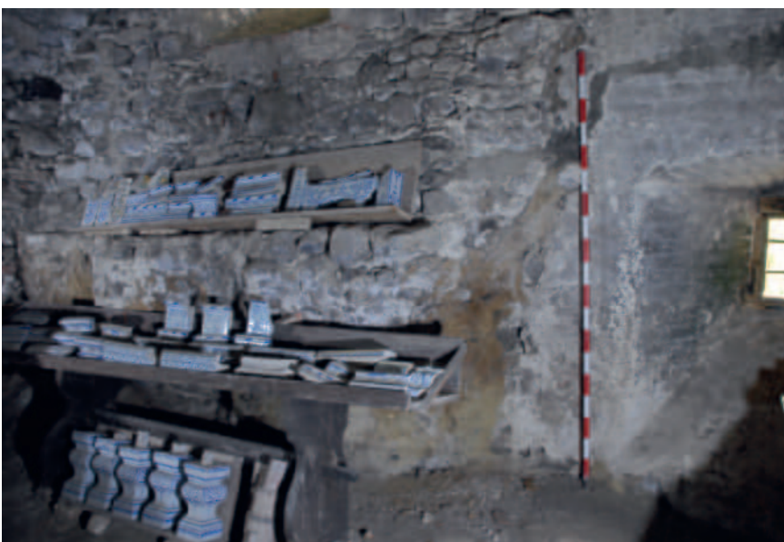
Abb. 227 Detail der Westmauer (R -103): Auf dem Fundamentabsatz sind Kacheln aufgestellt, darunter verjüngt sich die Mauer und die Mauergrube wird fast wie in einem Profil gezeigt (AATG 2021 Iris Hutter).
