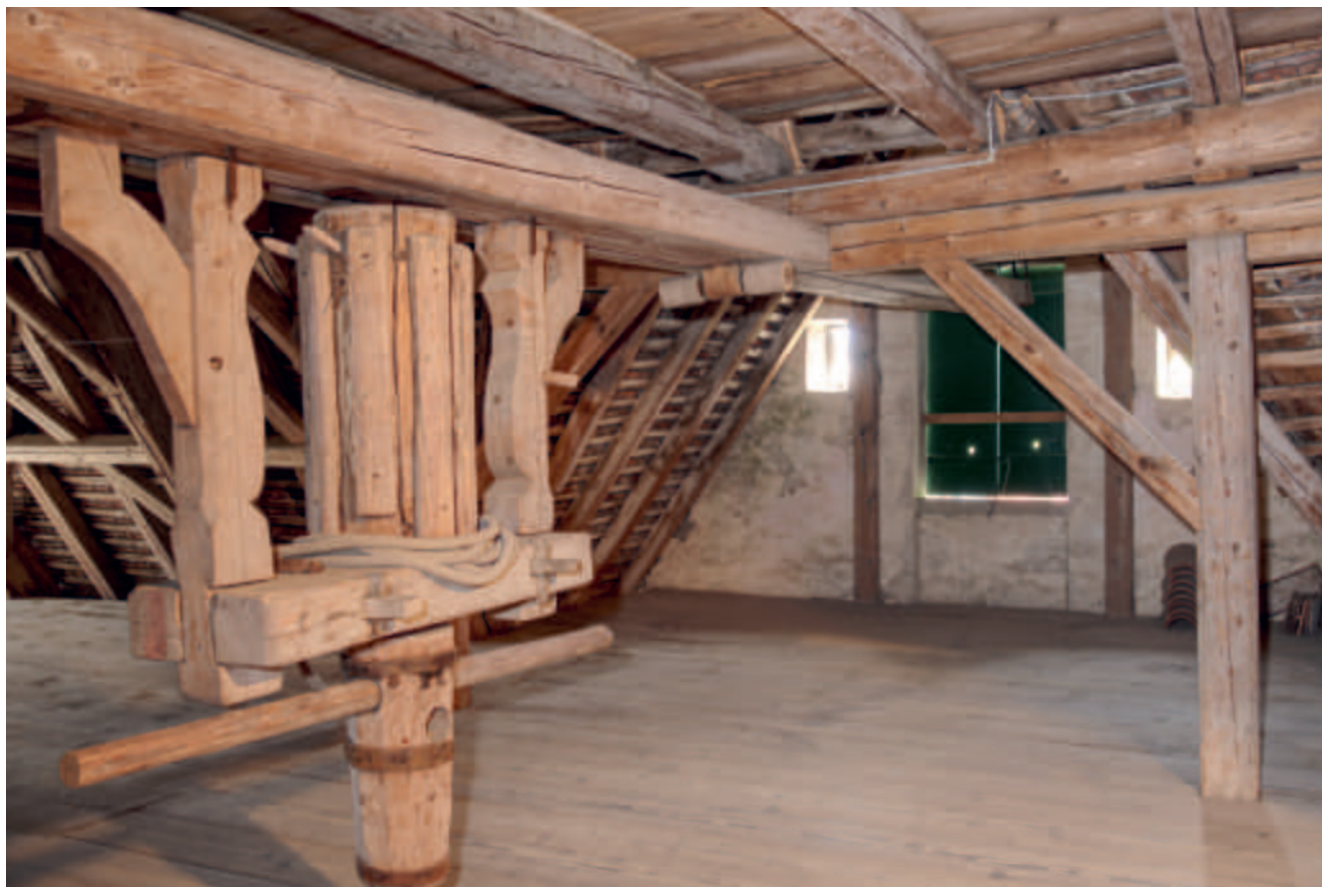
Abb. 285 Die Kranbahn mit Winde im vierten Geschoss des Grossen Schlosses (DPTG 2021 Lukas Fleischer).
