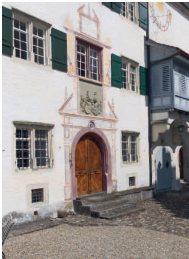
Abb. 342 Die Ostfassade des Schlosses Altenklingen zeigt über jedem Fenster ein kleines Traufgesims, dass aus dem Putz gearbeitet ist (DPTG 2021 Lukas Fleischer).
