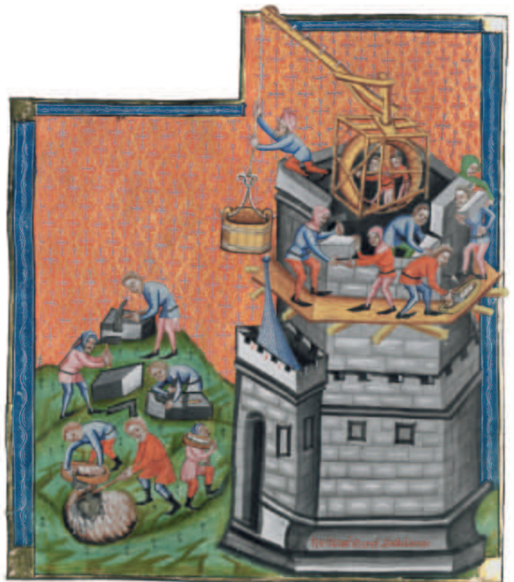
Abb. 170 Abbildung eines Krans mit Tretrad auf einer Baustelle, aus der Weltchronik des Rudolf von Ems, 1383. (Württembergische Landesbibliothek, Cod. bibl. fol. 5 9v).
