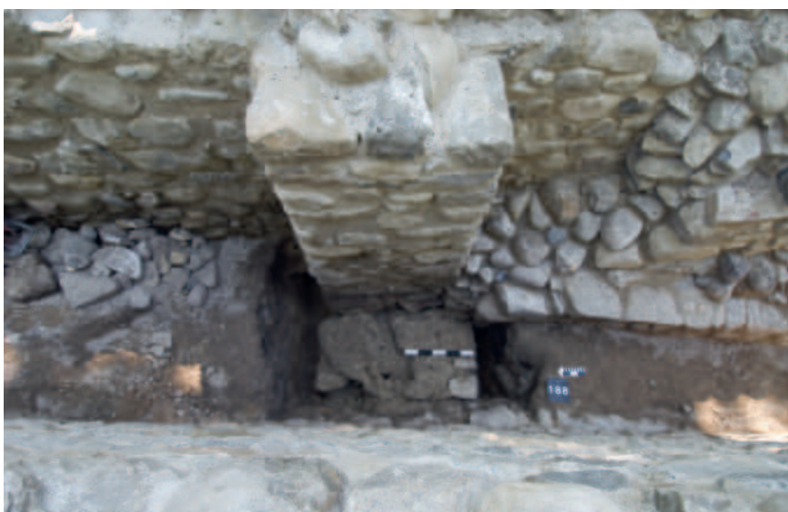
Abb. 41 Östliches Stück des Turms I, anschliessend an Pfeiler der Umfassungsmauer und der Ostmauer des Turms II (AATG 2015 Thomas Keiser).
