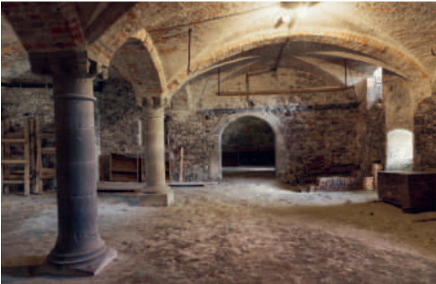
Abb. 270 Zugang zum Südraum aus dem Hauptraum heraus, gegen Süden abgebildet (DPTG 2021 Lukas Fleischer).
