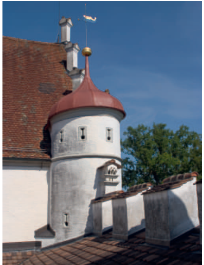
Abb. 346 Der Erker auf Schloss Altenklingen zeigt auf Höhe des dritten Obergeschosses den Kaminausgang aus dem Erkerraum des zweiten Obergeschosses (DPTG 2021 Lukas Fleischer).
