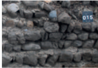
Ostmauer Ökonomiegebäude innen
