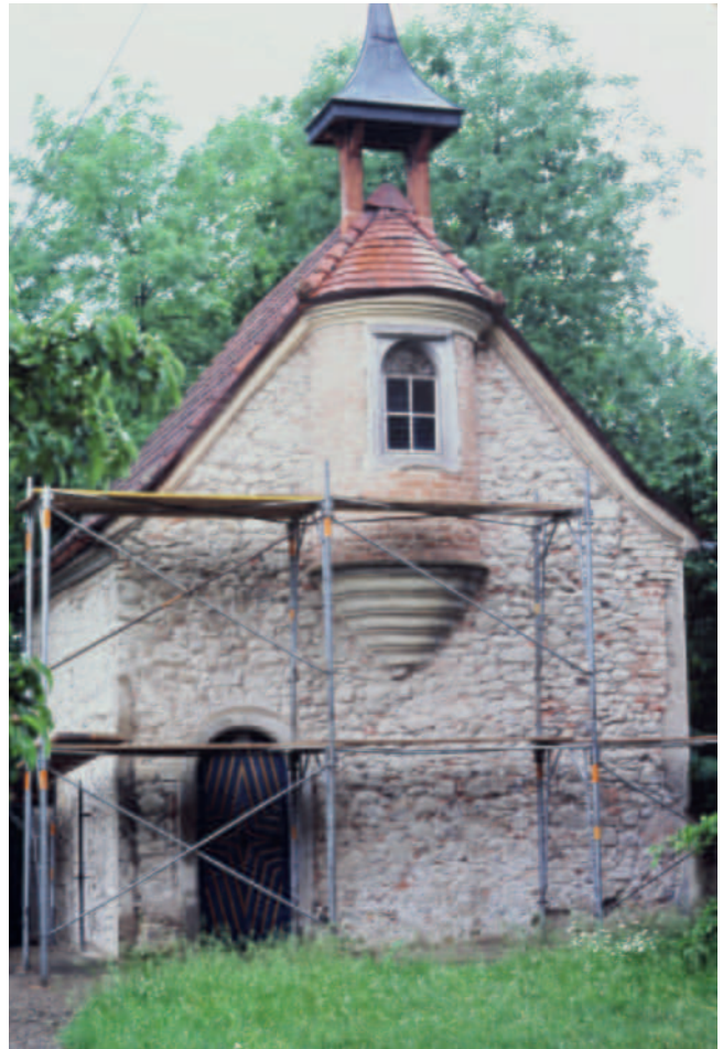
Abb. 305 Die Kapelle, Nordseite mit freigelegtem Mauerwerk während der Fassadenrenovierung 2000 (DPTG 2000).
