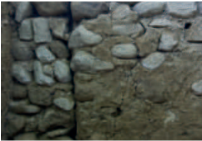
Ostmauer Kapelle aussen
