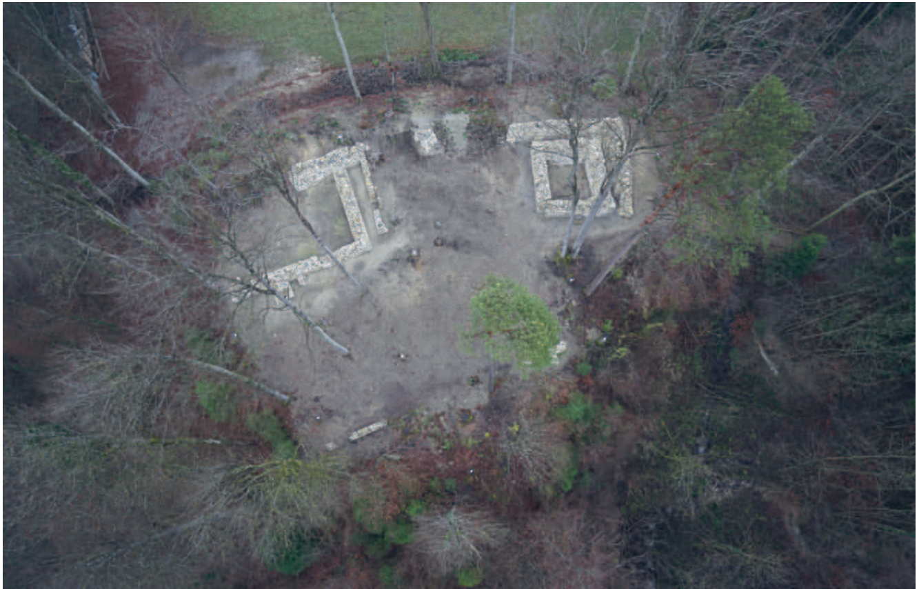
Abb. 6 Luftaufnahme der Ruine Altenburg nach Abschluss der Mauersanierung 2015 (AATG 2015 geotopo AG).
