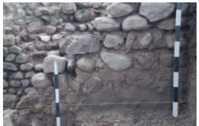
Abb. 211 In Pietra-Rasa-Art verputztes Mauerwerk wurde an der Umfassungsmauer, gleich östlich des Eingangstors, dokumentiert (AATG 2014 Thomas Keiser).
