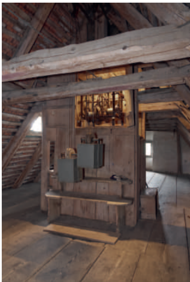
Abb. 296 Das Dachgeschoss des Kleinen Schlosses mit Uhrwerk-Verschlag (DPTG 2021 Lukas Fleischer).
