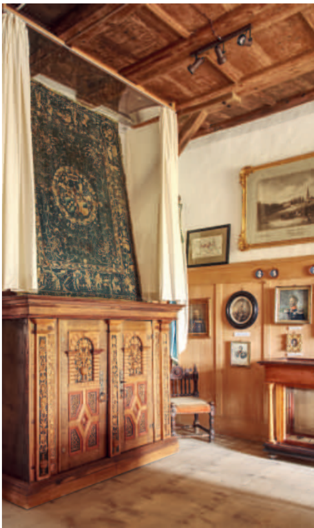
Abb. 321 Zusätzliche Deckenabstützung im Raum 005, der sogenannten Reuterzimmer (DPTG 2021 Lukas Fleischer).
