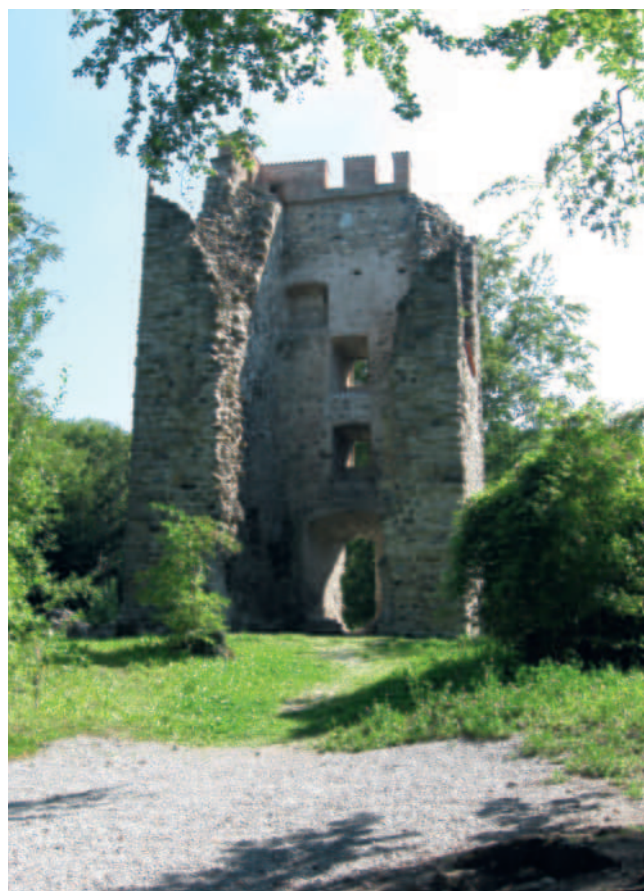
Abb. 241 Der Turm der Ruine Neuburg bei Mammern nach der ersten grossen Sanierung 2001 (AATG 2009 Hansjörg Brem).
