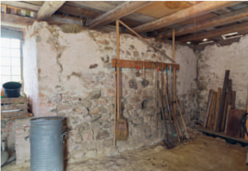
Abb. 225 Die Ostmauer der Remise (R 105) aus Bollensteinen mit Gerüstloch (DPTG 2021 Lukas Fleischer).
