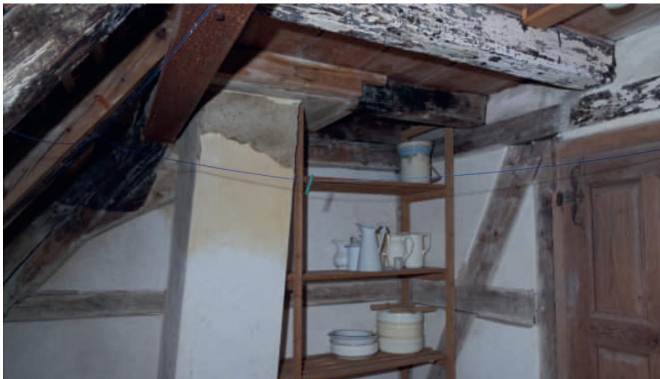
Abb. 295 Ehemalige Rauchkammer im Turmraum des dritten Geschosses des Kleinen Schlosses (DPTG 2021 Lukas Fleischer).
