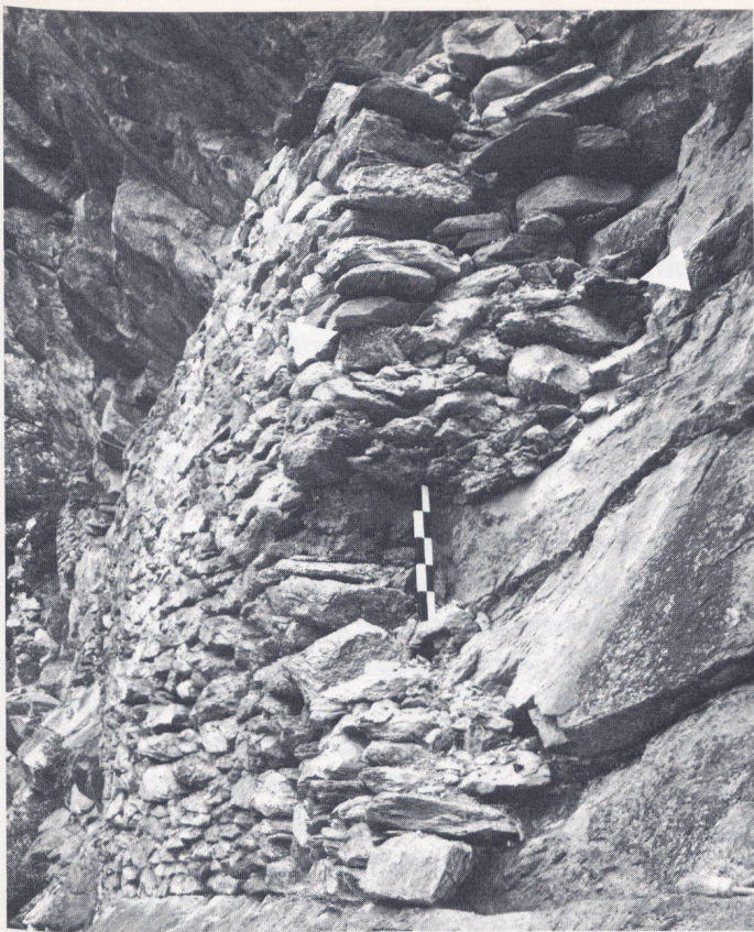
Abb. 142 Malvaglia, Casa dei Pagani. Im grossen Ausbruch der Plattform Mauerwerk der beiden Bauphasen: unterhalb der durch die Pfeile bezeichneten Baufuge jenes der ersten, darüber jenes der zweiten.
