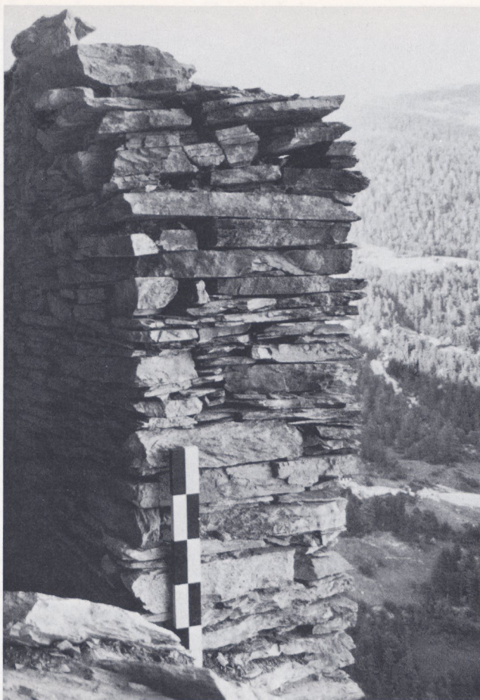
Abb. 144 Mollens 2. Der südliche Abschluss der Trockenmauer M 5 mit dem Gewölbeansatz.
