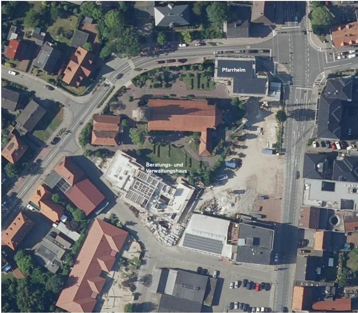
Abb. 1b: Das Untersuchungsgebiet nach Beendigung der Grabung (Neubauten im Jahr 2024).
