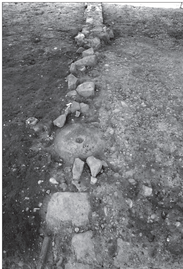
Fig. 1.102 Détail de l'appareil du mur nord du bâtiment F (photo M. Reddé).
