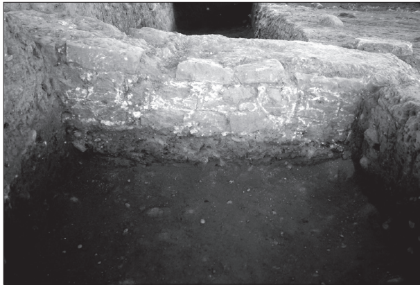
Fig. 1.56 Appareil en petits moellons du bâtiment C (photo M. Reddé).
