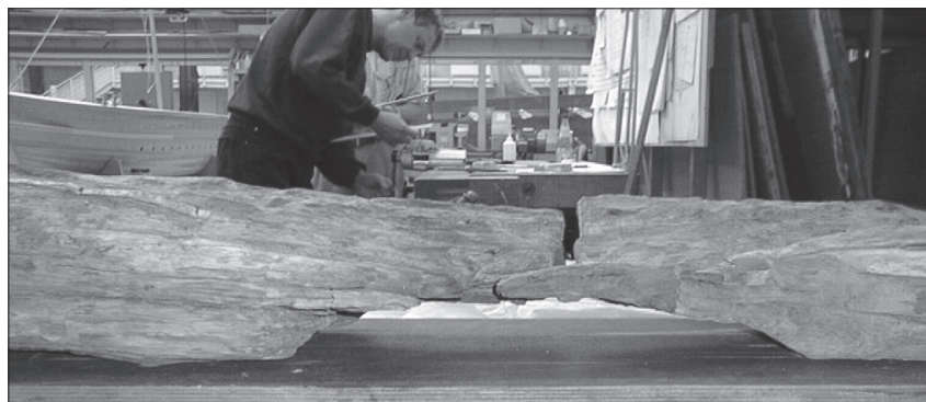
Abb. 8.15 Schwellbalken einer Fachwerkkonstruktion. Bruchstücke B und C. Ausarbeitung (h) an der mutmaßlichen Sohle des Balkens. – ohne M. (Foto Verf.).
