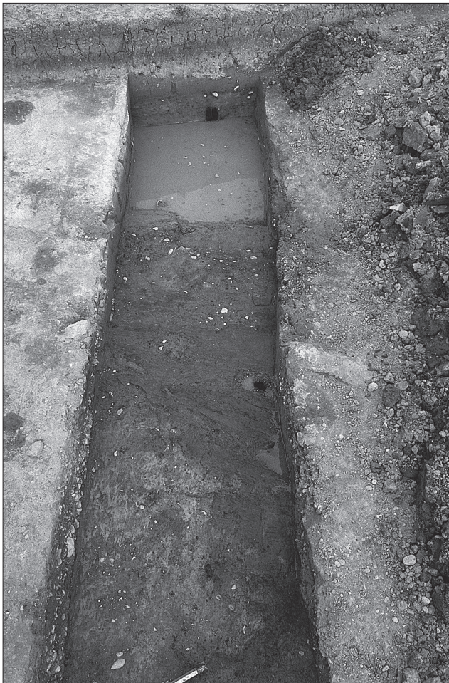
Fig. 5.77 Restes de planchers de bois effondrés au-dessus du paléochenal (photo M. Reddé).
