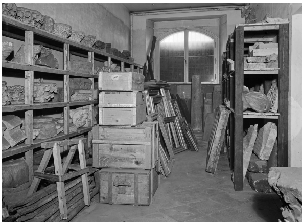
Abb. 3 Luftschutzmaßnahmen im Sockelgeschoss des Landesmuseums 1943.
