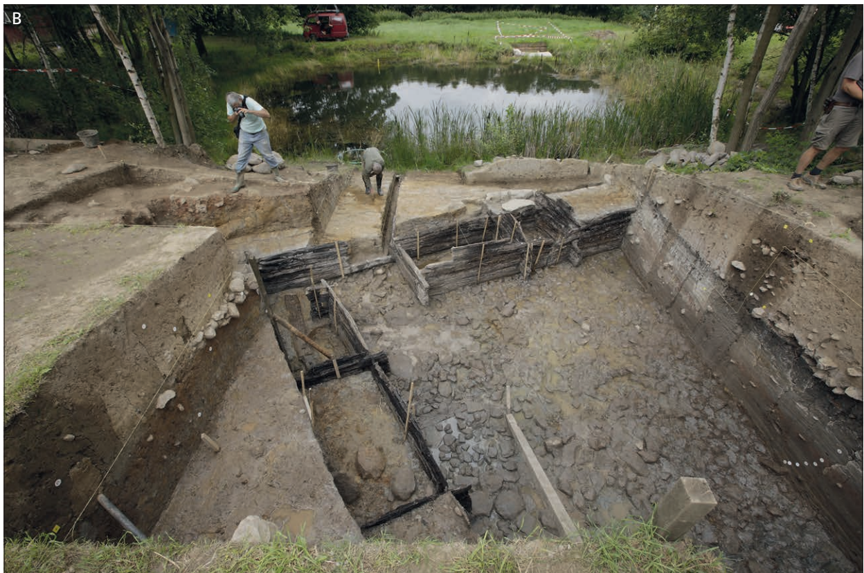
Abb. 154 Vladař-Záhořice (okr. Karlovy Vary). – A Gesamtplan der Ausgrabung der Zisterne 1 und 2 im Areal IV der Vöburg. – B Sondage 1/2010, Zisterne 2. Holzkastenkonstruktion in Blockbauweise und Steinpflasterung auf der Sohle. Blick von Osten. – (Nach Chytráček u. a. 2012).
