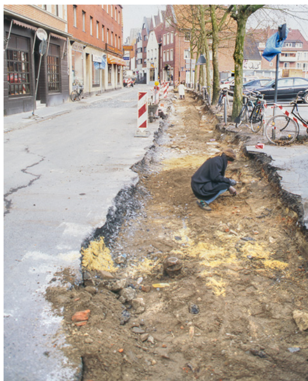
Abb. 3 Blick von Westen in den westöstlich über die Länge des Bürgersteigs gezogenen Schnitt 11.
