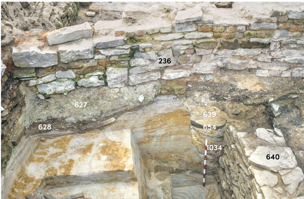
Abb. 58 Blick von Osten auf das Westprofil von Schnitt 9, Bereich A. Unter der Mauer 236 (obere Bildhälfte) ist die Mauer 640 erhalten (unten rechts). Unter der Ausbruchgrube 639 ist ihre Baugrube mit den Schichten 654 und 1034 verfüllt.
