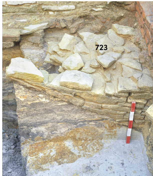
Abb. 66 Blick von Westen auf die Seitenmauer 723 der Kellerrampe des Steinkellers in Schnitt 5, Bereich A.
