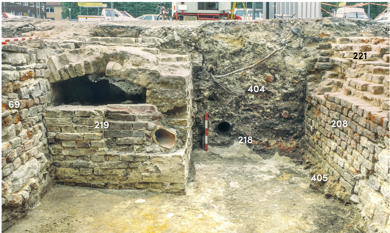
Abb. 94 Blick von Norden auf die in Schnitt 4 an das Haus Nr. 43/44 (Gebäude 26) angebaute Sickergrube, deren Nordwestecke nachträglich für den Einbau eines Kanalrohres durchbrochen wurde.
