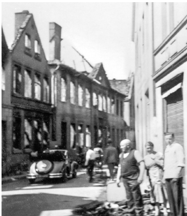
Abb. 34 In den Tagen nach dem Bombenangriff vom 9. Juli wurde der Schaden als »Totalschaden, vollständig ausgebrannt« von der Kriminal-Abteilung des Polizeipräsidenten in Münster beurteilt und im Foto festgehalten.
