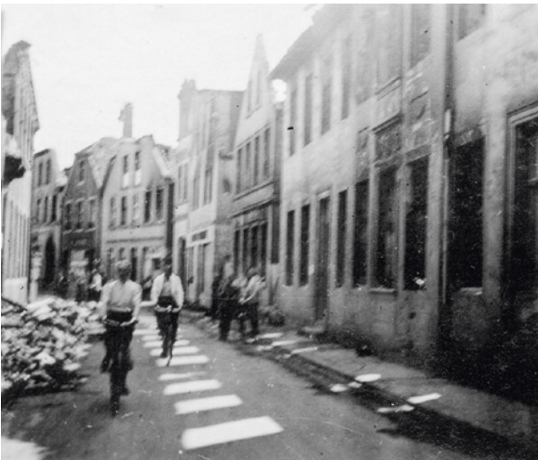
Abb. 109 Blick in die belebte Hörsterstraße mit zerstörten Häusern im Juli 1941.
