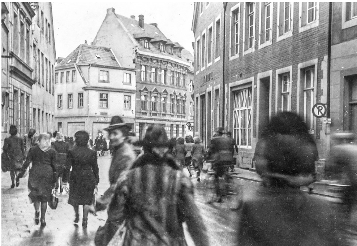
Abb. 36 Blick in die Hörsterstraße, in der die Passanten eilig zum Bunker am Lotharinger-Kloster laufen (März 1944).
