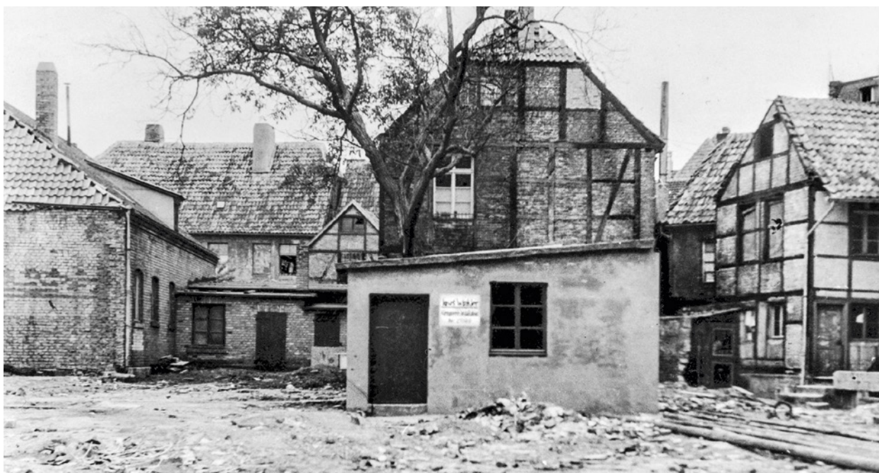
Abb. 23 Blick vom rückwärtigen Grundstück von Hörsterstraße 43/44 auf die Hinterhausbebauung an der Ritterstraße (Juni 1942).
