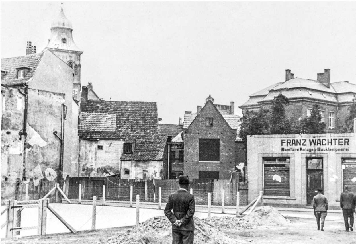
Abb. 37 Der neu angelegte Löschteich auf den Grundstücken Hörsterstraße Nr. 40–42 im August 1943.
