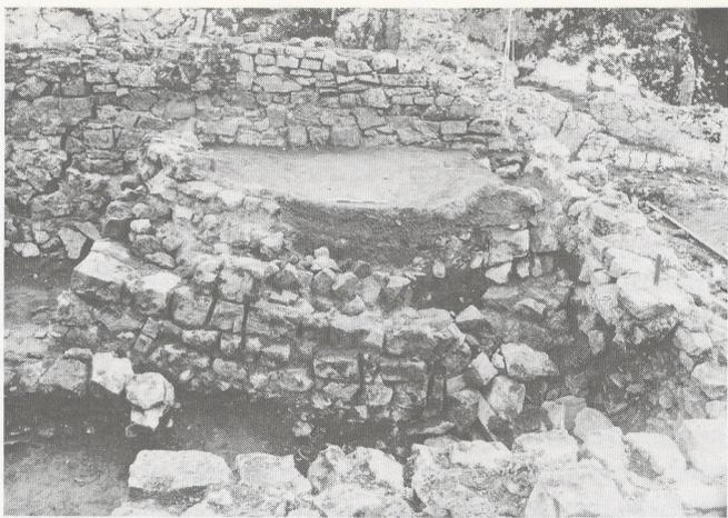
*Truchsessenhaus (Bau 8, Zone K). Fundamente des Backofens. Unter der obersten Feuerfläche liegen die Reste älterer Öfen. Ansicht von Westen, 1974.*
