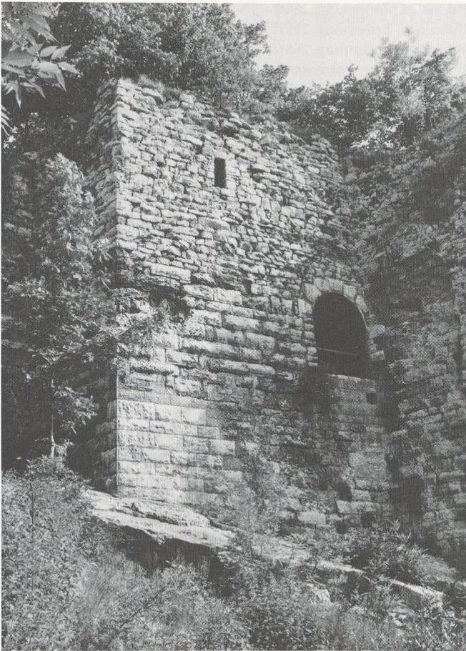
*Vorder-Wartenberg, Torpartie mit Bossenquadern im unteren und quaderförmigen Hausteinen im oberen Bereich. Tor und Eckpartie stark restauriert. Zustand um 1975.*
