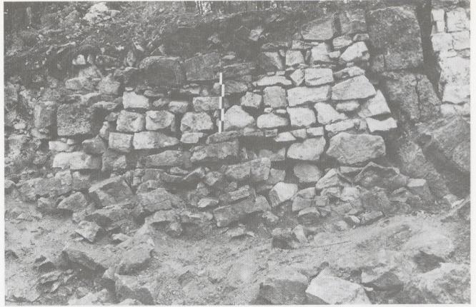
*Schildmauer (Bau 19, M5), Aussenfront des zugemauerten Tores mit verrutschten Gewändsteinen aus Tuff (M51). Ansicht von Norden, 1974.*
