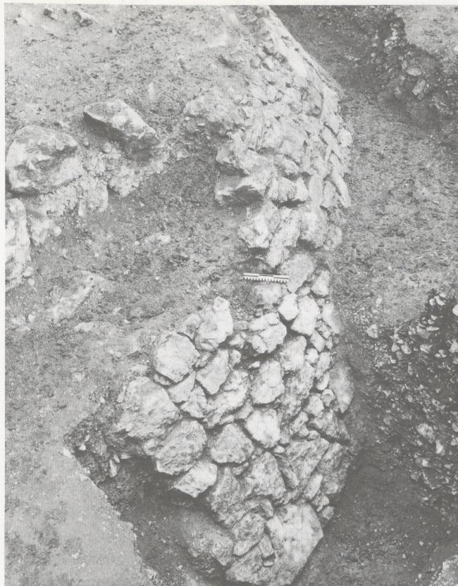
*Gerundete, stark angezogene Stützmauer (M35) im inneren Graben (Fläche K4). Ansicht von Süden, 1974.*
