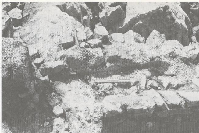
*Viereckhaus, südliche Abschlussmauer (Bau 15). Mauerkrone mit Abdruck eines Schwellenbalkens des aufgesetzten Ständerbaues. Ansicht von Norden, 1976.*
