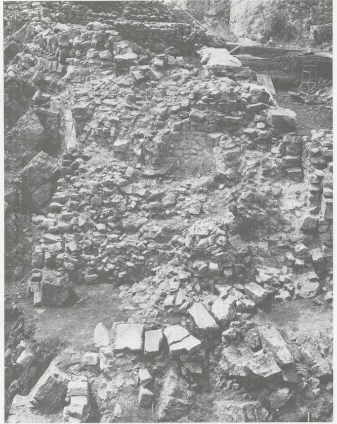
Halsgraben (Zone G), Fundamentreste des Rundturmes (Bau 23). Ansicht von Norden, 1975. Die vorderen, tief liegenden Fundamentpartien sind aus der ursprünglichen Lage gerutscht.
