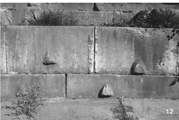
Abbildung 9 Sunion, späarchaischer Poseidontempel, um 490–480 v. Chr., Stufenblock mit Buckelbossen und Buchstabenzeichen. – Abbildung 10 Thorikos, Säulenhalle, um 420/410 v. Chr. – Abbildung 11 Rhamnus, Nemesistempel, um 430/420 v. Chr., Orthostat mit Buckelbossen und Buchstabenzeichen. – Abbildung 12 Delphi, Theater, um 167 v. Chr., Stemmboesen an der untersten Stufenreihe. – Abbildung 13 Milet, römische Säulenhalle im Delphinion, zweites nachchristliches Jahrhundert. – Abbildung 14 Pompeji, Zentralthermen, 79 n. Chr., Stemmlöcher und -bossen am unfertigen Stylobat. – Abbildung 15 Athen, Akropolis, Statuenbasis Inv. Ακρόπολης 13213, um 480 v. Chr. – Abbildung 16 Delphi, Basis aus dem Weihgeschenk der Arkader, 369–362 v. Chr.
