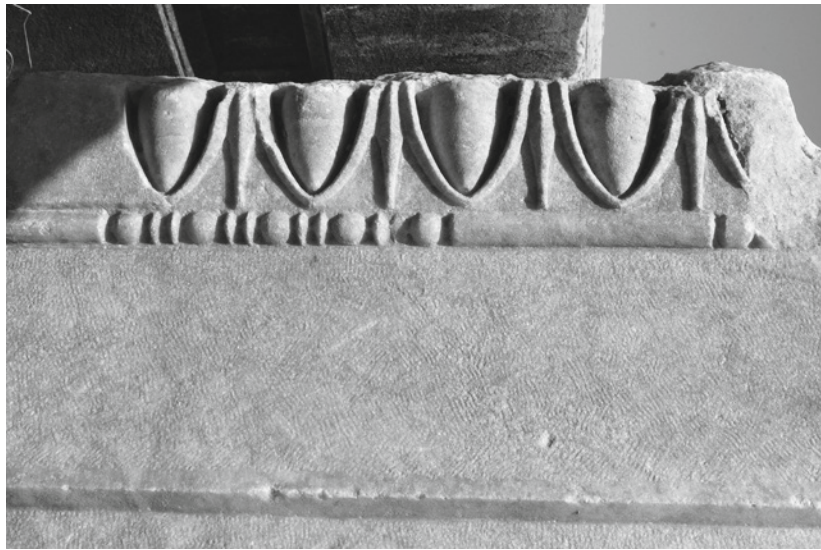
Abbildung 39 Kassettenrahmungsblock B02/850 der unteren Schicht, links mit unskulptierten Randbereichen von Perl- und Eierstab, rechts nur mit unfertigem Perlstab.
