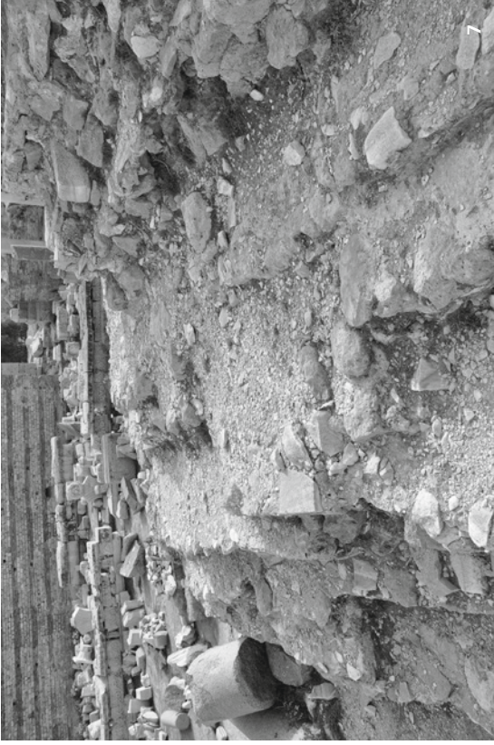
Figure 7 e 8 Leptis Magna, Foro Severiano. Tempio della Gens Septimia, dettaglio della parte superiore del nucleo cementizio della scalinata con evidente impiego di scaglie marmoree in marmo proconnesio e calcare locale (7). Portici, muro nord-ovest, dettaglio dello strato di allettamento dei rivestimenti parietali con impiego di scaglie marmoree in proconnesio (8).
