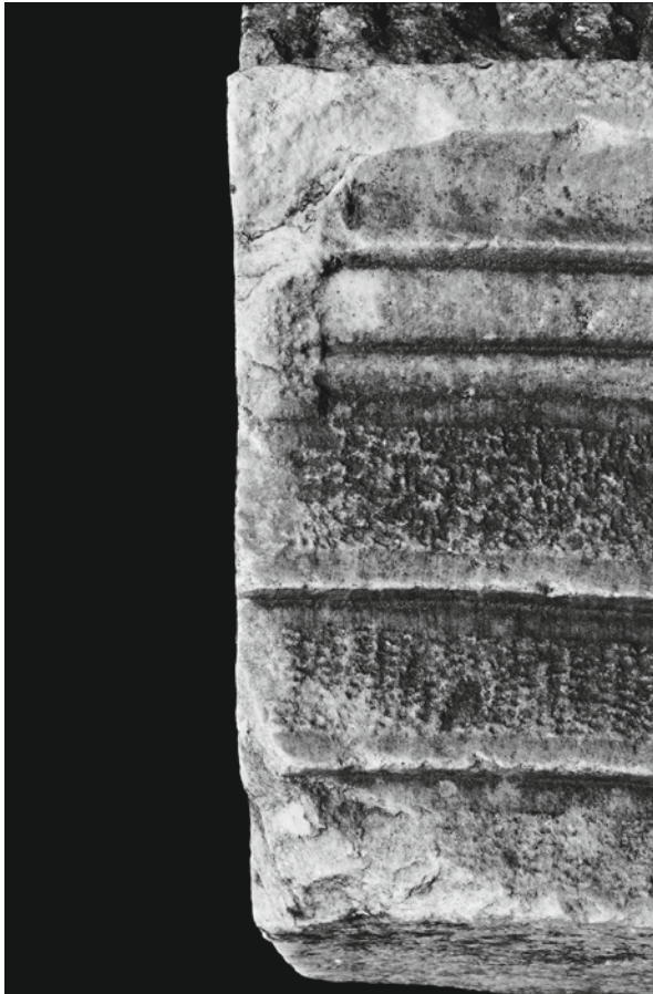
Abbildung 11 Aphrodisias, sog. Agora-Gate, Architrav-Fries mit Kantenschutz im Bereich des Kopfprofils über den Faszien (nach Paul, Aphrodisias [Anmerkung 45] Abb. 17.11).
