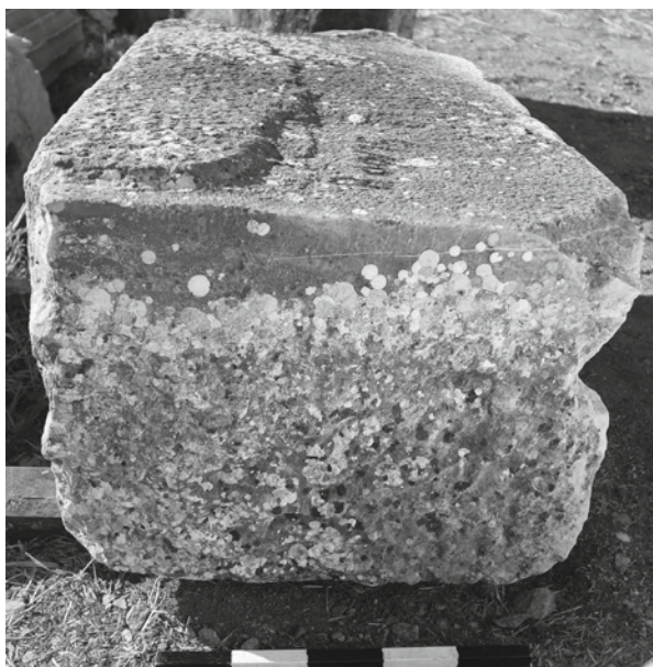
Abbildung 28 (oben) Dorischer Architrav der Westseite mit Kantenschutzbossen an den Seiten und entlang der Unterkante. – Abbildung 29 (unten) Östlicher Sockelwandblock B00/15 der Schicht 12, im Vordergrund rechte Seitenfläche, oben Sichtfläche mit drei Stadien der Spitzeisenabarbeitung, an der Kante zur Seitenfläche ein Zahneisenstreifen.
