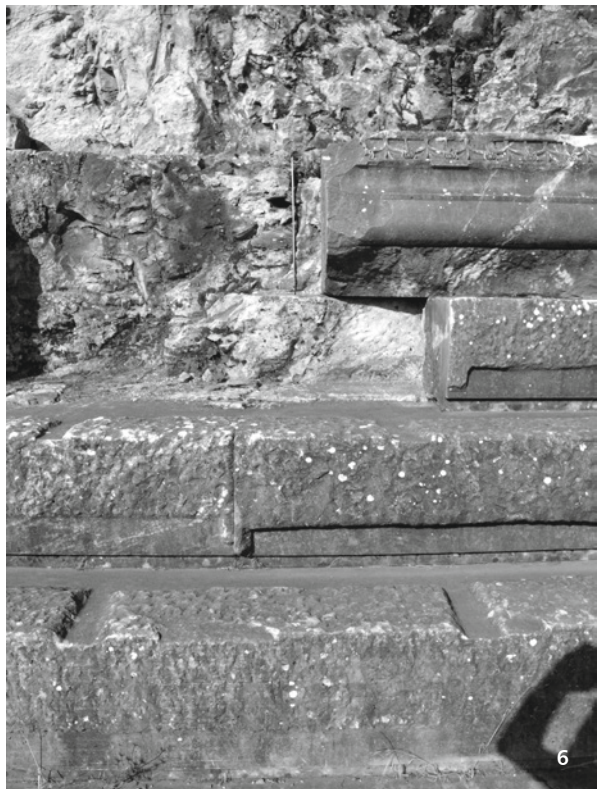
Krepis. – Abbildung 4 Draufsicht im Osten, Trittstufen rechts mit Bossen, links abgearbeitet. – Abbildung 5 Draufsicht im Norden, Trittstufen mit Bossen und Querschlägen, knapp davor der noch anstehende Fels.– Abbildung 6 Im Osten, mit Bossen und Kantenschutzstegen.
