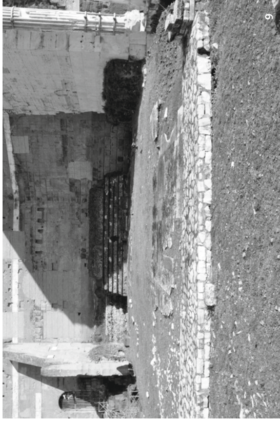
Figure 9 e 10, Roma, Foro di Augusto, Tempio di Marte Ultore, cella (9) e dettaglio del nucleo cementizio del podio con uso di scaglie marmoree, visibili a sinistra del basamento gradinato della cella (10).
