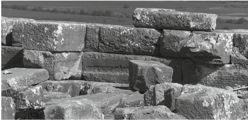
Abbildung 47 Reste der Nordfront des Hofes im Obergeschoss mit Bossen und unregelmäßigen Fugen, an der ersten aufgehenden Schicht glatter Anschlussstreifen für die verlorenen Bodenplatten.
