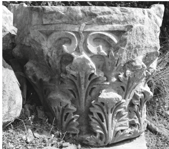
Korinthische Kapitelle. – Abbildung 9 (links) Fehlende Abakusecke und Stiftloch für Anstückung. – Abbildung 10 (rechts) Oben der weitgehend abgearbeitete Abakus für die Aufnahme des Architraves.
