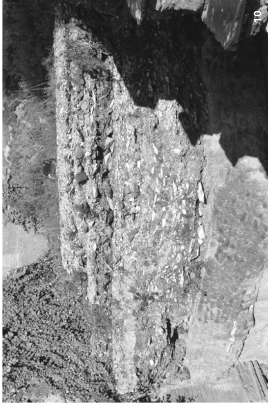
Figure 9 e 10, Roma, Foro di Augusto, Tempio di Marte Ultore, cella (9) e dettaglio del nucleo cementizio del podio con uso di scaglie marmoree, visibili a sinistra del basamento gradinato della cella (10).
