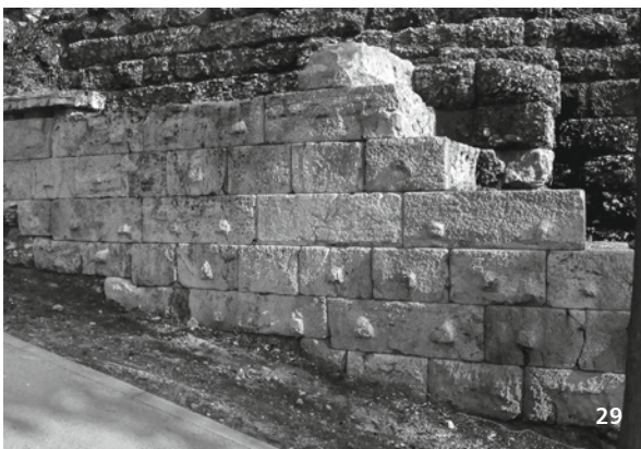
Abbildung 28 Athen, Propyläen der Akropolis, Ostansicht des Nordflügels, 437–432 v. Chr. – Abbildung 29 Athen, Dionysostheater, westliche Stützmauer der Zuschauerränge, um 325 v. Chr. – Abbildung 30 Selinunt, straßenbegleitende Stützmauer westlich hinter Tempel D, viertes Jahrhundert. – Abbildung 31 Didyma, Apollontempel, Südwand, drittes Jahrhundert, Werkzoll und Buckelbossen mit Buchstabenkürzeln, die Kürzel sind leicht hervorgehoben.
