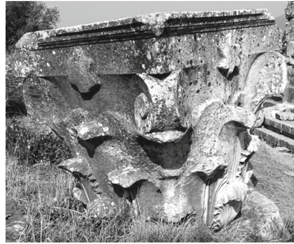
Unvollendete Peristasiskapitelle. - Abbildung 40 BoI/473, vermutliche Vorderseite mit unausgearbeiteten Zonen zwischen zweitem Blattkranz und Abakusprofil. - Abbildung 41 BoI/473, links Seitenfläche, rechts vermutlich Rückseite mit unausgearbeiteten Zonen auch am zweiten Blattkranz und Spitzeisen Spuren auf Caules und darüber aufsteigenden Hüllblättern.
