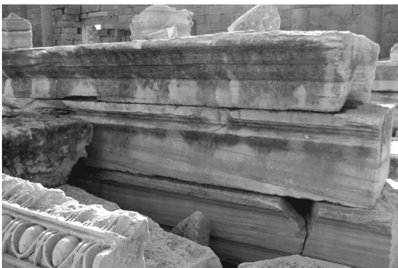
Figura 20 Leptis Magna, Basilica Severiana, trabeazione in marmo proconnesio (cat. BS Tr 01) del secondo ordine con superfici e modanature lisce lasciate in diversi stadi di semirifinitura sul lato posteriore.
