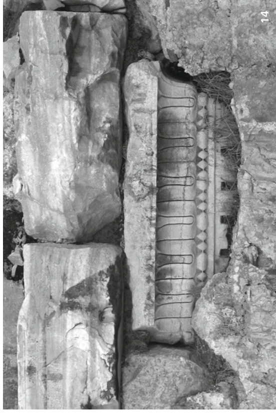
Figure 13 e 14 Leptis Magna, Foro Severiano. Tempio della Gens Septimia, lato settentrionale del podio (13); particolare del nucleo cementizio del podio in cui è impiegato come inerte un elemento in calcare delle trabeazioni sporgenti del Complesso Severiano (14).
