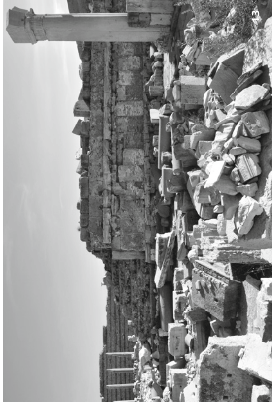
Figure 13 e 14 Leptis Magna, Foro Severiano. Tempio della Gens Septimia, lato settentrionale del podio (13); particolare del nucleo cementizio del podio in cui è impiegato come inerte un elemento in calcare delle trabeazioni sporgenti del Complesso Severiano (14).
