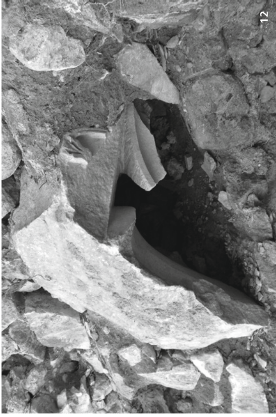
Figure 11 e 12 Cyzicus, Tempio di Zeus. Nucleo cementizio del podio del tempio (11) e dettaglio del nucleo cementizio del podio in cui è impiegato come inerte un grande frammento di capitello corinzio (12).
