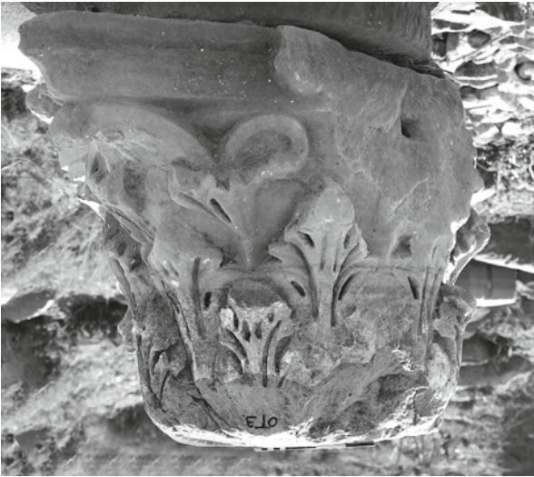
Korinthische Kapitelle. – Abbildung 9 (links) Fehlende Abakusecke und Stiftloch für Anstückung. – Abbildung 10 (rechts) Oben der weitgehend abgearbeitete Abakus für die Aufnahme des Architraves.
