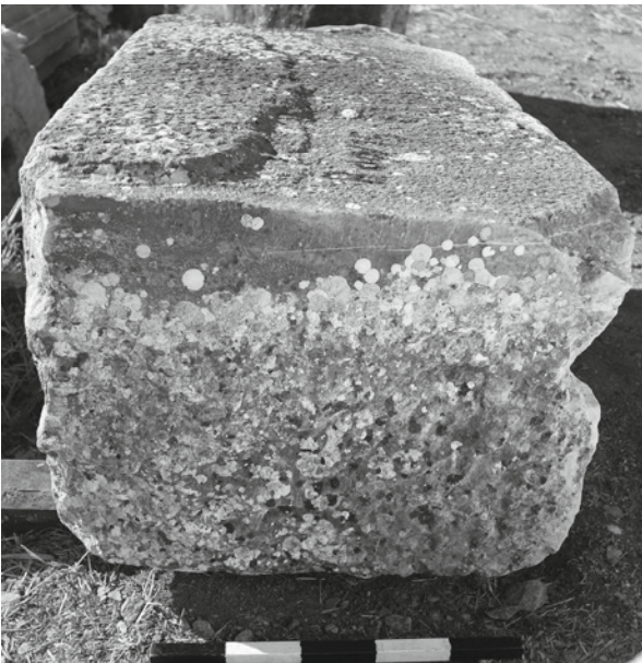
Abbildung 28 (oben) Dorischer Architrav der Westseite mit Kantenschutzbossen an den Seiten und entlang der Unterkante. – Abbildung 29 (unten) Östlicher Sockelwandblock B00/15 der Schicht 12, im Vordergrund rechte Seitenfläche, oben Sichtfläche mit drei Stadien der Spitzeisenabarbeitung, an der Kante zur Seitenfläche ein Zahneisenstreifen.
