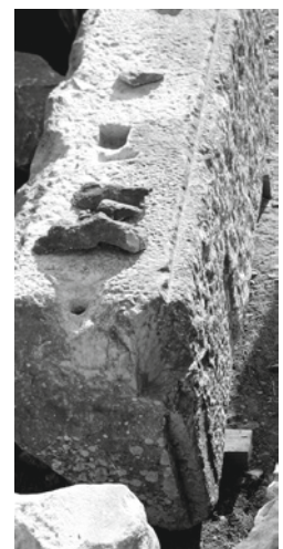
Abbildung 44 Wandabschlussprofil B03/1476 der Nordfront im Obergeschoss mit unfertigen Randbereichen von Perl- und Eierstab. – Abbildung 45 Unausgearbeiteter Wandfriesblock D1368 der Nordfront im Obergeschoss von oben, rechts Vorderseite mit vorstehender Bosse und begonnener Spitzeisenabarbeitung, auf der linken Blockseitenfläche Anschluss zur Scheintür.
