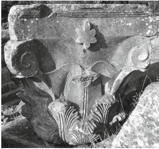
Unvollendete Peristasiskapitelle. - Abbildung 40 BoI/473, vermutliche Vorderseite mit unausgearbeiteten Zonen zwischen zweitem Blattkranz und Abakusprofil. - Abbildung 41 BoI/473, links Seitenfläche, rechts vermutlich Rückseite mit unausgearbeiteten Zonen auch am zweiten Blattkranz und Spitzseisen Spuren auf Caules und darüber aufsteigenden Hüllblättern.
