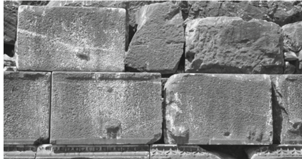
Abbildung 11 Östliche Sockelwandblöcke, unten Anlaufblöcke DO-04 bis DO-07 der Schicht 6 mit Randbossen, links oben Block DO-02 aus Schicht 8 mit erster Spitzseisenabarbeitung.
