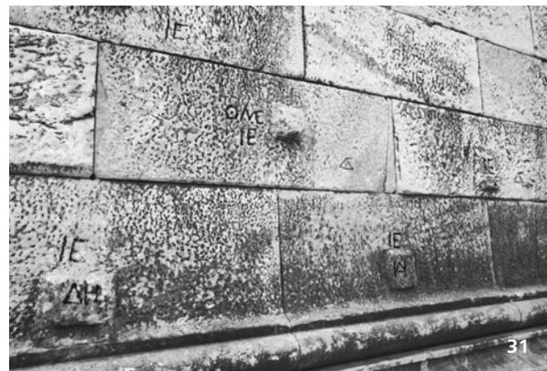
Abbildung 28 Athen, Propyläen der Akropolis, Ostansicht des Nordflügels, 437–432 v. Chr. – Abbildung 29 Athen, Dionysostheater, westliche Stützmauer der Zuschauerränge, um 325 v. Chr. – Abbildung 30 Selinunt, straßenbegleitende Stützmauer westlich hinter Tempel D, viertes Jahrhundert. – Abbildung 31 Didyma, Apollontempel, Südwand, drittes Jahrhundert, Werkzoll und Buckelbossen mit Buchstabenkürzeln, die Kürzel sind leicht hervorgehoben.
