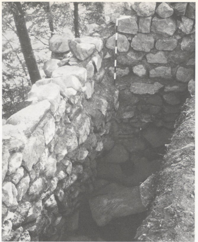
Nordostecke des Palas, innen.
