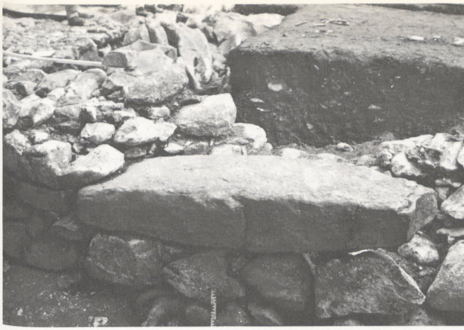
Ausfallpfortchen von aussen, nach der Freilegung.
