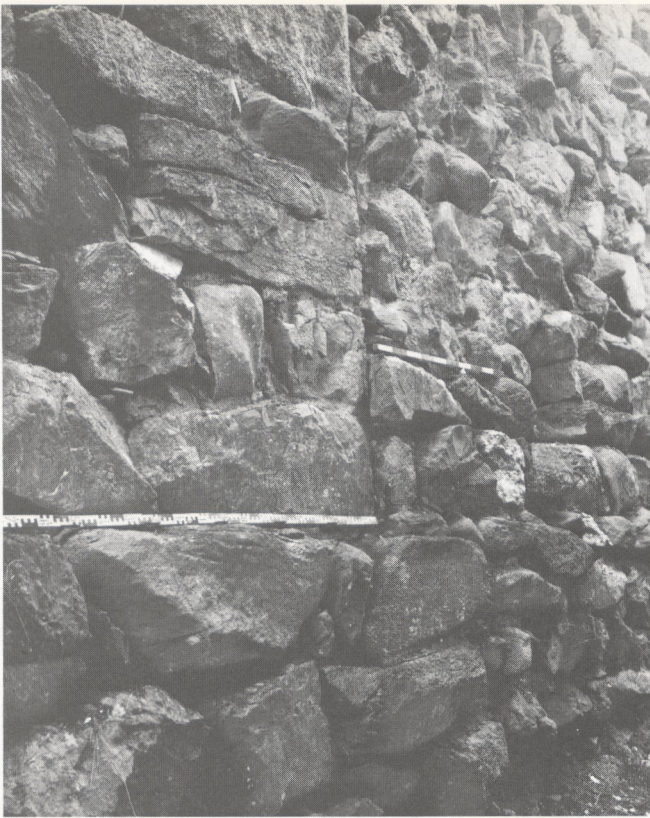
Übergang vom Bergfried zur südlichen Ringmauer.
