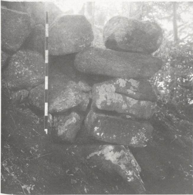
Nordostecke des Palas, aussen.
