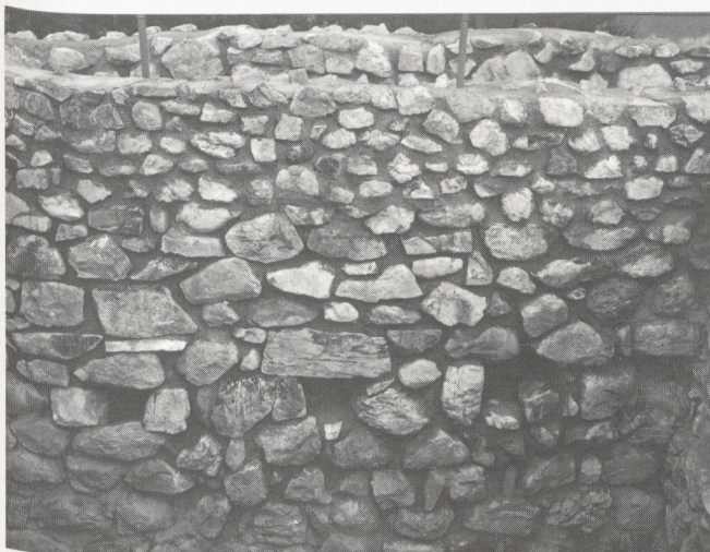
Balkenlöcher für den untersten «Wohnraum» im Bergfried.
