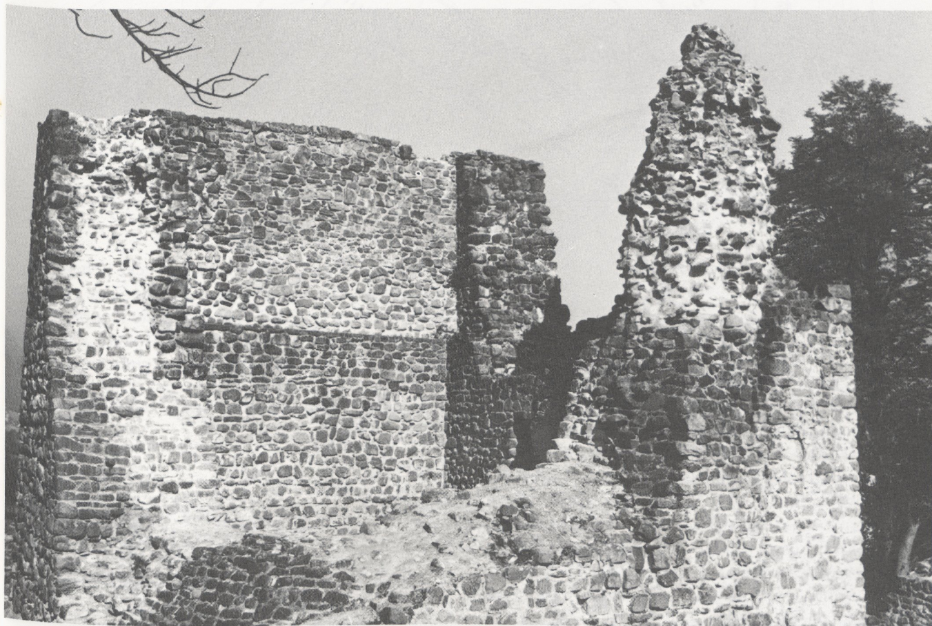
Attinghausen, Ansicht des Turmes von Süden.
