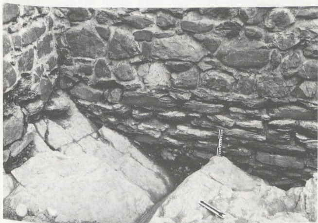
△ Attinghausen, Schnitt S2, Mauerecke mit älterem Fundament.
