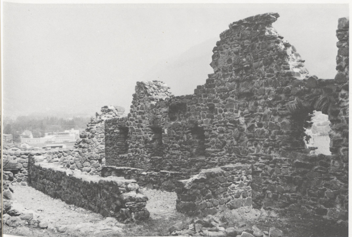
▽ Attinghausen, Südosttrakt, Inneres.
