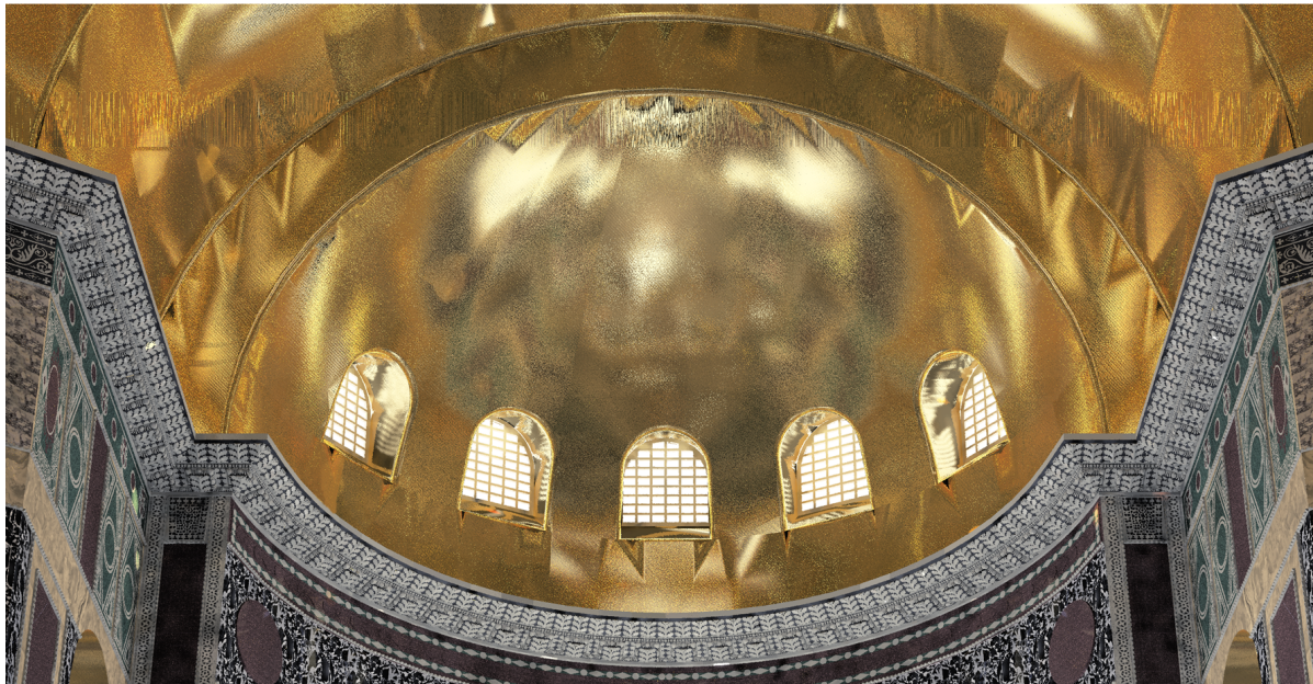
Abbildung 9.4: Darstellung des Goldmosaiks wie auf den Renderings der bisherigen Publikationen. Die Oberfläche gleicht mehr einem dünnen Blech. Eine Einstellung der roughness in Kombination mit den gewählten Renderingparametern ergibt eine Annäherung an die Charakteristik des realen Materials. Man kann auch einige zackige Artefakte erkennen, die aus der groben Auflösung der zweiachsig gekrümmten Geometrie in Dreiecke resultieren.
