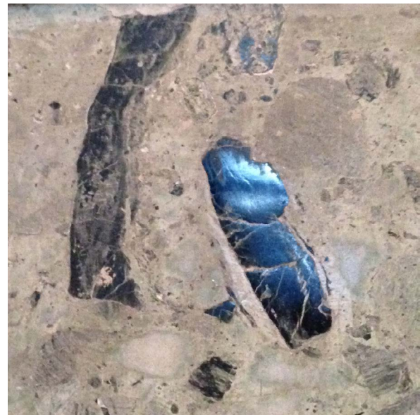
Abbildung 7.6: Unterschiedlicher Glanz der dunklen Einschlüsse im Verde antico. Zustand 2015.
