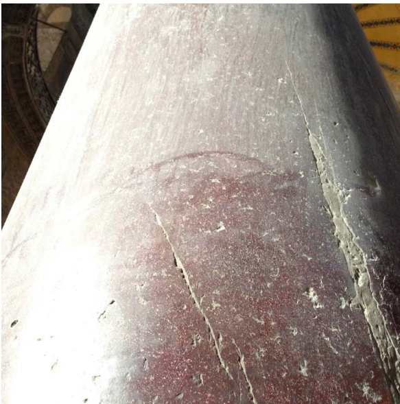
Abbildung 7.5: Veränderung von Farbe, Helligkeit und Glanz durch die Verschmutzung der Oberflächen am Beispiel einer Säule aus rotem Porphyry. Zustand 2015.
