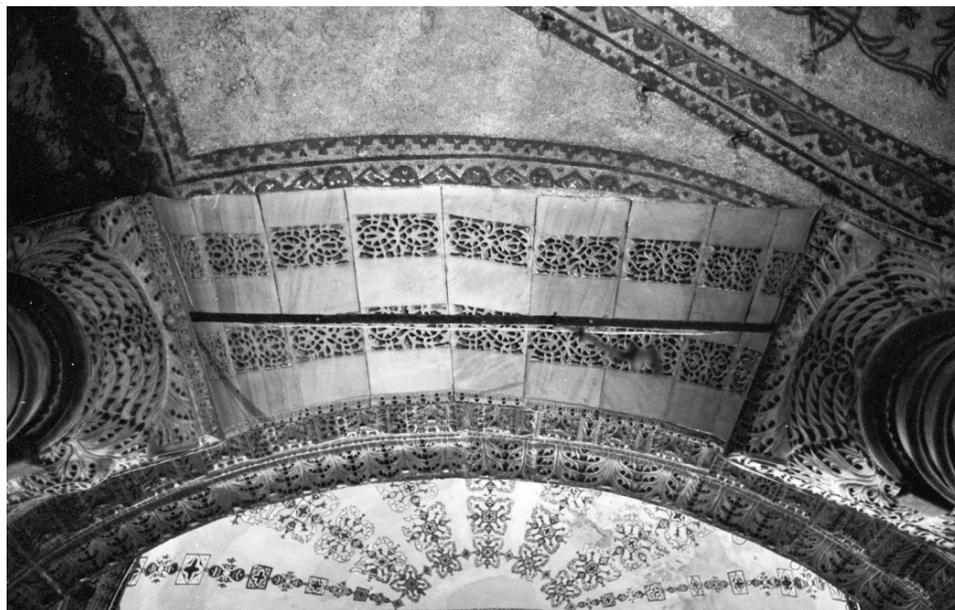
Abbildung 4.13: Die Steinverkleidung der Konchenbögen im Erdgeschoss. Zustand 2001.
