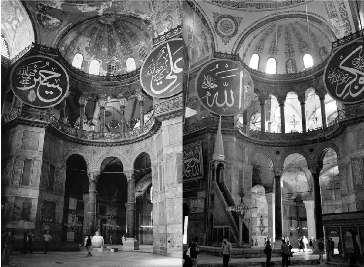
Abbildung 4.14: Varianten der Konstruktion der Konchen: Links die Konche im Nord-Westen, rechts die im Süd-Osten des Gebäudes. Man beachte die unterschiedliche Länge der Säulen. Aus ihnen resultieren unterschiedliche Höhen der Kämpferpunkte und veränderte Proportionen des Opus-sectile-Feldes. Letzteres reicht an der Wand im Nord-Westen bis an die Unterkante des Onyx-Bandes im Süd-Osten bis an die Oberkante hinab. Zustand 2001.
