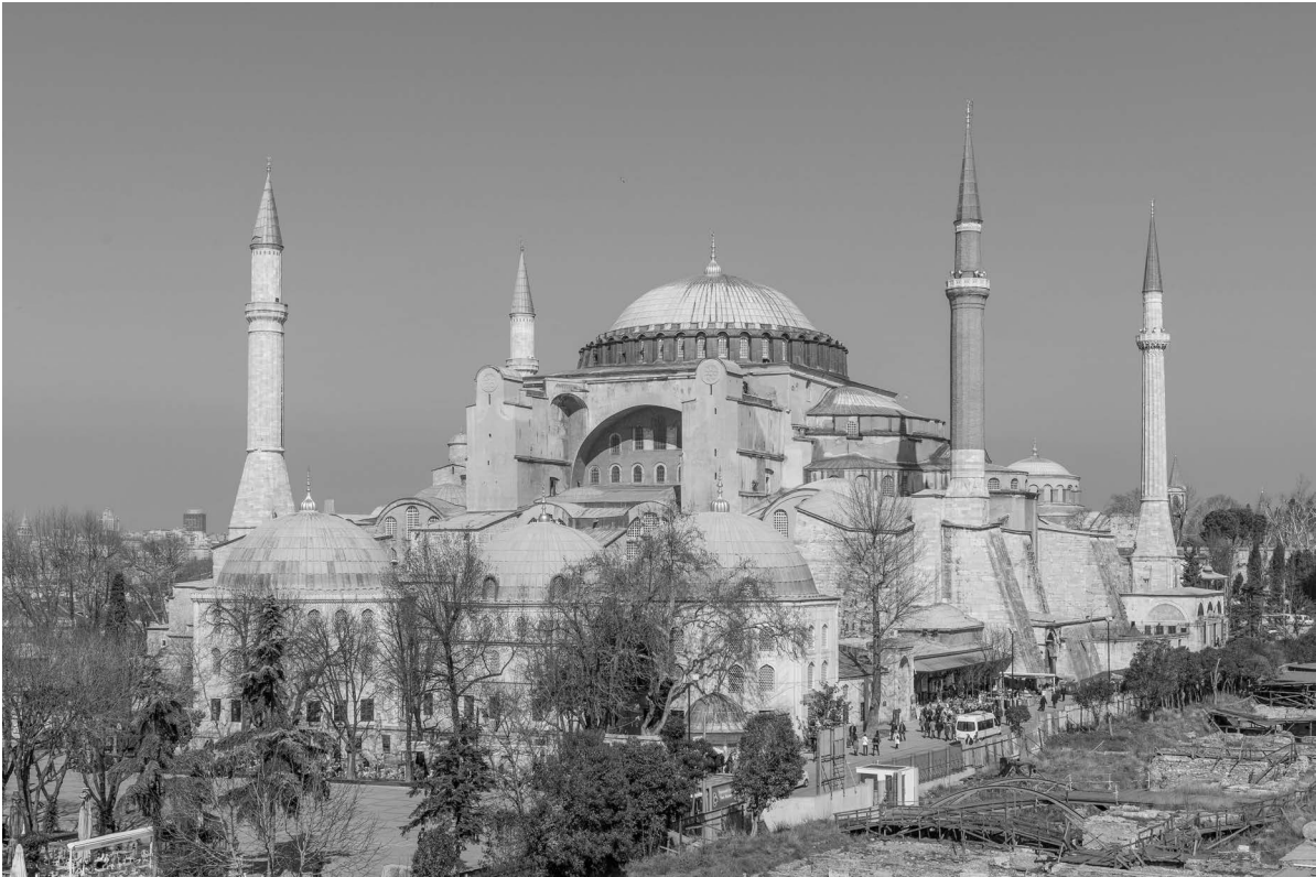
Abbildung 1.2: Außenansicht der Hagia Sophia von Südosten. Die oberhalb der Galerien liegenden Bögen und Stützpfeiler auf der Südseite sind links der Bildmitte in ihrer Größe deutlich zu erkennen. Quelle: Arild Vågen ( https://commons.wikimedia.org/wiki/File:Hagia_Sophia_Mars_2013.jpg ), „Hagia Sophia Mars 2013“, umgewandelt in Graustufen, https://creativecommons.org/licenses/by-sa/3.0/legalcode .
