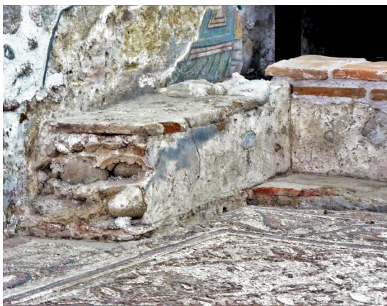
Abb. 3 Ausschnitt aus der an den Mauern entlang laufenden Sitzbank, hier die Ecke Nordwand/Westwand der Bischofskirche in Partikopolis (Sandanski, BG). Die aus Natursteinen gemauerte Bank ist mit Ziegeln als Sitzfläche versehen und verputzt. Darauf sind Polster/Kissen vorstellbar. 5./6. Jh. (R. Sörries)
