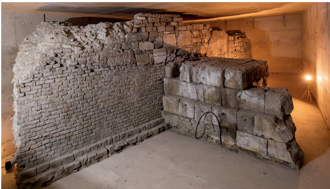
Abb. 3 Das nördlichste Hafentor der CCAA unter dem Kurt-Hackenberg-Platz in Köln (Foto Michael Bause)
