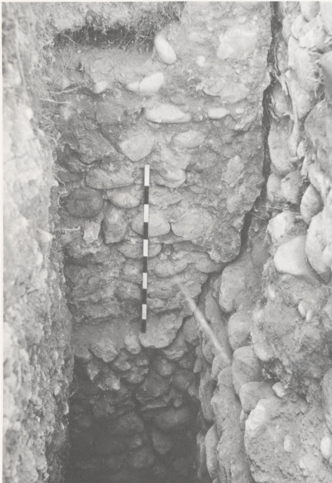
Abb. 51 Baufuge zwischen gestrafter Zwingermauer und vorgestellter Ringmauer
