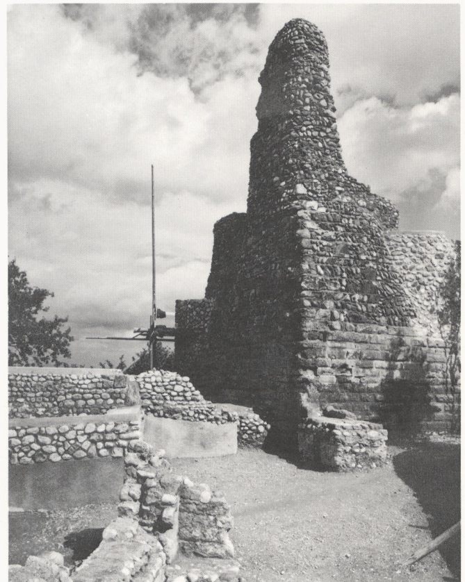
Abb. 76 Konserviert 1957. Rechts Mantelanschluß am 1909 konservierten «Zahn». In der Mitte am Turmsockel Substruktion für Turmaufgang der Wohnphase III. Ganz links neue Untermauerung des Stallsockels der Wohnperiode II. Davor links innere Zwingerecke. Bodenniveau = erster Wohnhorizont
