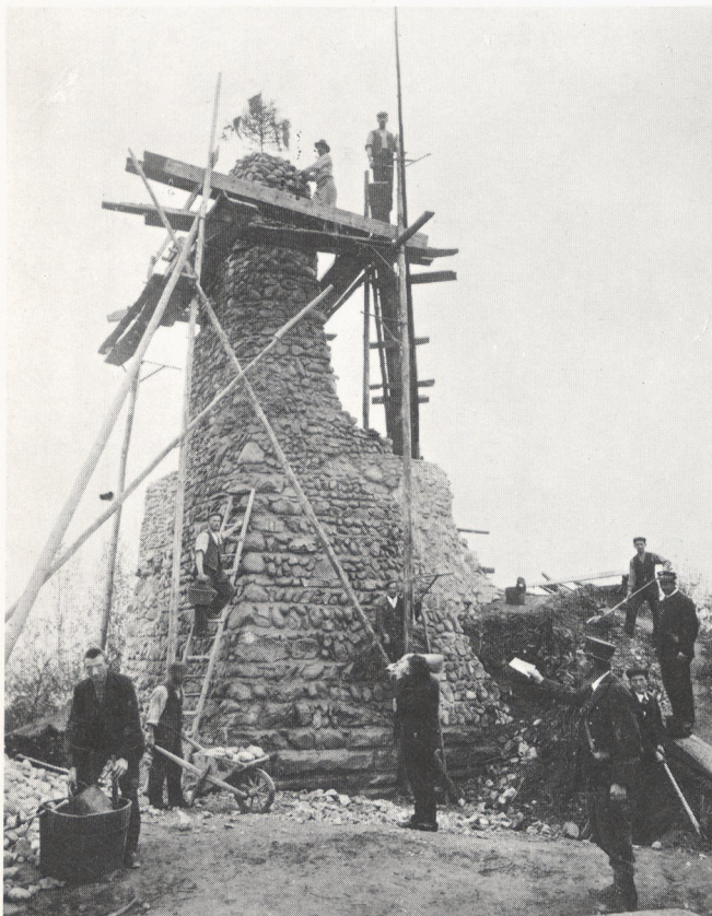
Abb. 75 Insassen der Strafanstalt Regensdorf konservieren 1909 den Turm
