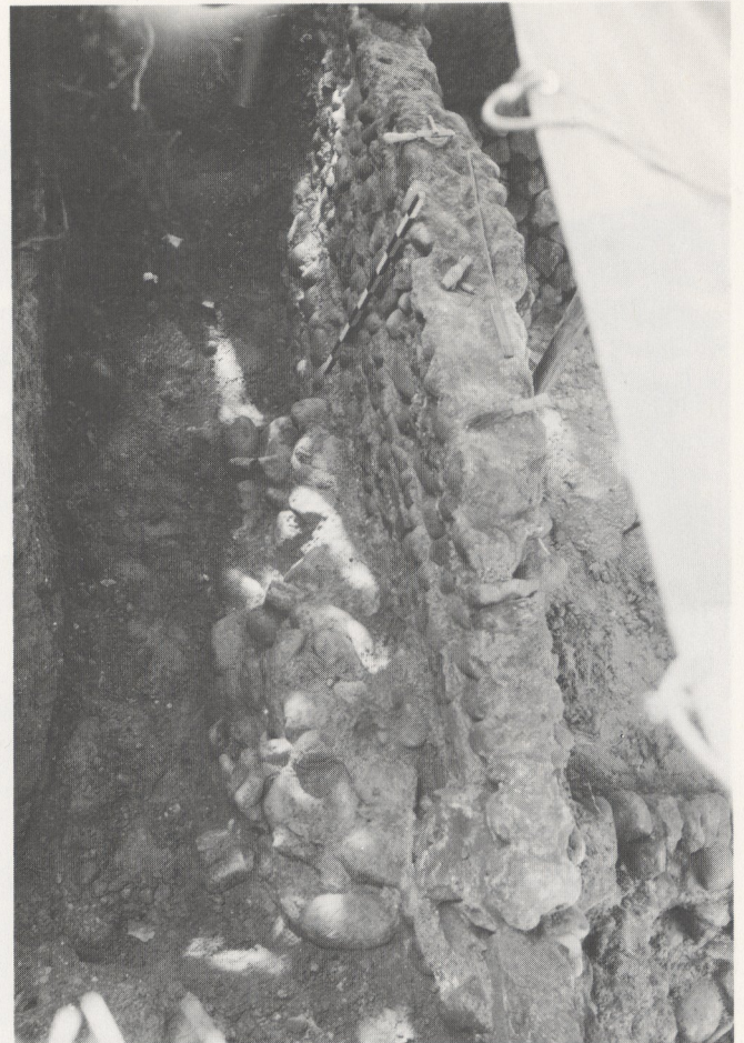
Abb. 52 Baufuge in der Nordwestecke der Ringmauer, wo sich der Eingang befand. Baufrage = linke Torwange (von aussen)
