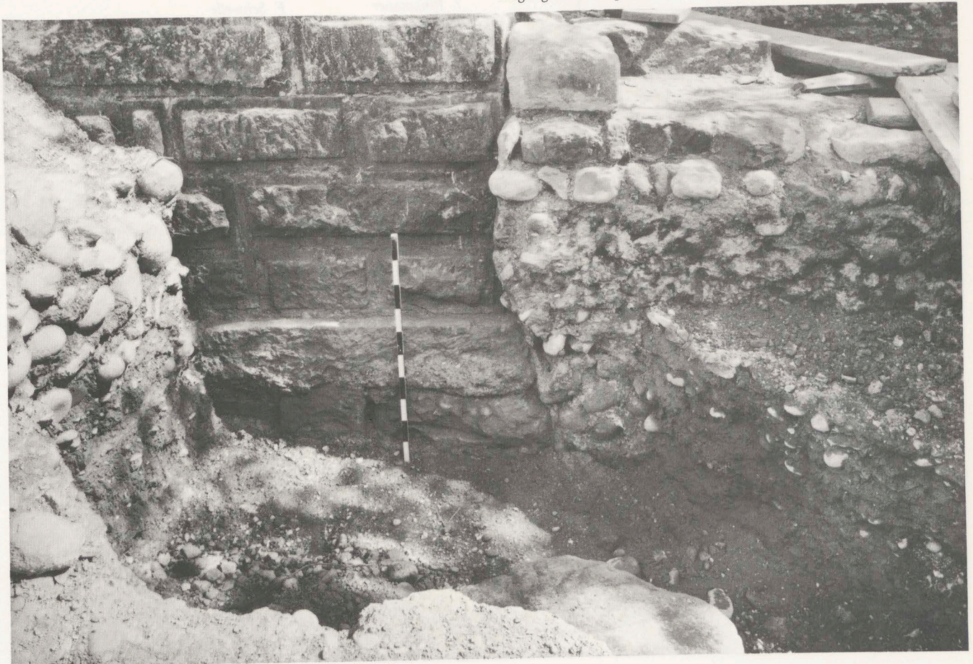
Abb. 58 An der Nordwestecke des Turmes angefügte Substruktion für Zugang der Wohnphase III ▼
