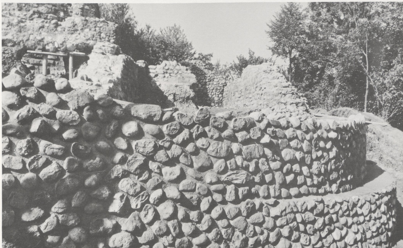
Abb. 61 Östliche Ringmauer. Äußerer Mantel rekonstruiert. Mit Verstärkung für Palasaufbau der Wohnphase III
