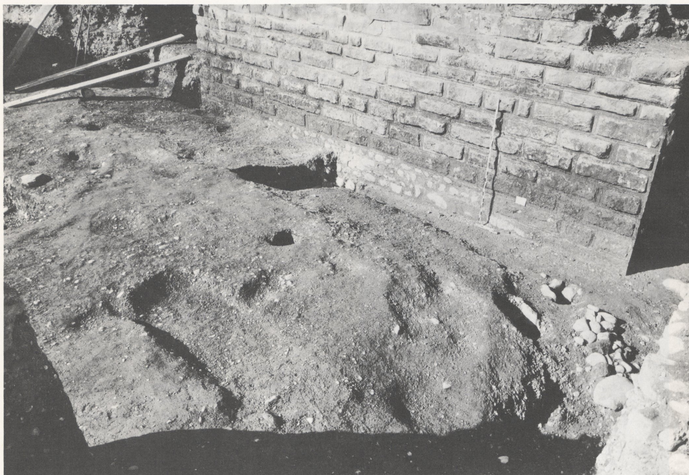
Abb. 44 Bergfried mit Buckelquadern mit Kantenschlag der Wohnphase II
