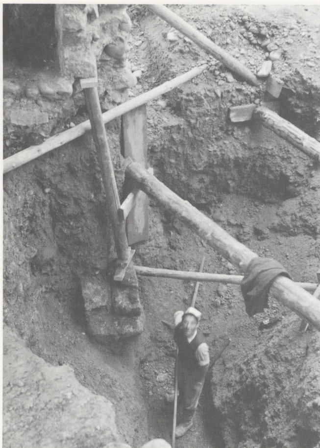
Abb. 54 Erste Zisterne, spätere Fallgrube mit hineingestelltem Fundament des Zwingers
