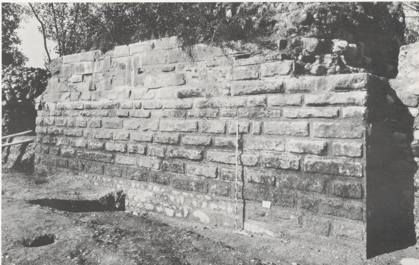
Abb. 35 Bergfriedsüdseite mit Mörtelverputz mit Fugenstrich der ersten Bauperiode. Vorne erster Wohnhorizont
