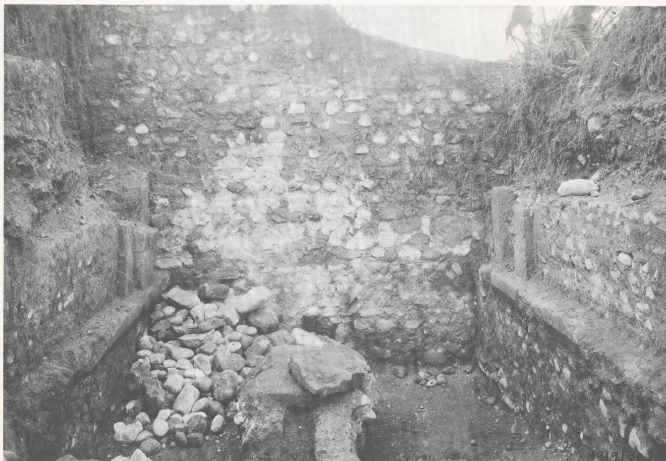
Abb. 68 Blick von Osten gegen die Ringmauer und in den Keller, den Mötteli tiefergraben ließ. Hinten links Bogenansatz auf Gesims. Seit 1918/19 Reservoir
