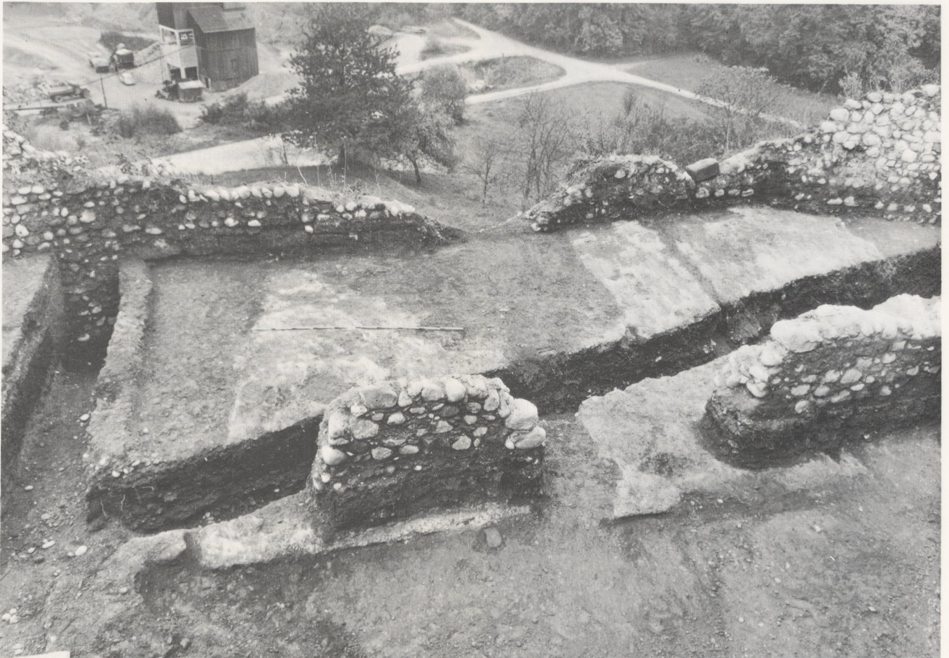
Abb. 49 Blick nach Süden mit Mörtelboden der Gesindehütten von Wohnphase II. Darüber auf Schutt die Grundmauern der Stallungen von Wohnphase III
