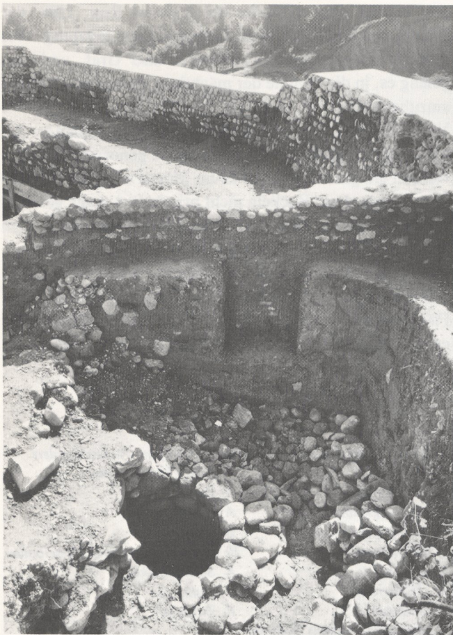
Abb. 46 Zisterne 2 mit Stützmauer, Lehmwandung, Kiesfüllung und ungemörteltem Steintubus
