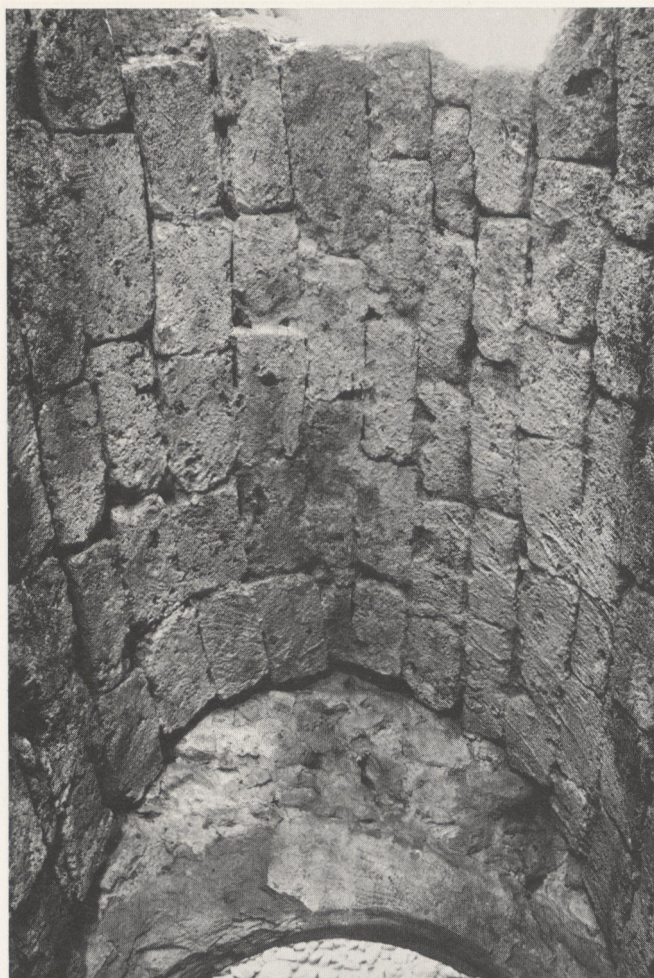
Abb. 13 Gewölbe aus Tuffstein des Kellerhalses.
