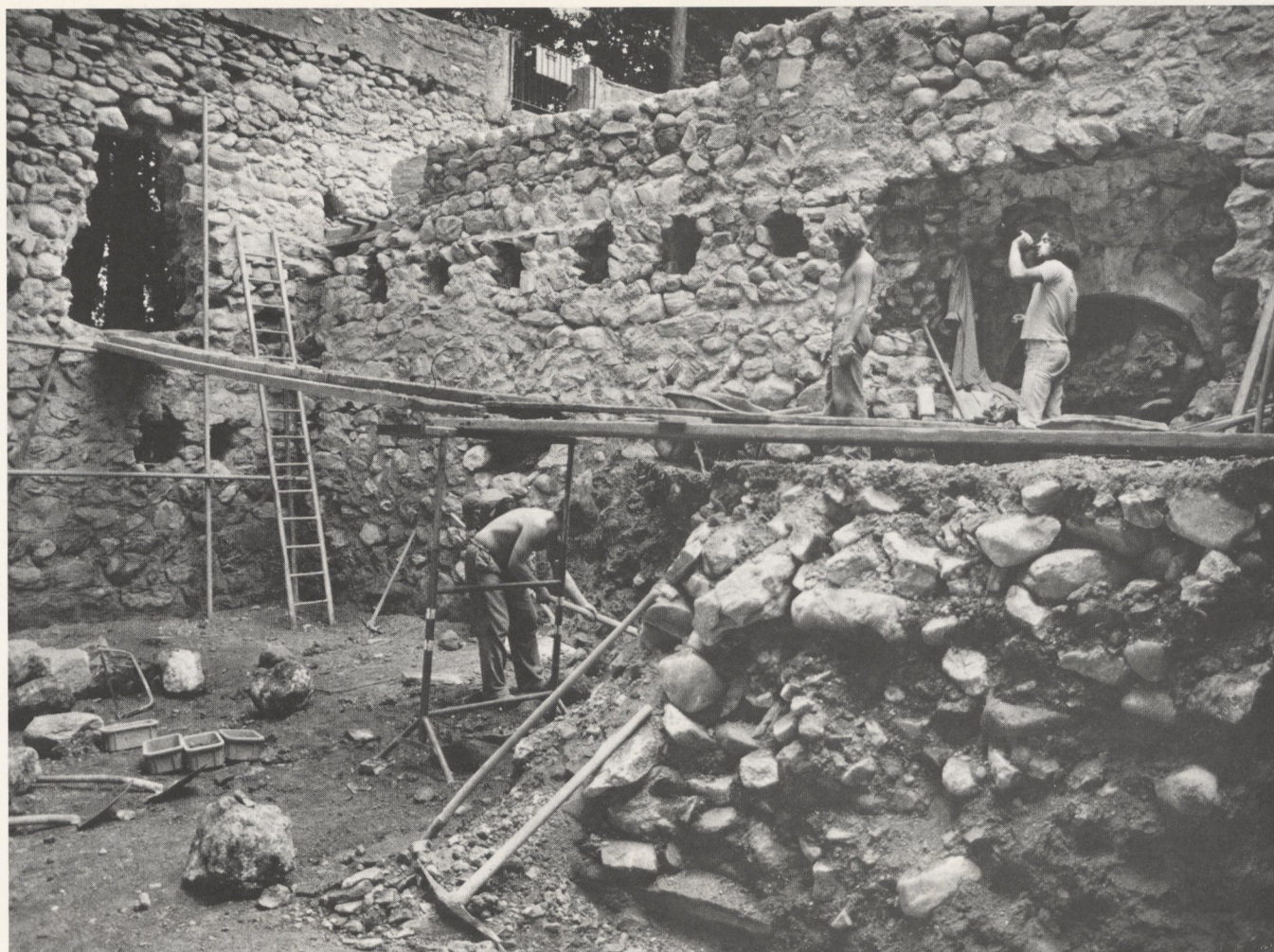
Abb. 2 Freilegungsarbeiten in F12/F13, Gebäude A. 1979
