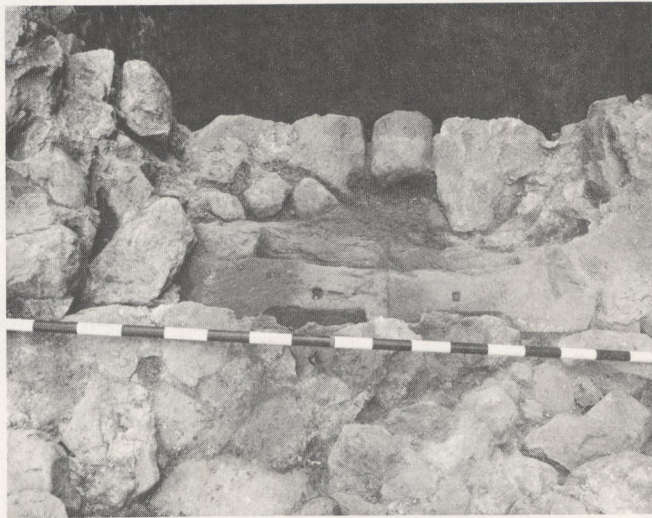
Abb. 6 Sandsteinerne Fensterbank in M9. Das Fenster hatte eine Mittelsäule und war vermutlich vergittert. Es wurde beim Bau des Kellerhalses zugemauert. ▼
