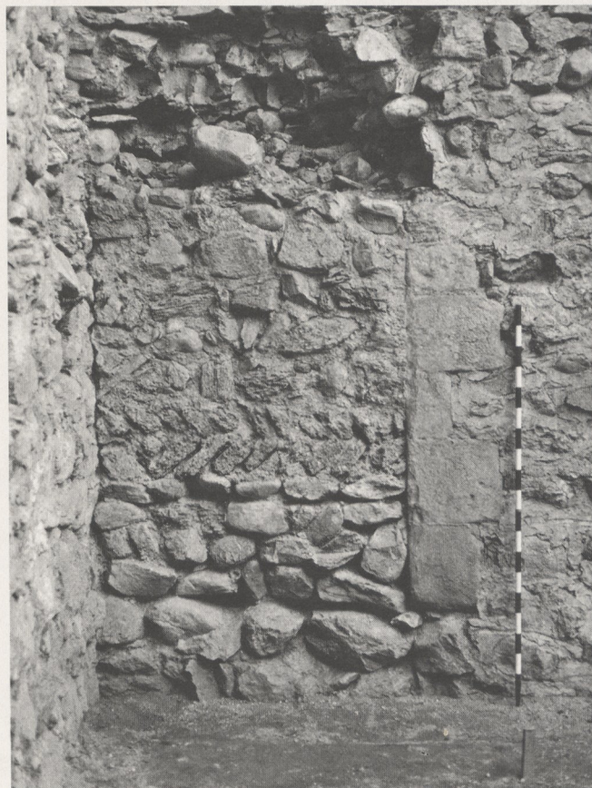
Abb. 3 Die in einer späteren Phase zugemauerte Türe in M1-Ostteil im Gebäude A. Man beachte den Ährenverband aus sauber geschnittenen Tuffsteinplatten.
