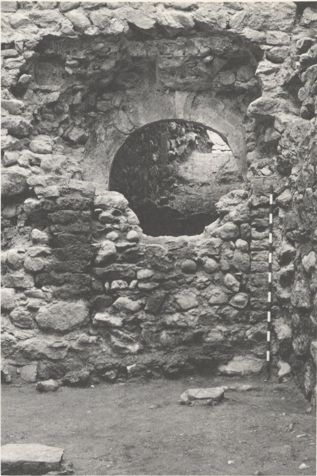
◀ Abb. 15 Zugemauerte und später wieder aufgebrochene untere Türe des Kellerhalses.
