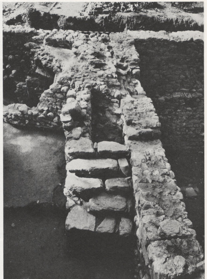
Abb. 17 Treppe in F14. Hinter der Treppe der Gewölbeüberbau.
