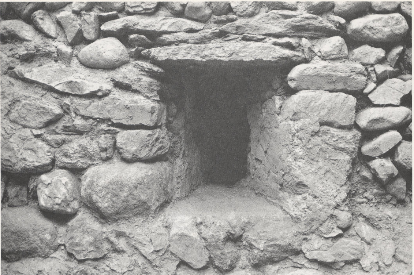
▲ Abb. 4 Fenster in M8, im Erdgeschoß des Gebäudes A, mit sauber verputzten Leibungen und Mörtelglattstrich auf der Bank.
