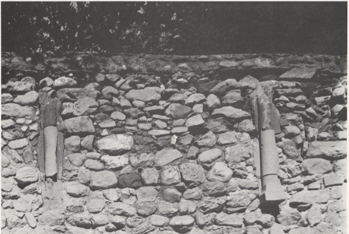
▲ Abb. 4 Fenster in M8, im Erdgeschoß des Gebäudes A, mit sauber verputzten Leibungen und Mörtelglattstrich auf der Bank.
