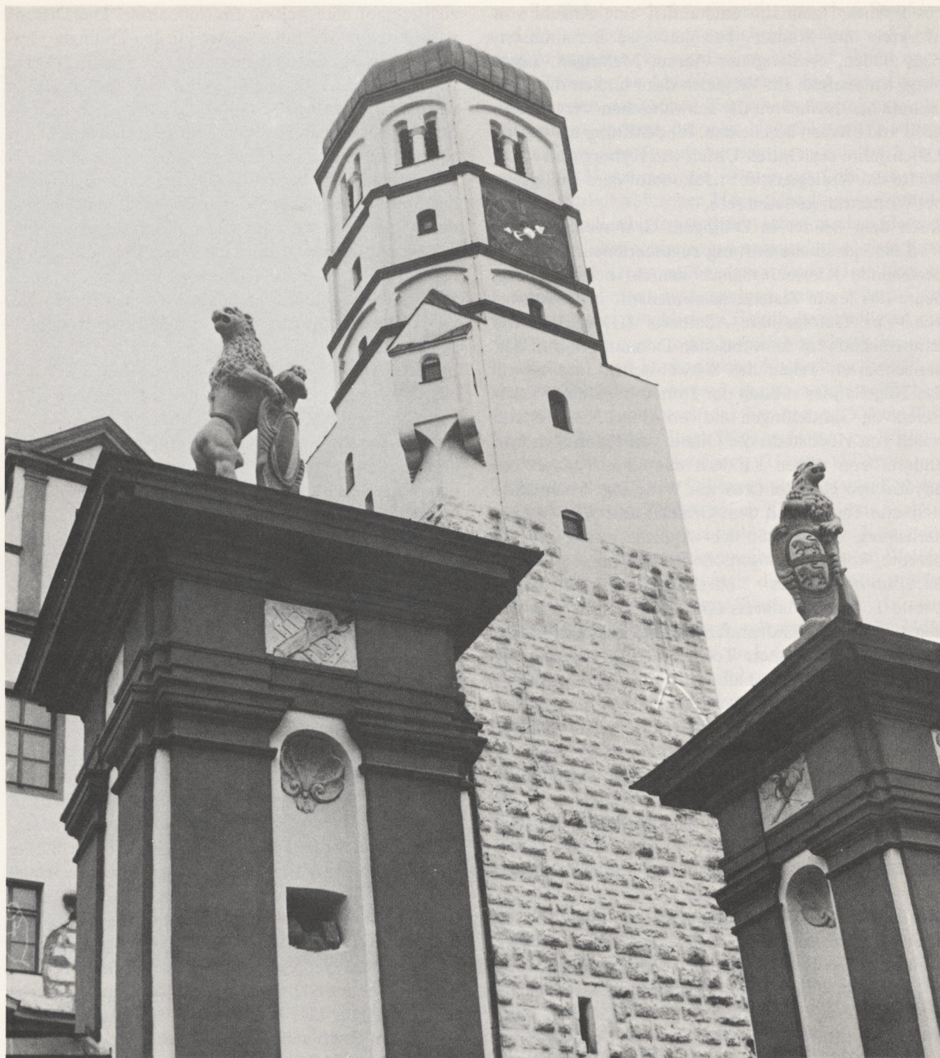
Abb. 3 Turm des Schlosses in Dillingen an der Donau, mit Buckelquadern des Bergfrieds der ehemaligen hochmittelalterlichen Burg Dillingen Foto: Reinhold Schönwetter, Dillingen
