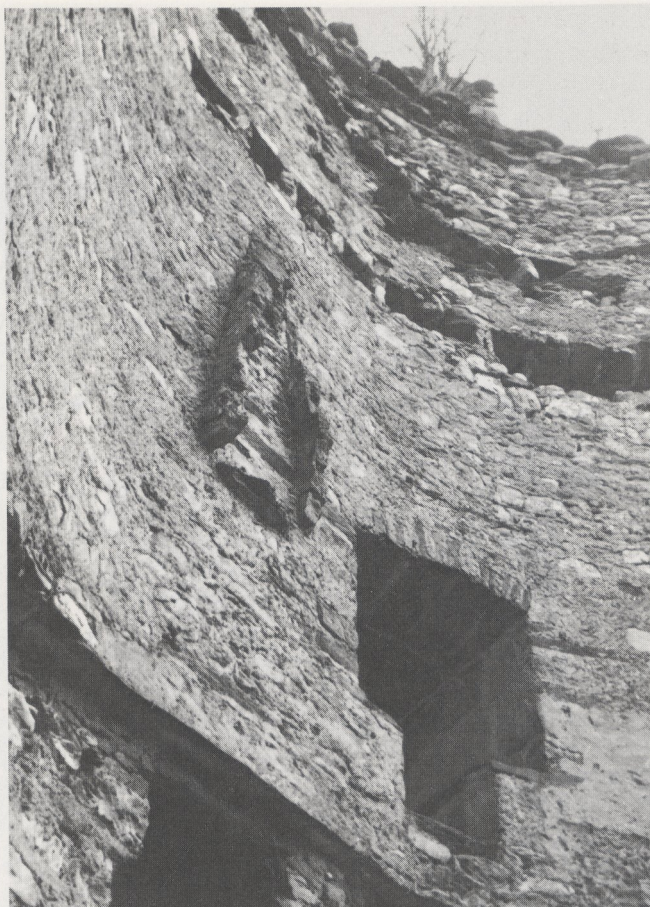
Abb. 249 Paspels/Canova, GR. Rauchabzug eines Ofens im vierten Geschoß. Foto Kantonale Denkmalpflege Graubünden.
