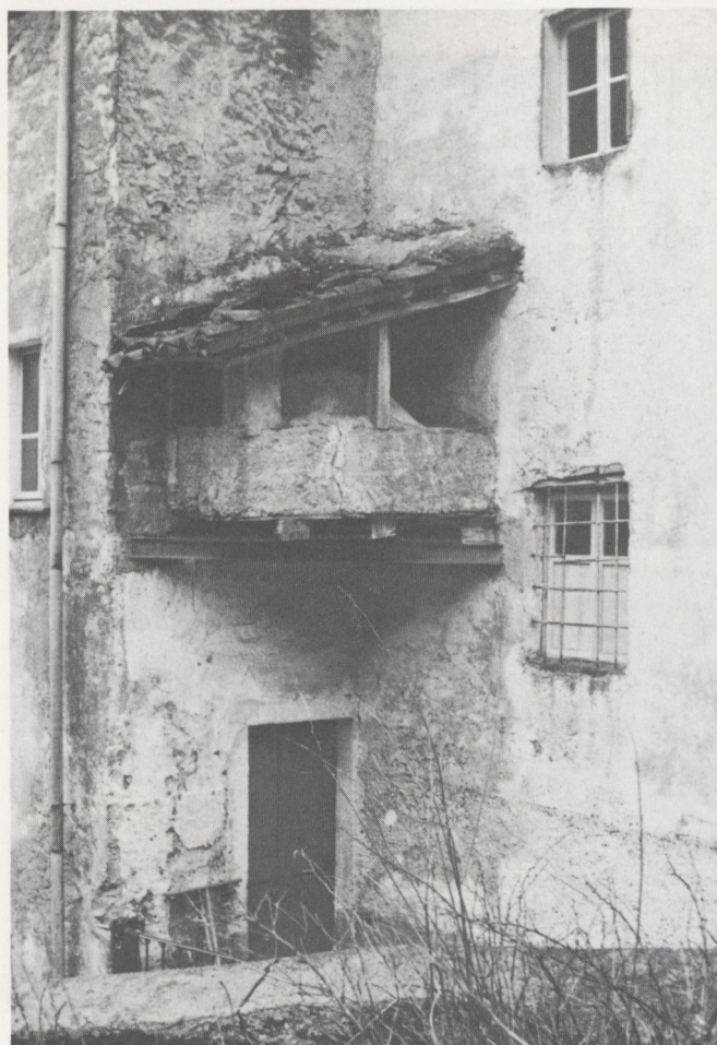
Abb. 265 Schuls, GR. Außenbackofen auf Konsolbalken. Foto Zentralarchiv Bauernhausforschung, Basel.
