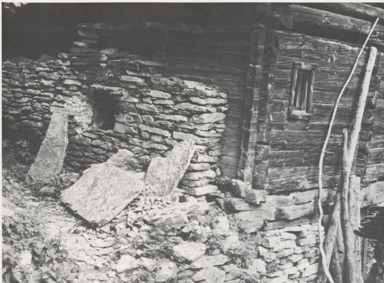
Abb. 272 Corzenasco, TI. Außen liegende Feueröffnung für einen Ofen. Ausgeprägte Feuermauer. Foto Zentralarchiv Bauernhausforschung, Basel.
