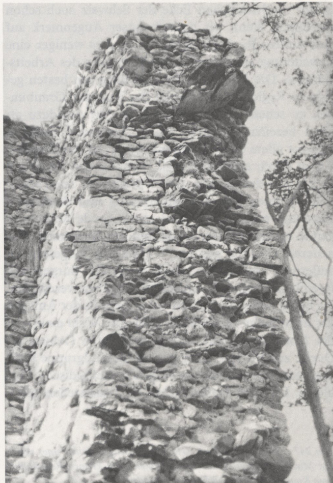
Abb. 248 Pratval/Hasensprung, GR. Querschnitt durch Kaminnische und schräg nach oben durch die Mauer führenden Rauchkanal. Foto Kantonale Denkmalpflege Graubünden.
