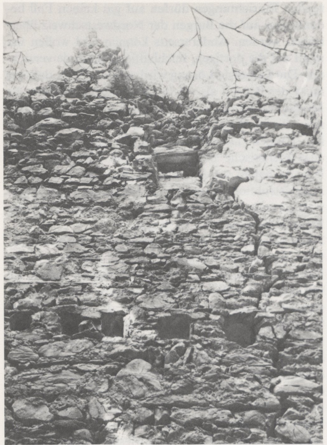
Abb. 246 Malans/Klingenhorn, GR. Rauchabzug in Form eines schrägen Mauerdurchbruchs. Foto Kantonale Denkmalpflege Graubünden.
