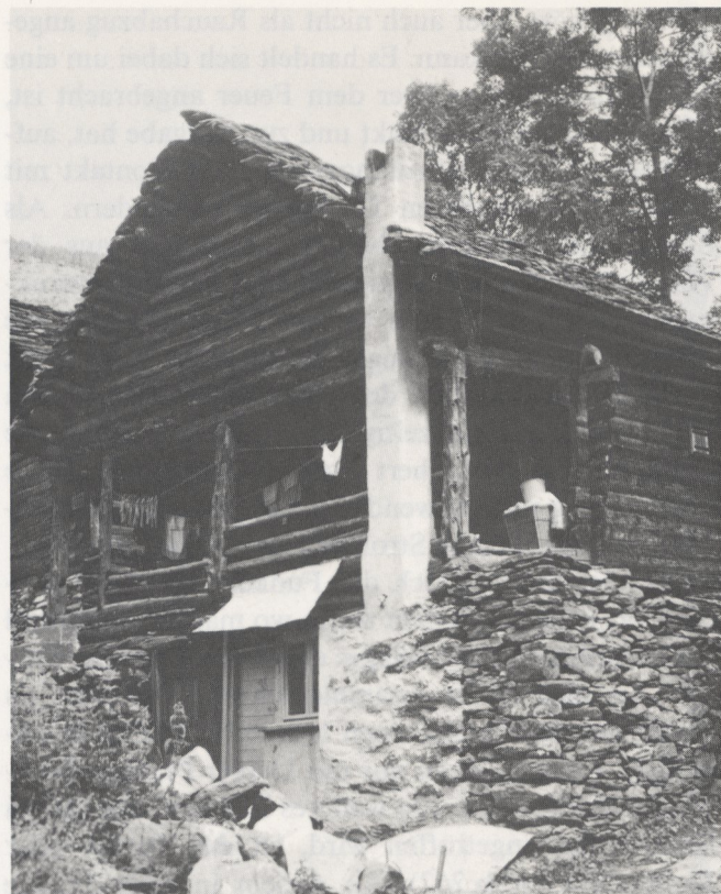
Abb. 278 Corzenasco, TI. Hoher Außenkamin. Foto Zentralarchiv Bauernhausforschung, Basel.
