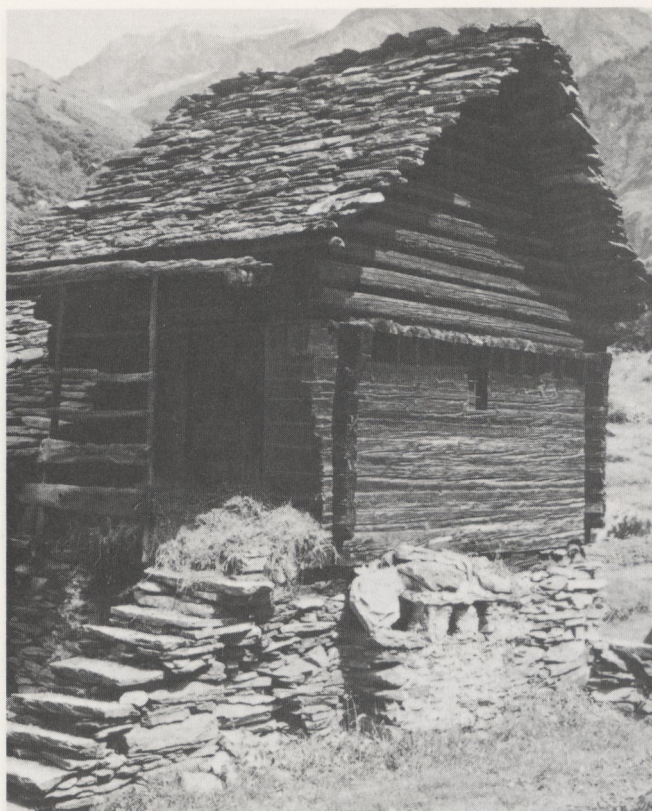
Abb. 276 Malvaglia, TI. Stummelkamin über einer teilweise in den Hang eingegrabenen Herdnische. Foto Zentralarchiv Bauernhausforschung, Basel.
