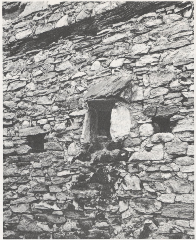
Abb. 274 Calonico, TI. Mittels Steinplatten geschützter Rauchaustritt. Foto Zentralarchiv Bauernhausforschung, Basel.
