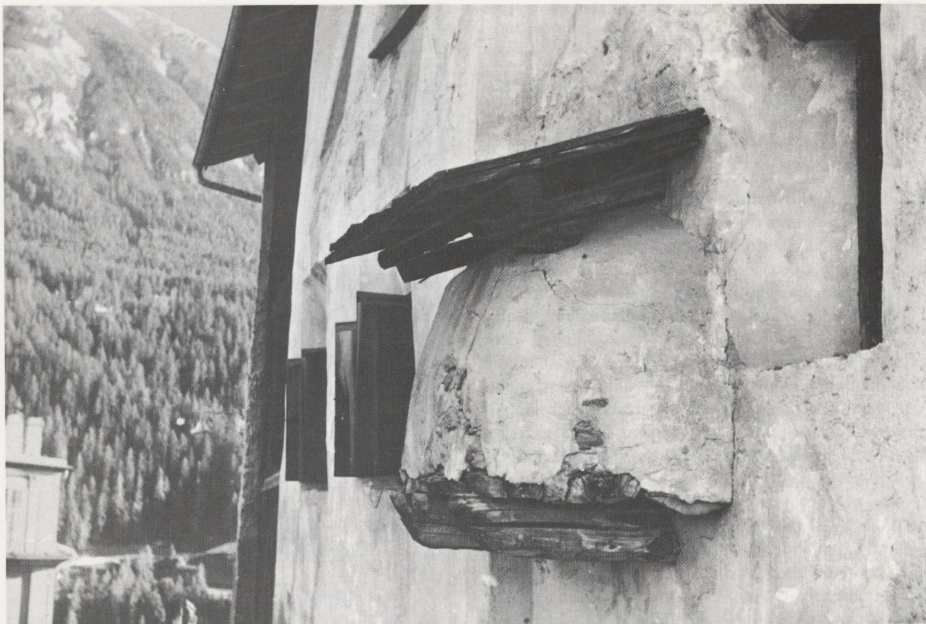
Abb. 265 Schuls, GR. Außenbackofen auf Konsolbalken. Foto Zentralarchiv Bauernhausforschung, Basel.
