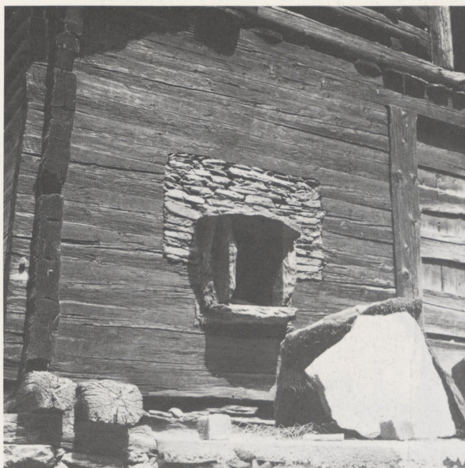
Abb. 271 Malvaglia, TI. Außen liegende Feueröffnung für einen Ofen. Ansätze einer Feuermauer. Foto Zentralarchiv Bauernhausforschung, Basel.
