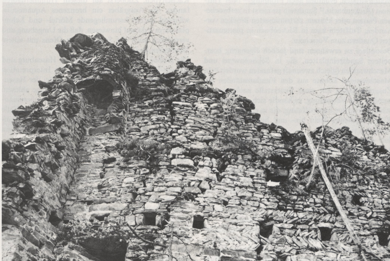
Abb. 254 Thusis/Obertagstein, GR. In einer Ecke gelegene Kaminanlage mit gemauertem Schlot. Foto Kantonale Denkmalpflege Graubünden.
