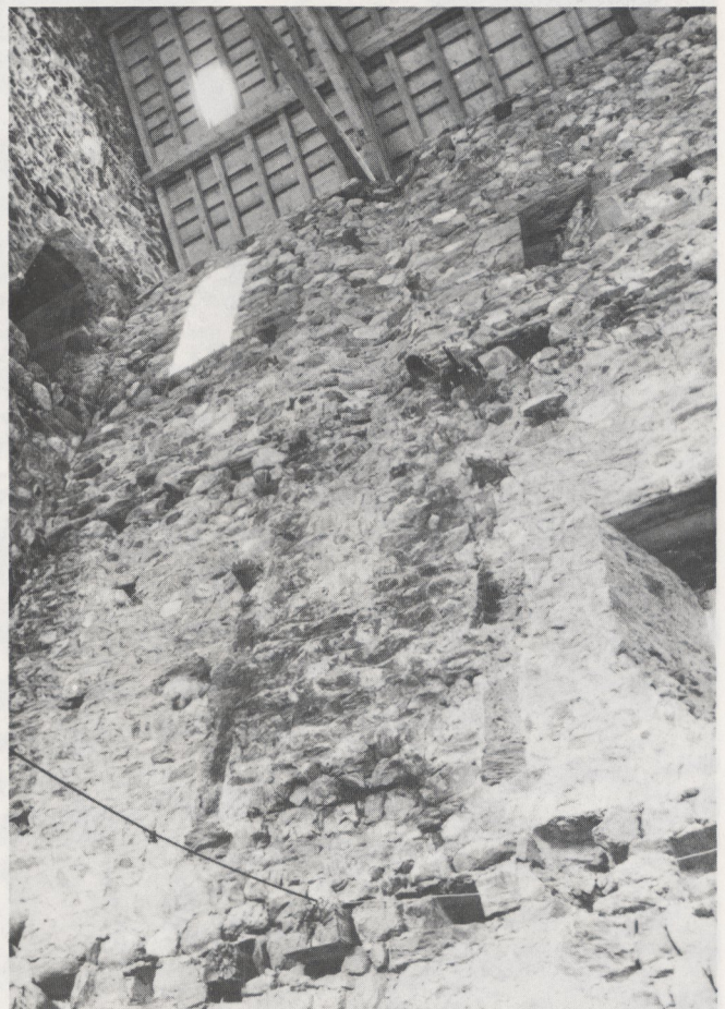
Abb. 252 Riom, GR. Reste einer Kaminanlage mit leicht in die Mauer eingelassenem Rauchabzug. Foto Kantonale Denkmalpflege Graubünden.
