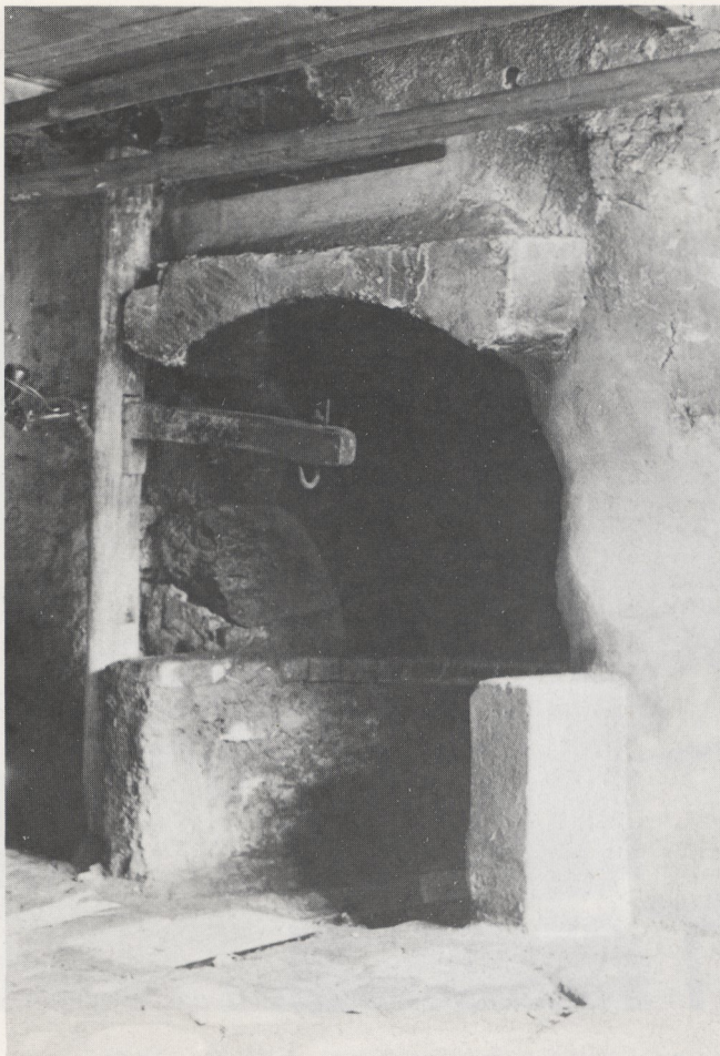
Abb. 262 Schwyz-Ried, SZ. Hinten ummauerte, bodenebene Feuerstelle mit Turner, vorn halbhohe Herdbank mit nachträglich aufgemauertem Sparherd. Foto Zentralarchiv Bauernhausforschung, Basel.
