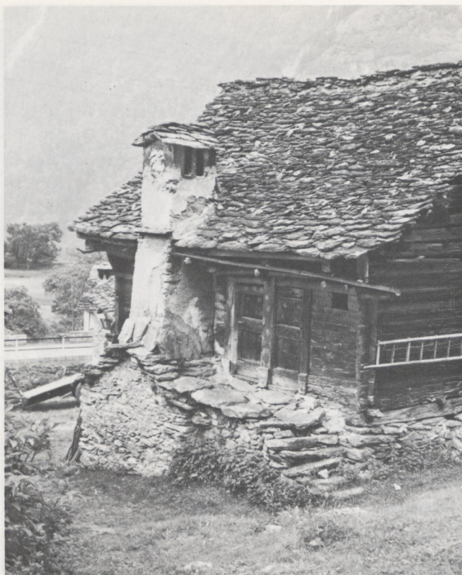
Abb. 277 Malvaglia, TI. Kurzer Außenkamin. Foto Zentralarchiv Bauernhausforschung, Basel.
