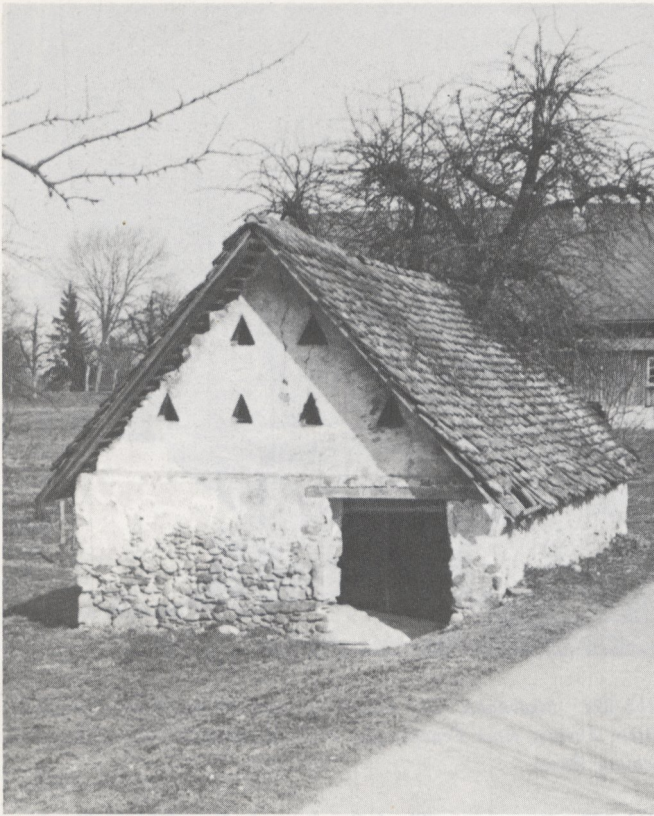
Abb. 273 Jaberg, BE. Dreieckige Rauchlöcher im Giebel eines Ofenhauses. Foto Zentralarchiv Bauernhausforschung, Basel.
