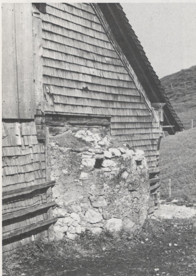
Abb. 264 Giswil/Jänzimatt, OW. Aus der Wand apsidenartig vorstehende Herdnische mit Rauchlöchern. Foto Zentralarchiv Bauernhausforschung, Basel.
