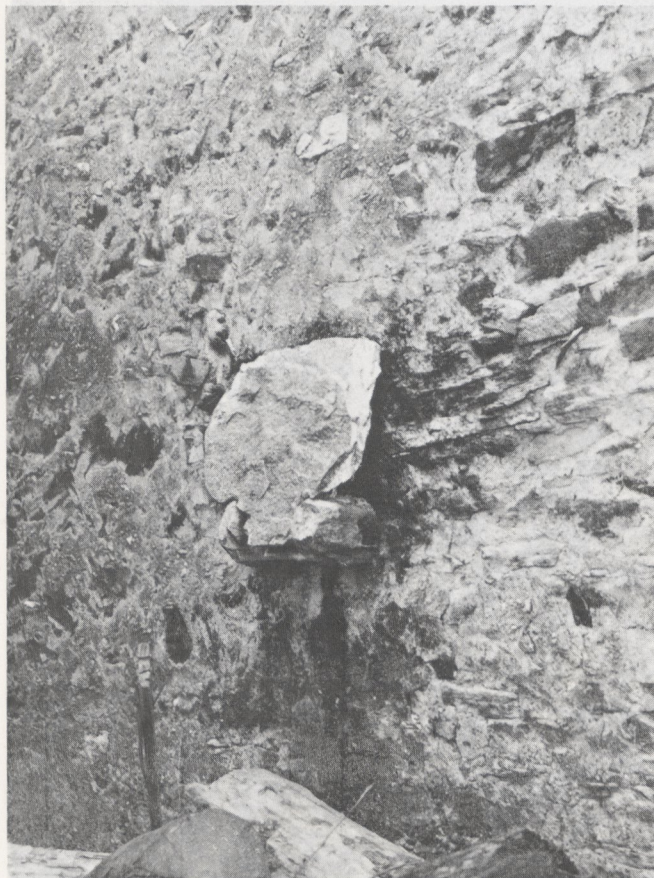
Abb. 275 Malvaglia, TI. Mit Steinplatte abgedeckter Rauchaustritt. Foto Zentralarchiv Bauernhausforschung, Basel.
