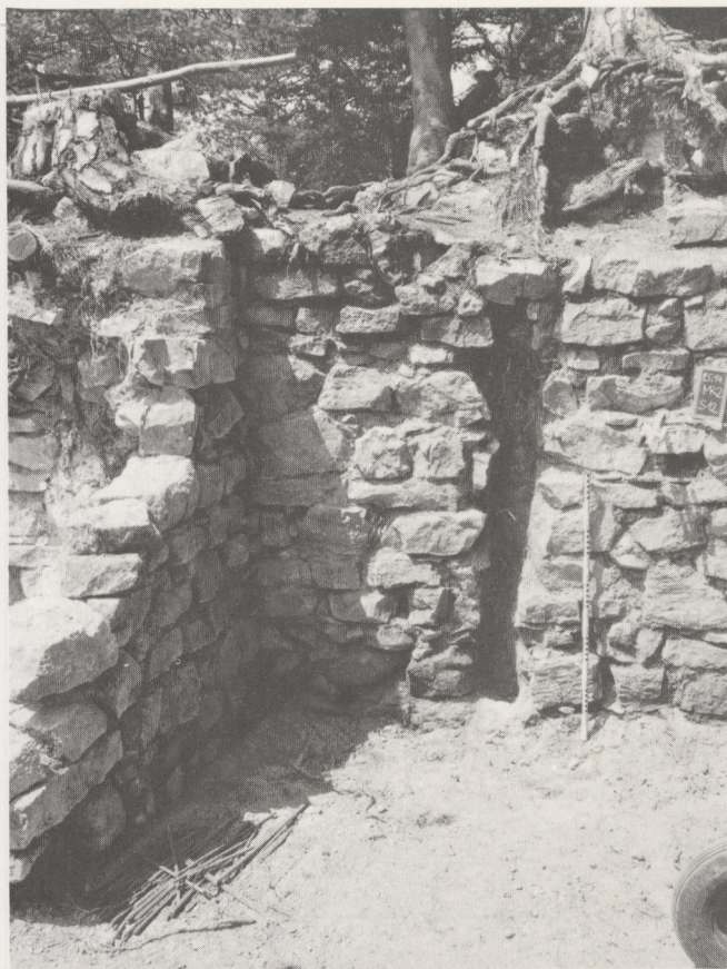
Abb. 54 Gelterkinden/Scheidegg, BL. Befund d, Reste einer Kaminanlage (?), Ansicht von Südosten. Foto KMBL.
