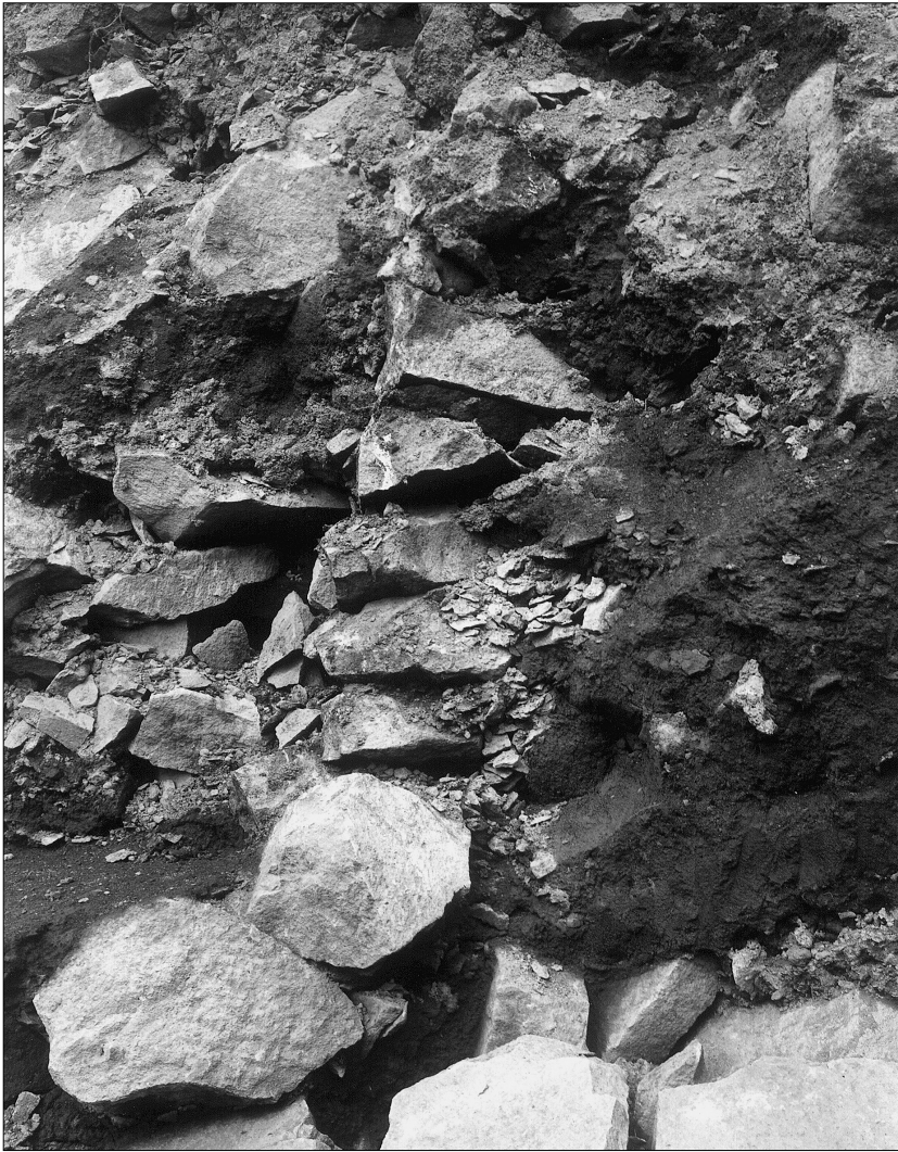
Abb. 105 Kottenheim, Grube Halbfeld. Stützmauer des Arbeitsplatzes 1 (Nachlaß J. Röder, Mus MY).
