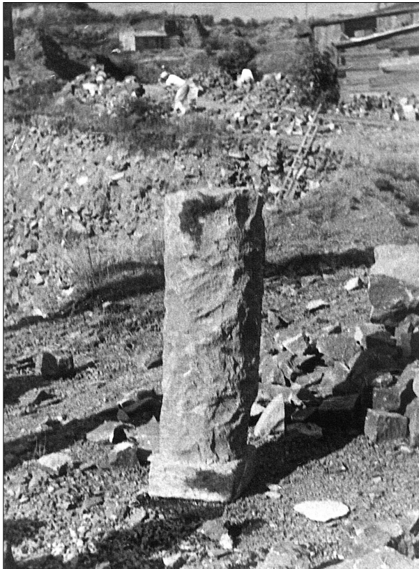
Abb. 155 Mayen. Rohling eines Säulenstumpfs aus der Grube TUBAG (Nachlaß J. Röder, Mus MY).
