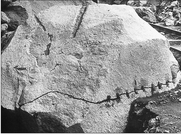
Abb. 106 Kottenheim, Grube Halbfeld. Oben: Mit dem Steinhammer geschlagene Spaltrille. Unten rechts: Moderne Spaltung (v. Berg / Wegner 1995, Abb. 8).
