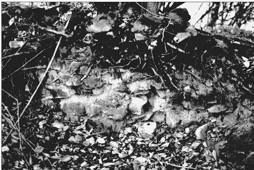
Abb. 85 Mendig-Obermendig, »Im Winkel«. Sichtbare Mauerreste des burgus . Sichtseite des Mauerwerks: Kleine Handquader aus Basaltlava. Bildbreite ca. 1,5 m.
