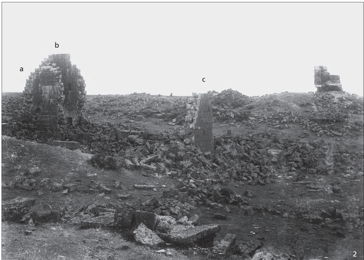
Kirche im Kastrohof: 1 Ansichten von Nordwesten im Jahr 1979. – 2 Ansicht von Nordwesten im Jahr 1898. – a Ziegel der Apsiskalotte; b Obergeschoss des südlichen Apsisnebenraums; c Westfassade (Foto von Oppenheim).
