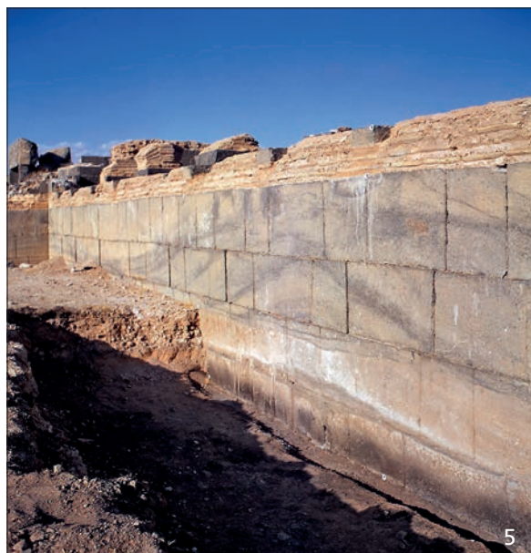
1-4 Kastron, Steingarten der Westseite: 1-2 Latrinensteine; 3-4 tragende Konsolen. – 5 Außenwand des Südwesttraktes mit Brandspur.
