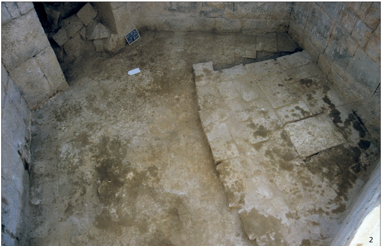
Kastron, Südwestturm: 1 Eingangstür und Erdgeschossraum nach Norden. – 2 Bodenniveau, sekundäre Steinsetzung mit zentraler Kalksteinplatte.
