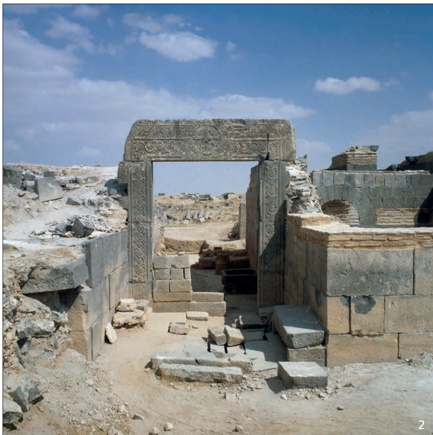
Kastron. Westtoranlage: 1 Vor der Restaurierung. – 2 Nach der Restaurierung.
