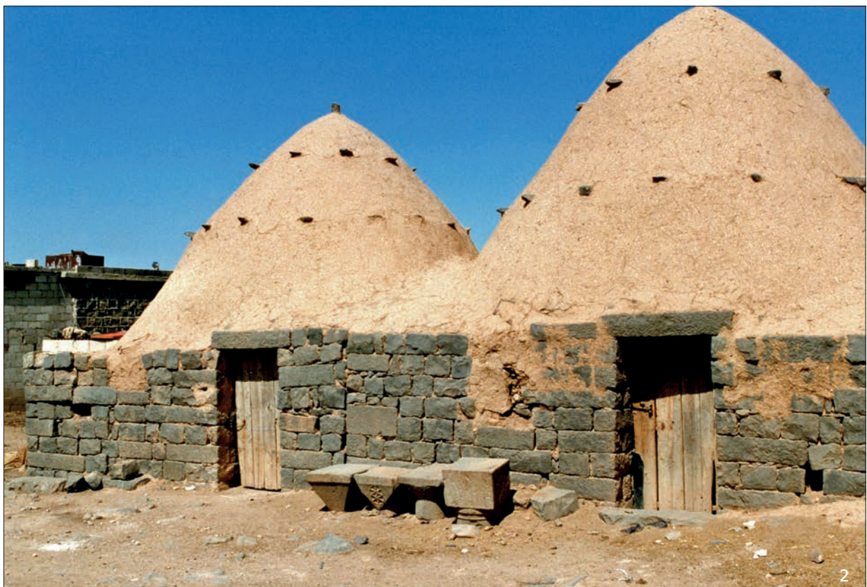
Lehmziegelbauten ( qubben ) mit zahlreichen Basaltspolien in Umm Mzameq (1) und Qasr el Mharram (2).
