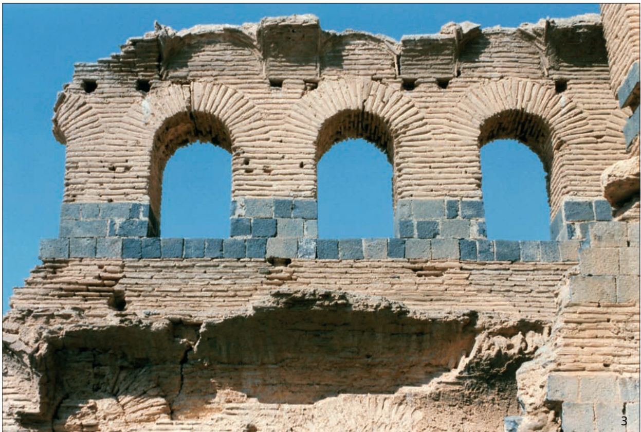
Qasr ibn Wardan, Kirche: Apsisfenster von innen (1) und von außen (2), vor der Restaurierung. – 3 Empore. Rundbogenfenster der Nordfassade.
