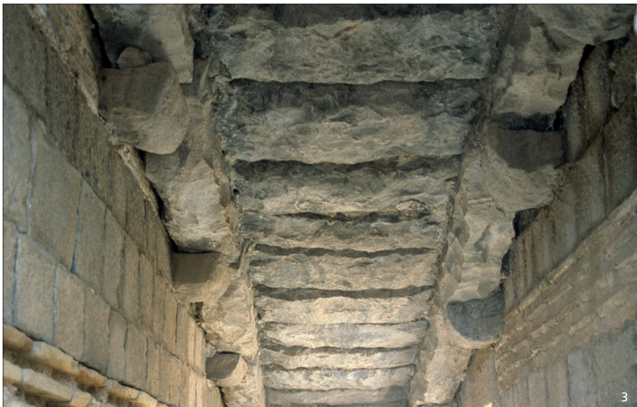
Kastron, westliches Rampenhaus: 1. 3 Blick in den Raum unter der Rampe ( 1 ) mit den dortigen Streichbalken ( 3 ). – 2 Streichbalken des dritten Rampenlaufs.
