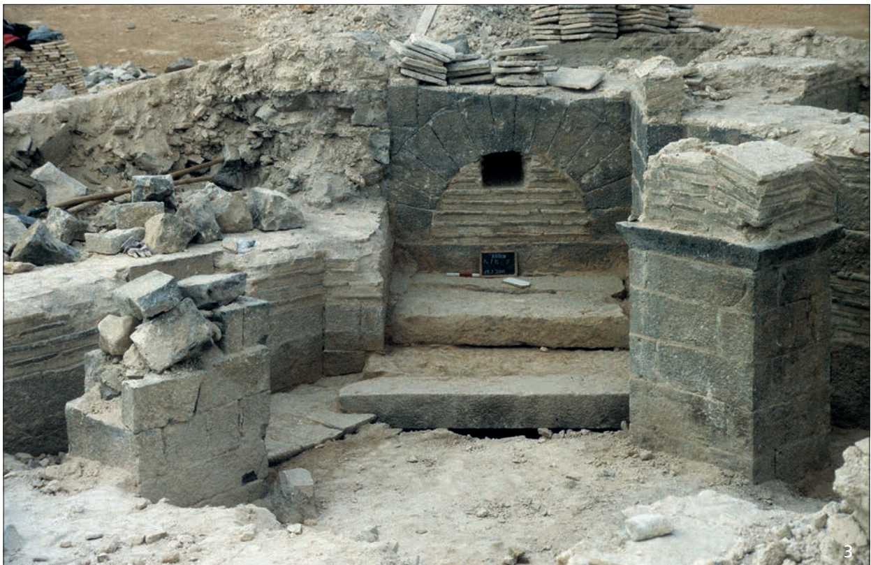
Kastron, Südhalle: 1 Detailansicht des Gewölbeversturzes und der Sekundärmauer. – 2 Wehgang mit Sekundärmauer und Vorraum des Südwestturmes nach Süden. – 3 Vorraum des Südwestturmes, Dach des Vorraumes und Entlastungsbogen der Eingangstür.
