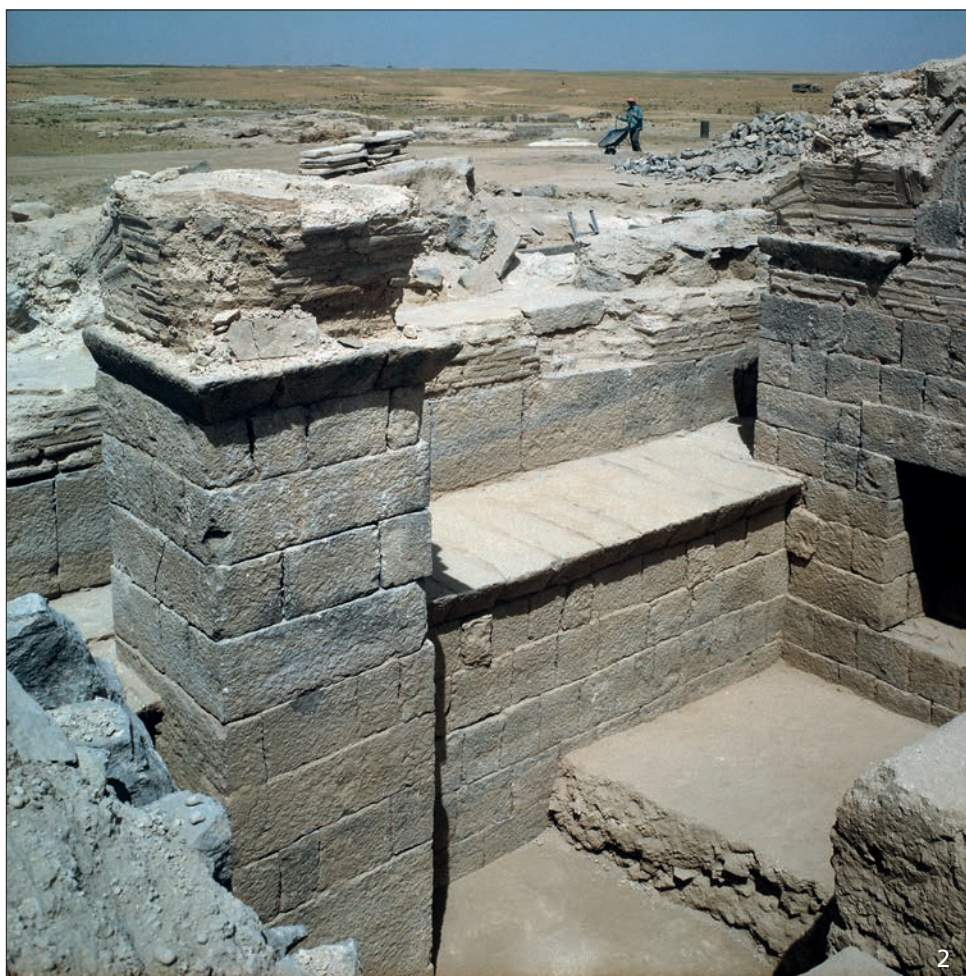
Kastron, Westhalle: 1 Versturz der Südwand des Rampenhauses in den Nordteil der Westhalle. – 2 Brunnenraum. Nordwestteil des Brunnenraums mit erstem Estrich der Nachnutzung.
