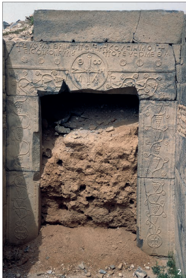
Kastron, Südtrakt: 1 Südtor und westlicher Wehrturm. – 2 Ansicht des Südtores.
