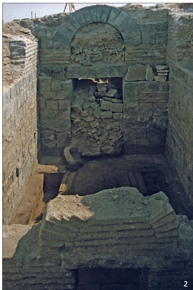
Kastron, Latrine: 1 Sickergrube nach Südwesten. – 2 Hauptraum und Sickergrube nach Osten.
