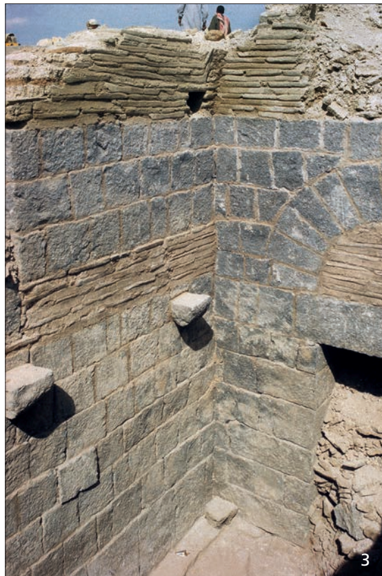
Kastron, Südtrakt: 1 Sekundäre Einbauten in dem Raum westlich des Rampenhauses. – 2 Innenansicht der Tür in den Südraum mit sekundären Einbauten. – 3 Innenansicht des östlichen Wehrturmes mit Gewölbeansatz des ersten Obergeschosses.
