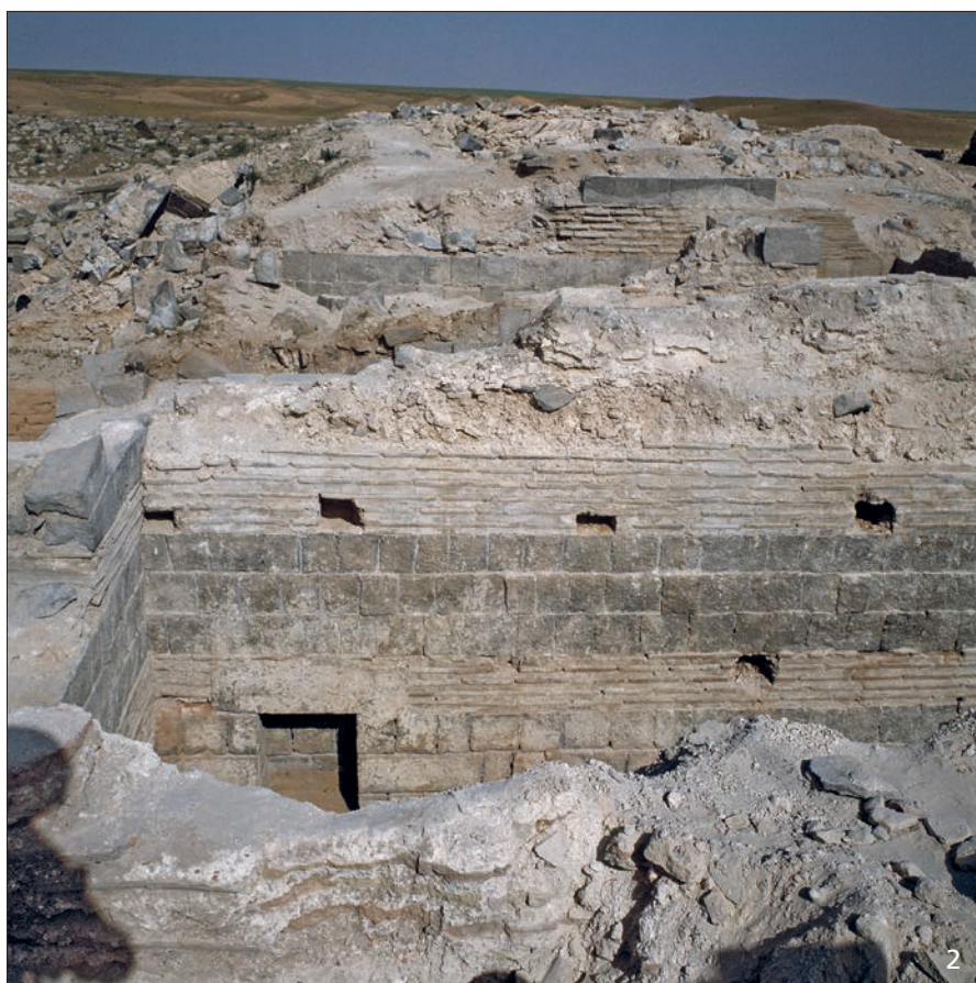
Kastron: 1 Südtrakt. Pfeiler der Südportikus und Südraum nach Osten. – 2 Rampenhaus und Südraum nach Osten.
