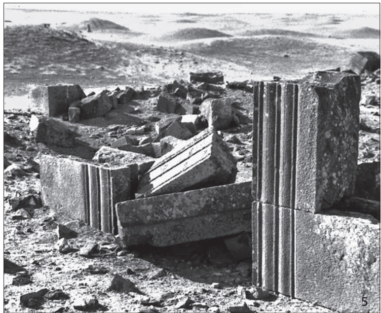
1-2 Androna, Kastron: Rechteckfenster der Westfassade, Seitengewände (2) und Stürze (1). – 3 Androna: Fenstertransenne aus Basalt im Oberflächenbefund. – 4-5 Androna, Weitarkadenbasilika: Türen der Südfassade.
