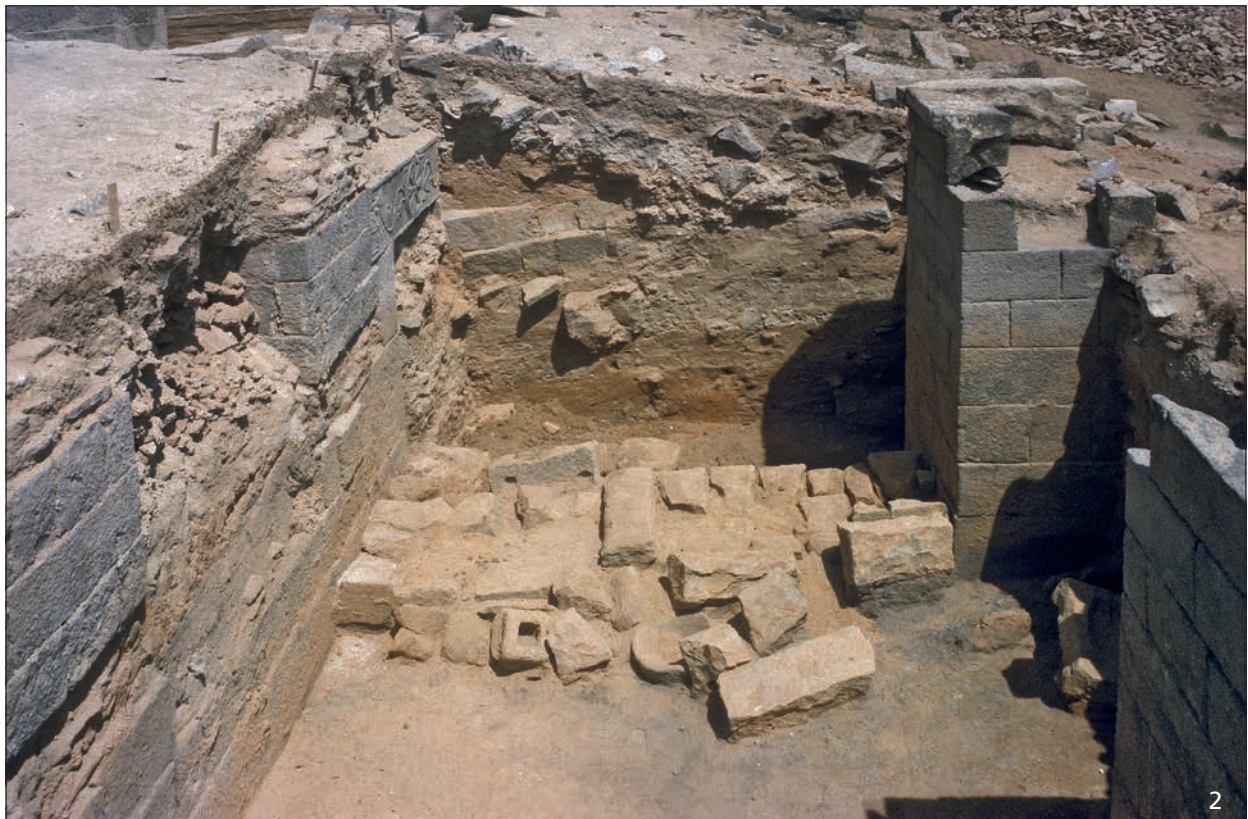
Kastron, Westportikus: 1 Nordostbereich mit Pfeilerarkaden und drei sekundären Öfen. – 2 Blick nach Norden auf Profilschnitt (Abb. 64) und eingestürzte Sekundärmauer.
