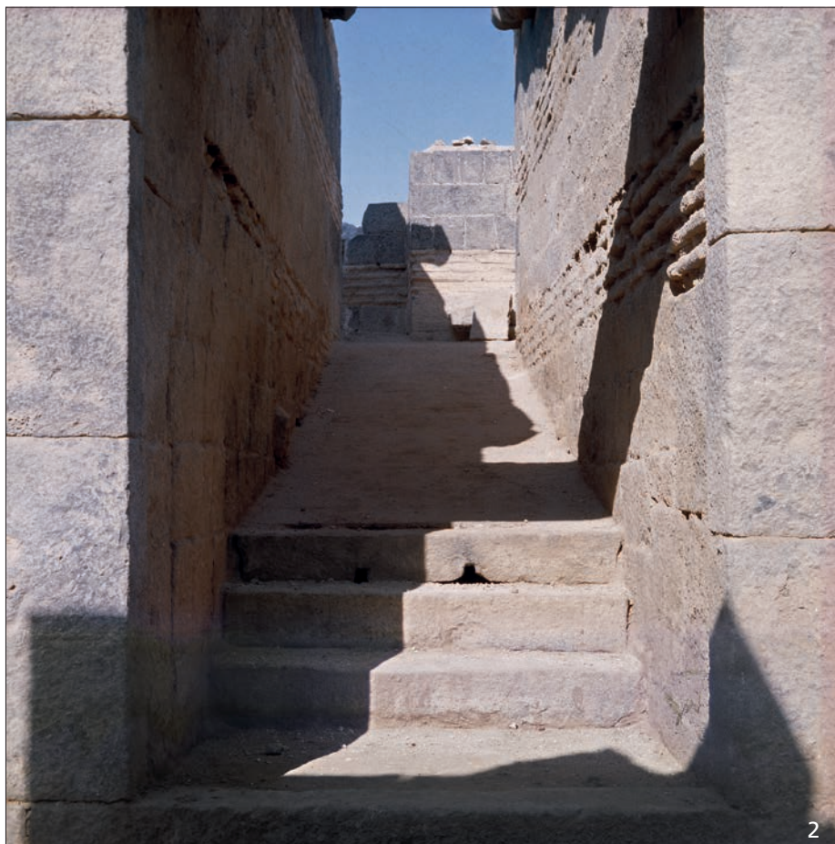
Kastron: 1 Ansicht des zweiten Rampenlaufs. – 2 Erster Rampenlauf des westlichen Rampenhauses.
