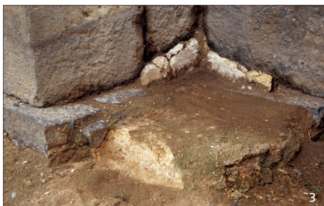
1-2 Qasr ibn Wardan, Kirche: 1 Montage von Inkrustationsplatten, Rest von Marmorplatte und Mörtelschicht; 2 Reste von Mörtel aus der Montage von Wandplatten. – 3 Androna, Kastronkirche: Montage von Inkrustationsplatten, Rest von Kalksteinplatte und Mörtelschicht.
