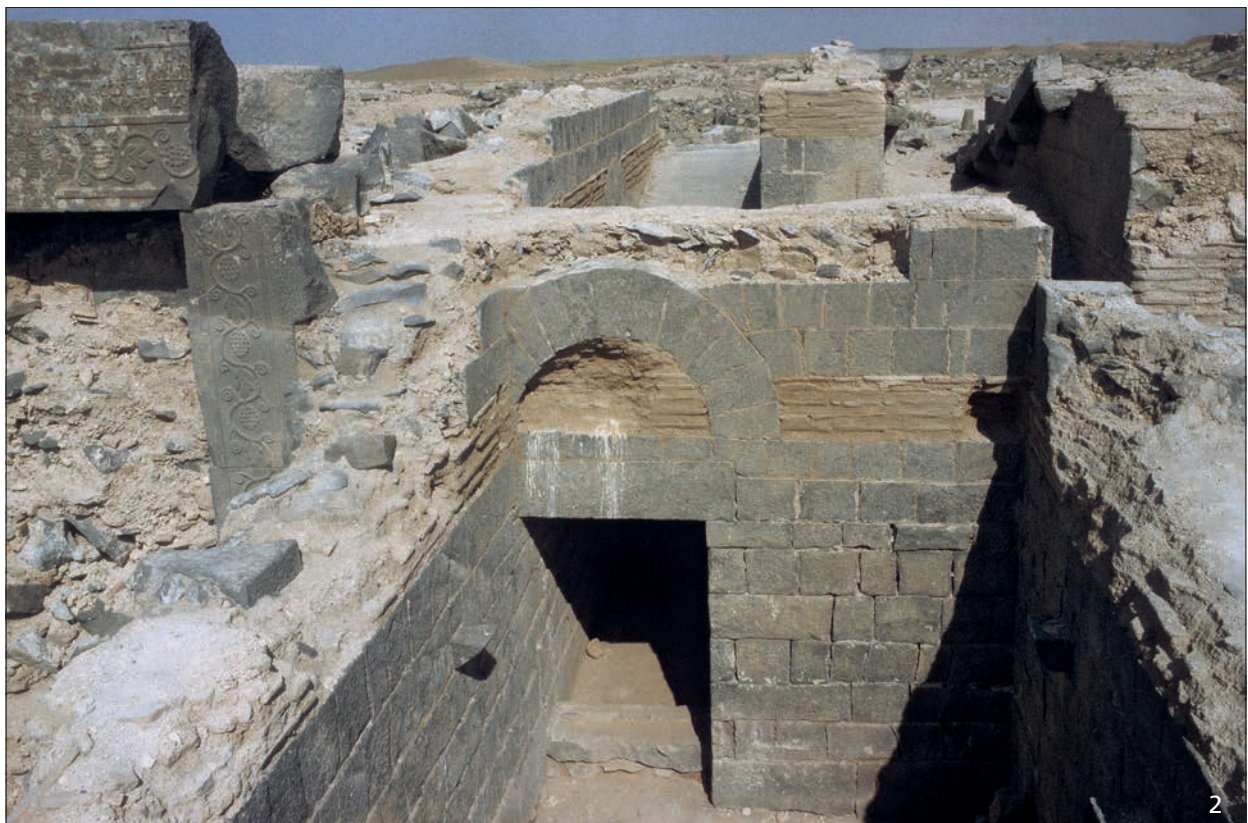
Kastron: 1 Vorraum des Westtores mit sekundärer Sitzbank in Basalt. – 2 Südturm des Westtores, Ostseite mit Blick auf die Rampe.
