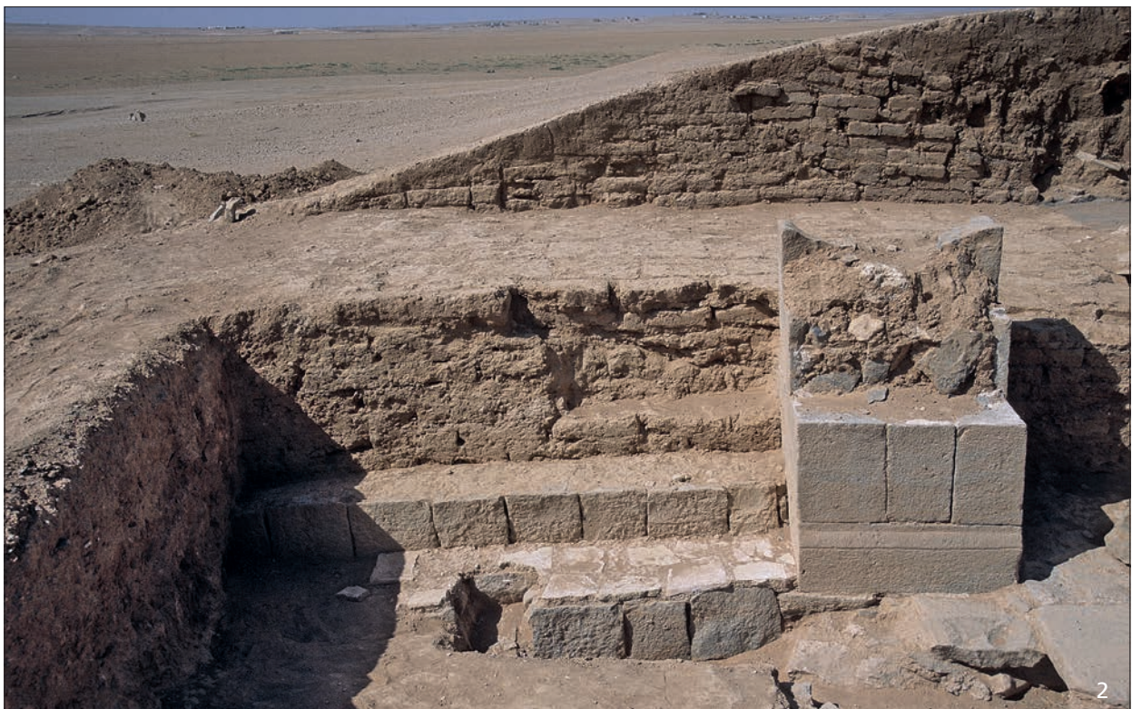
Lehmziegelmauer, Südtor: 1 Südlicher Vorraum Richtung Ortszentrum. – 2 Westteil des südlichen Vorraums.
