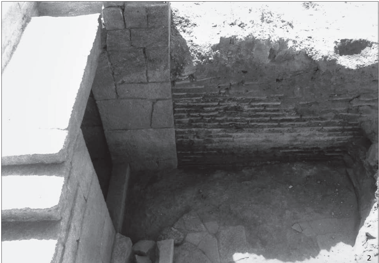
Kastron, Osttrakt: 1 Treppenturm, Westtür mit Treppenlauf vom Wehgang aus. – 2 Raum vor der Tür des Treppenturmes; Sekundär- mauer und Ziegelmauer zwischen Innen- und Außenpfeiler.
