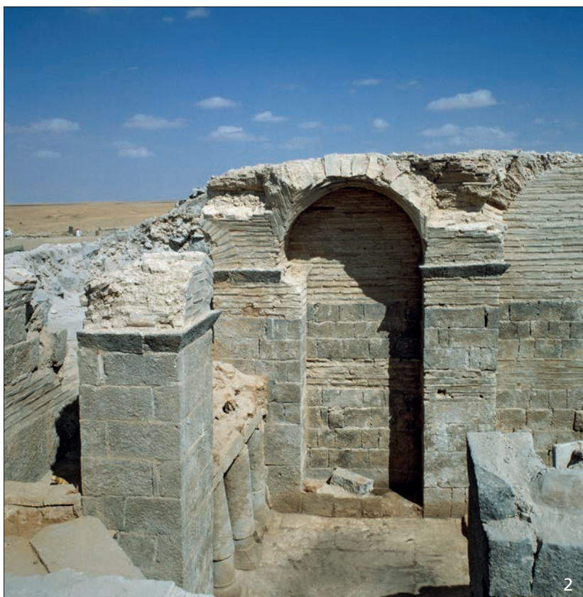
Kastron, Südhalle: 1 Südwestteil mit Blick in den Südwestturm. – 2 Nordseite. Pfeiler mit Gewölbeansätzen und Sekundärmauer auf dem Wehgang.
