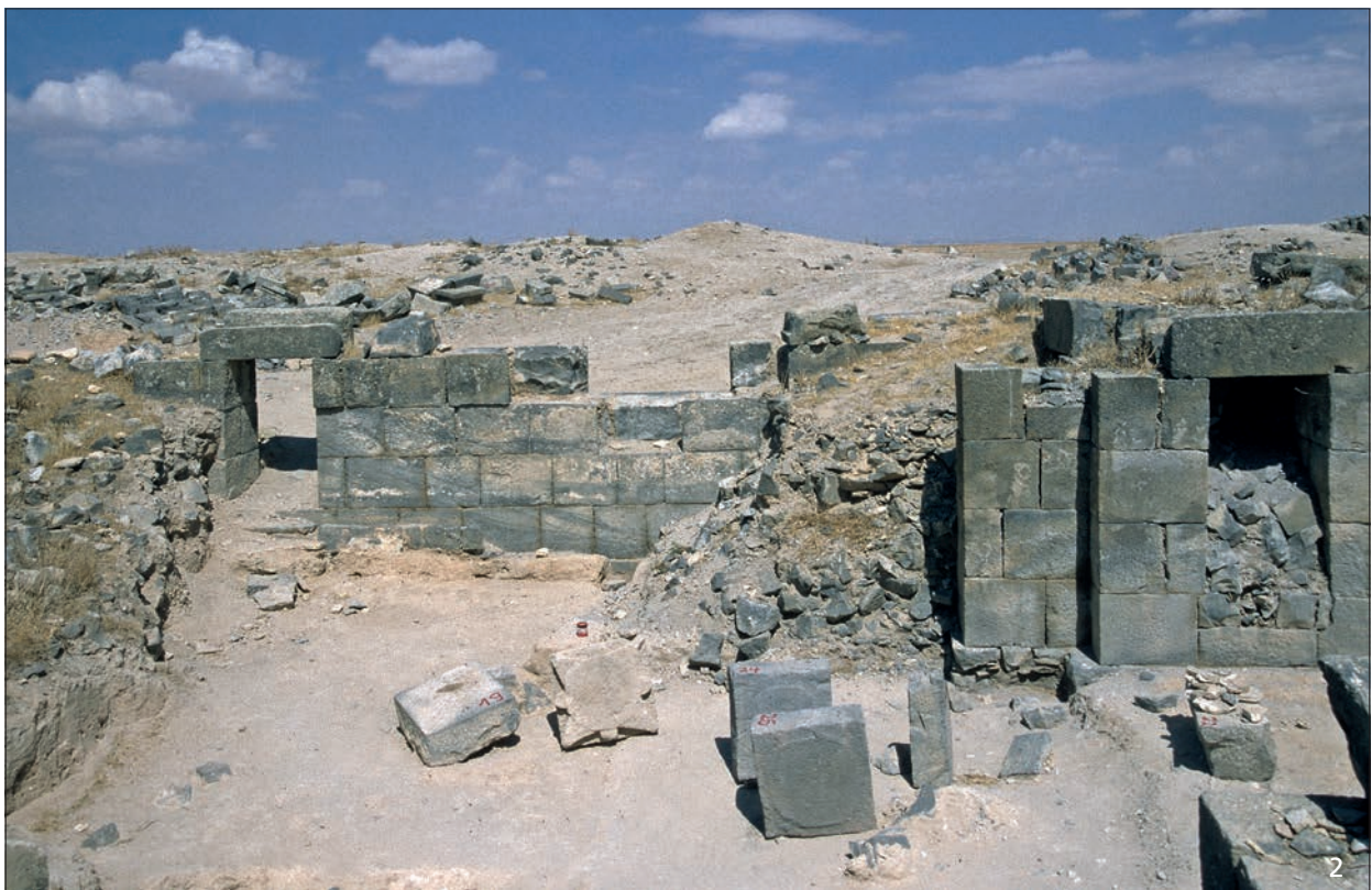
Kirche im Kastronhof: 1 Detail der östlichen Außenwand. – 2 Nordteil des Innenraums von Südosten aus.
