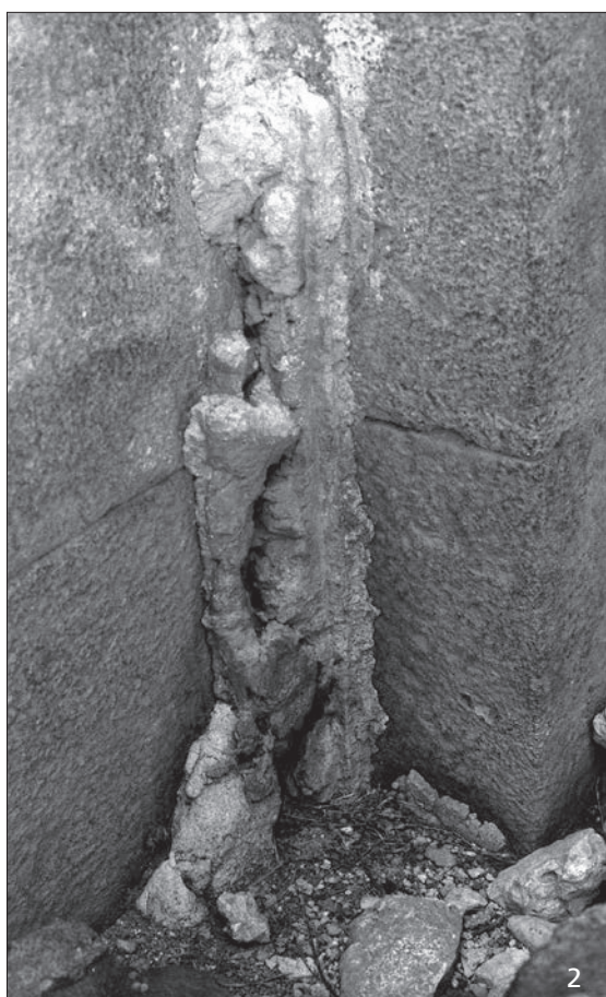
1-2 Qasr ibn Wardan, Kirche: 1 Montage von Inkrustationsplatten, Rest von Marmorplatte und Mörtelschicht; 2 Reste von Mörtel aus der Montage von Wandplatten. – 3 Androna, Kastronkirche: Montage von Inkrustationsplatten, Rest von Kalksteinplatte und Mörtelschicht.
