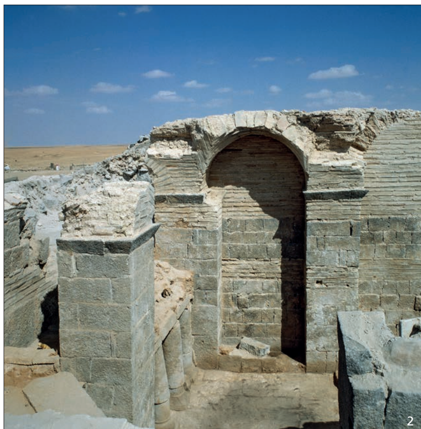
Kastron, Südhalle: 1 Südwestteil mit Blick in den Südwestturm. – 2 Nordseite. Pfeiler mit Gewölbeansätzen und Sekundärmauer auf dem Wehrgang.
