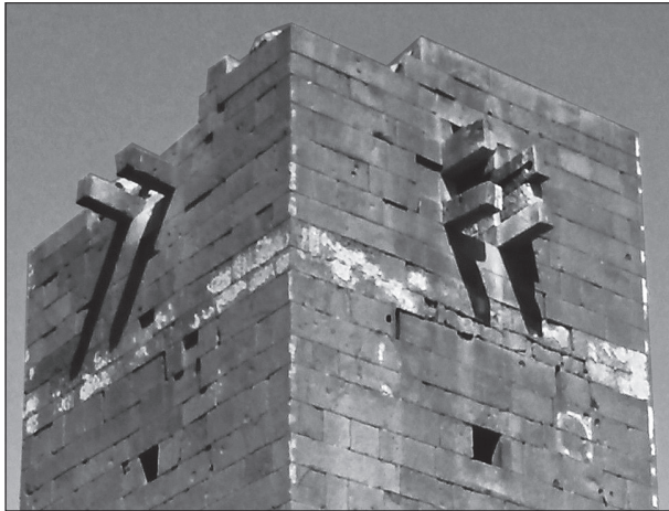
Abb. 55 Umm al Ġimal: Balken von Pechnase und Latrine.
