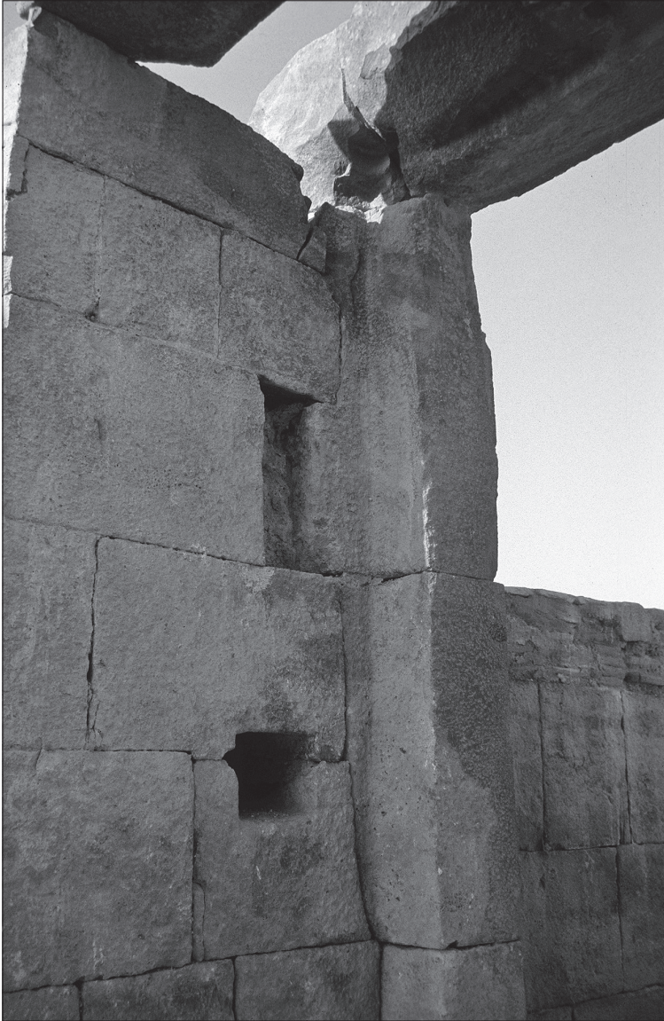
Abb. 37 Androna, Kastros: Westtor, Seiten- gewände mit Vorrichtung für Türbalken.
