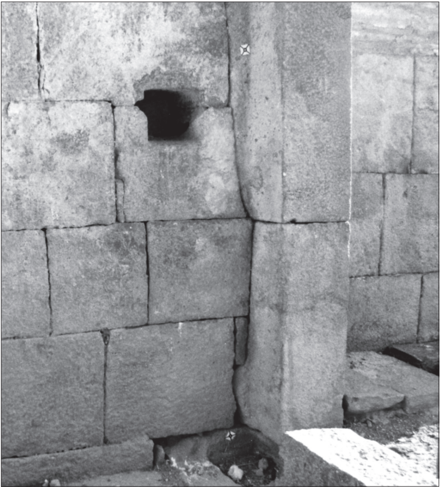
Abb. 36 Androna, Kastron: Westtor, südliches Seitengewände mit Türangelloch.
