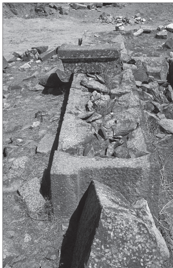
Abb. 23 a Bouz al Hanzir: Mauertechnik der Basaltregionen; b Androna, Kastron: Kirche im Kastronhof, Mauertechnik der Westfassade.
